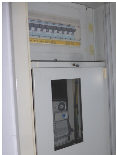
Zähler- und Sicherungskasten
