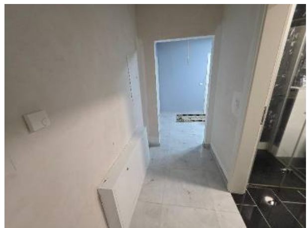
Bild 40 – Flur und Heizungssteuerung
