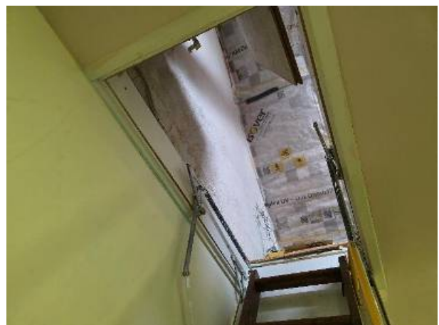
Bild 30 – Zwischensparrendämmung
