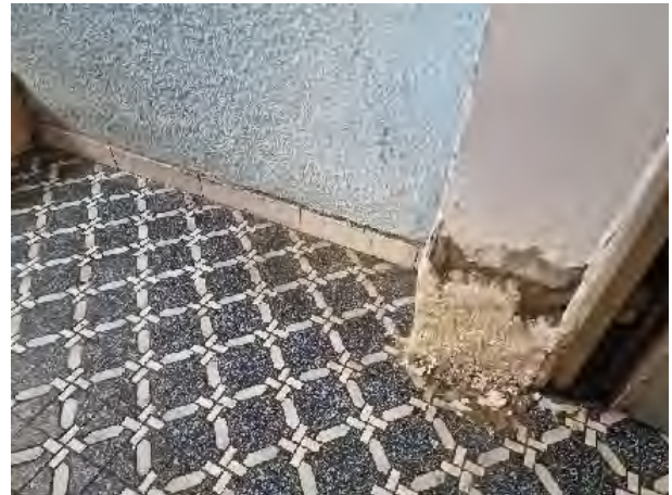
Bild 40 – Beschädigter Sockel
