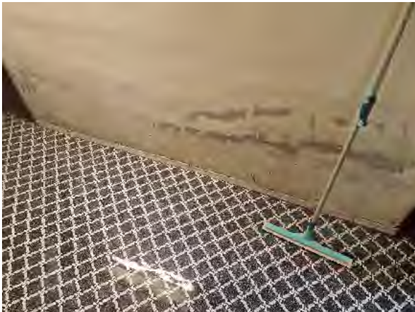
Bild 39 – stehendes Wasser und feuchte Wand im Flur
