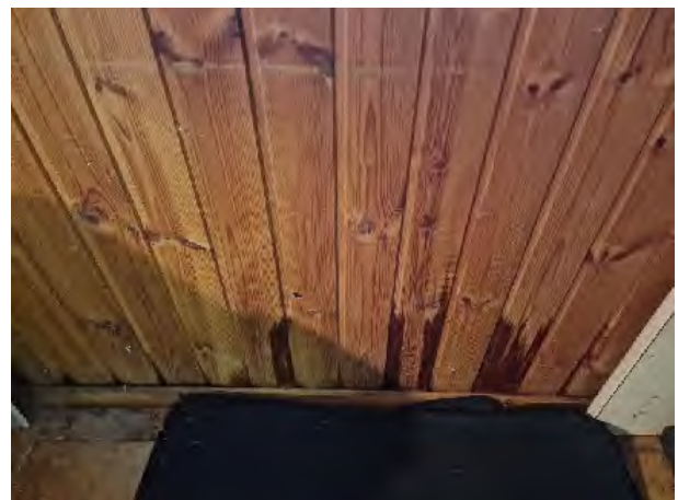
Bild 42 – Aufgequollene Holzverkleidung
