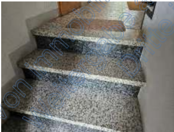
Treppe zum Dachgeschoß
