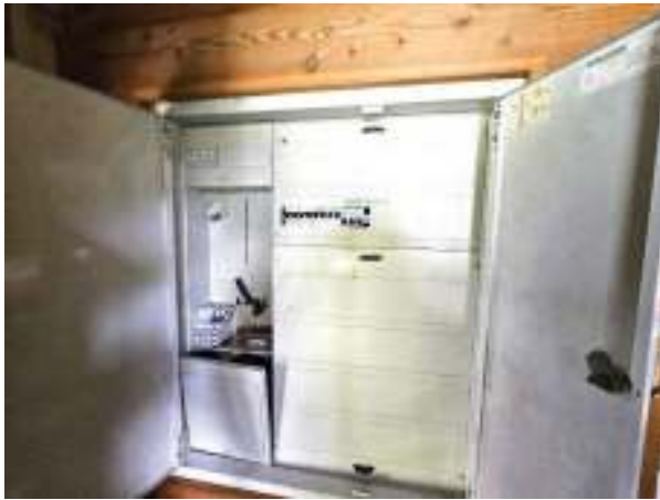
Stromzählerplatz, Stromzähler ausgebaut
