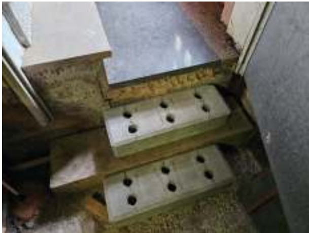
Zugang zum Dachgeschoß, Obergeschoß
