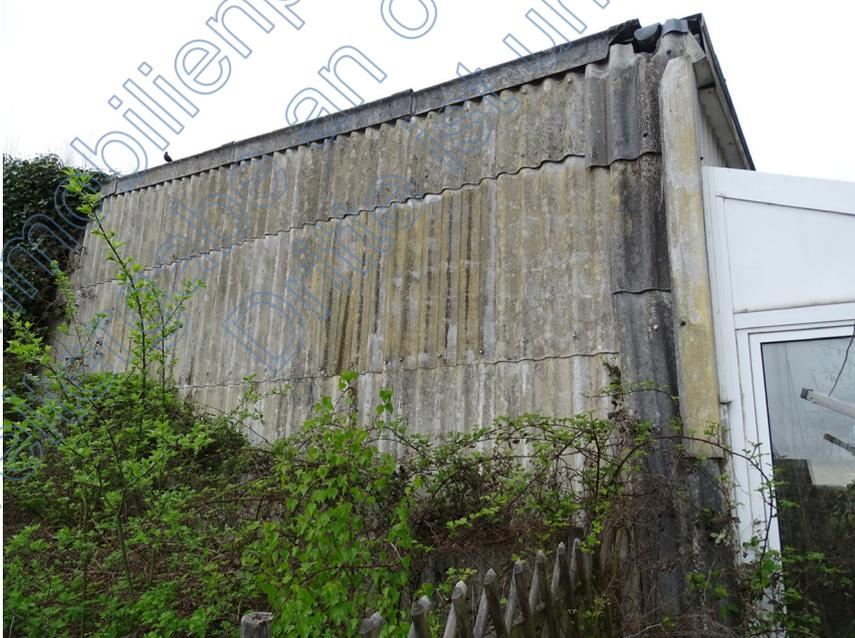
Bild 8: Marode Fassadenverkleidung und Dacheindeckung aus Welleternit (vermutlich asbesthaltig)
