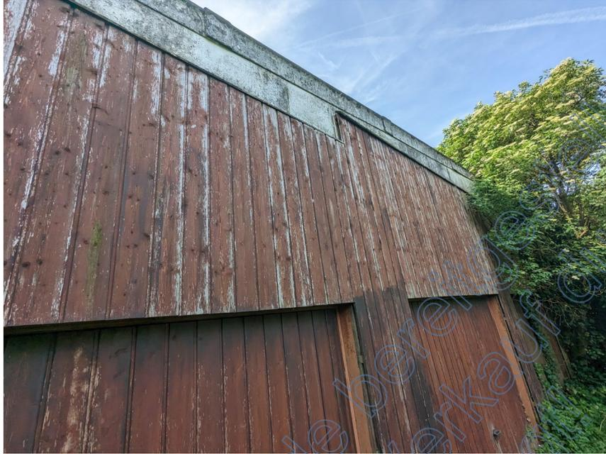
Bild 5: Fassadenholz der Lagerhalle verwittert
