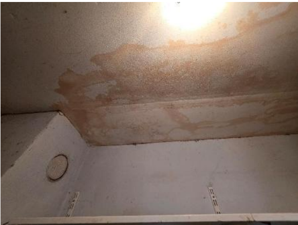
Bild 19 – Rückstände Wasserschaden
