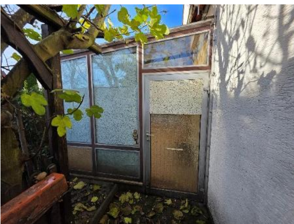
Bild 11 – Zugang Wintergarten von außen
