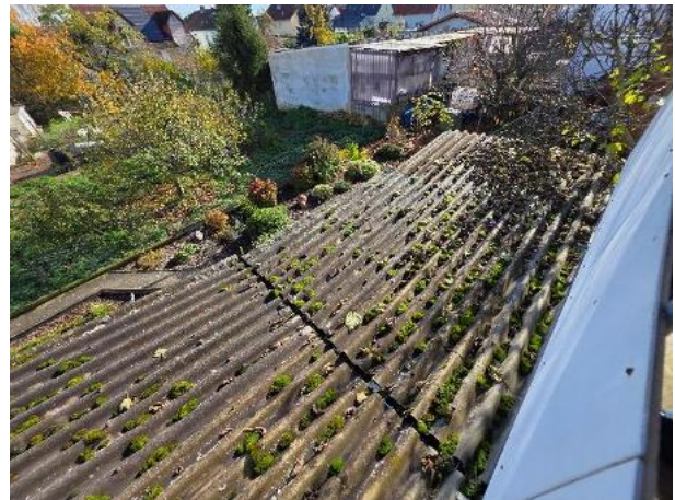
Bild 14 – Außenüberdachung, Asbestverdacht
