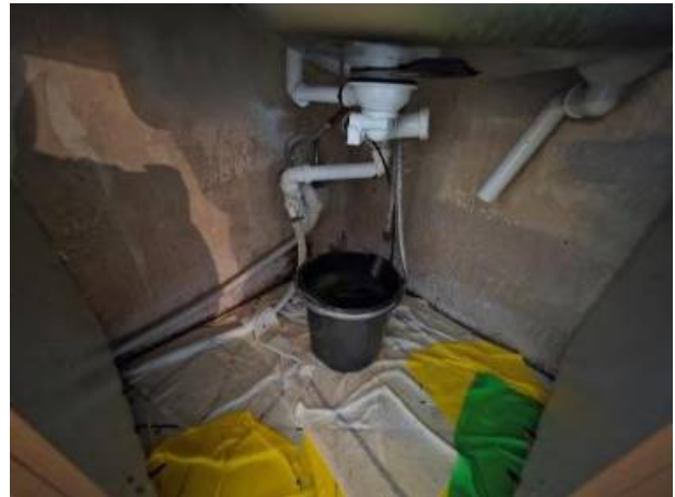
Bild 20 – Undichtes Waschbecken
