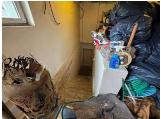
Bild 46 – Kellerabgang aus der Garage
