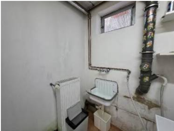
Bild 25 – Feuchte Kellerwände
