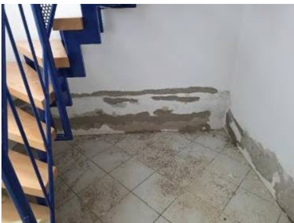
Bild 29 – Feuchtigkeitsrückstände
