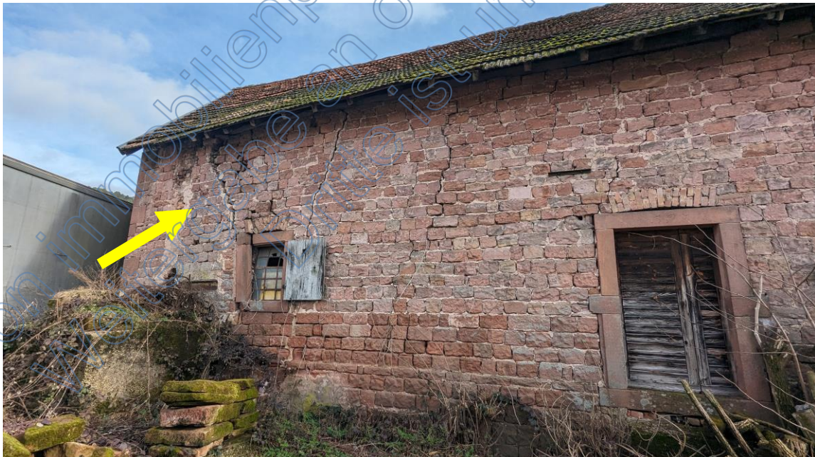
Bild 8: Ausbrechende Sandsteinwand
