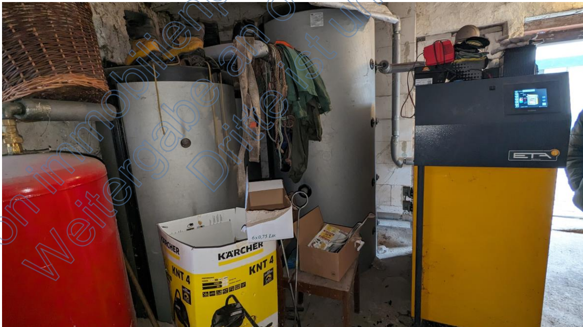
Bild 10: Holzheizung mit Pufferspeicher
