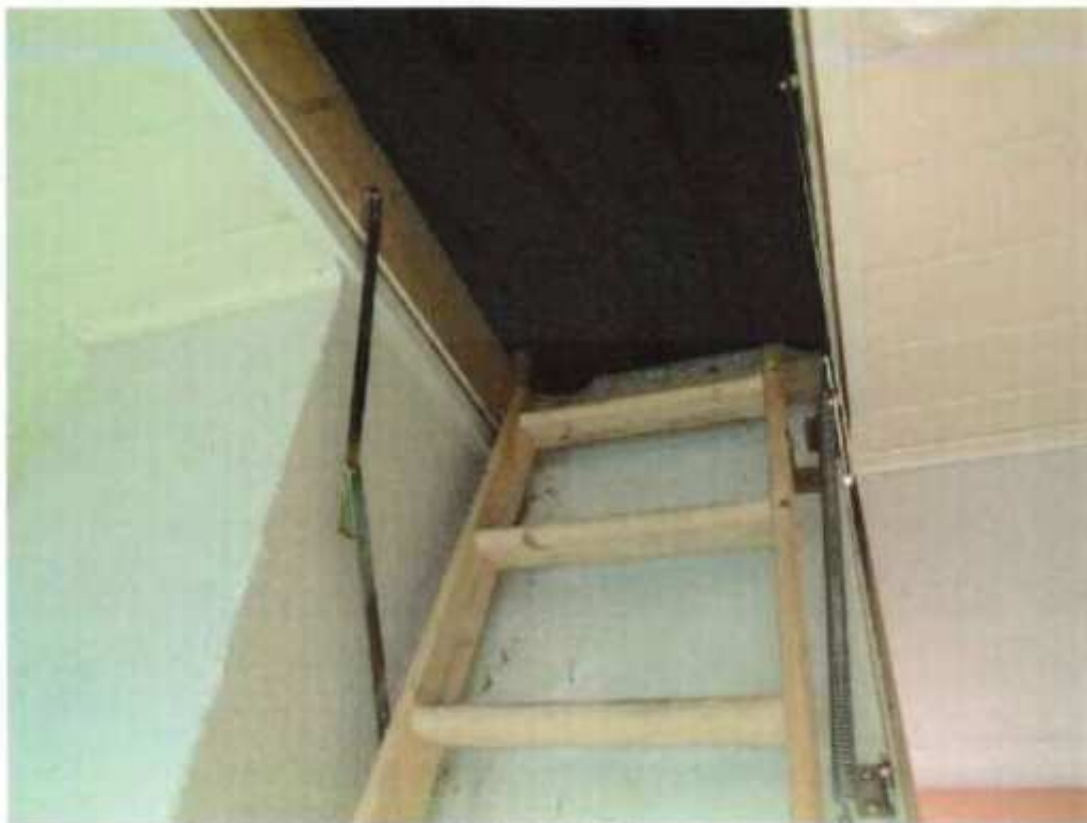
Zugang 1 zum Dach (im Eingangsbereich/WF)
