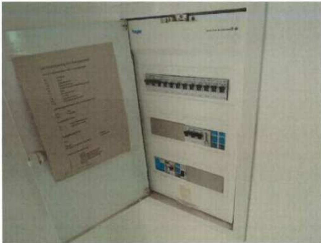
Sicherungskasten
