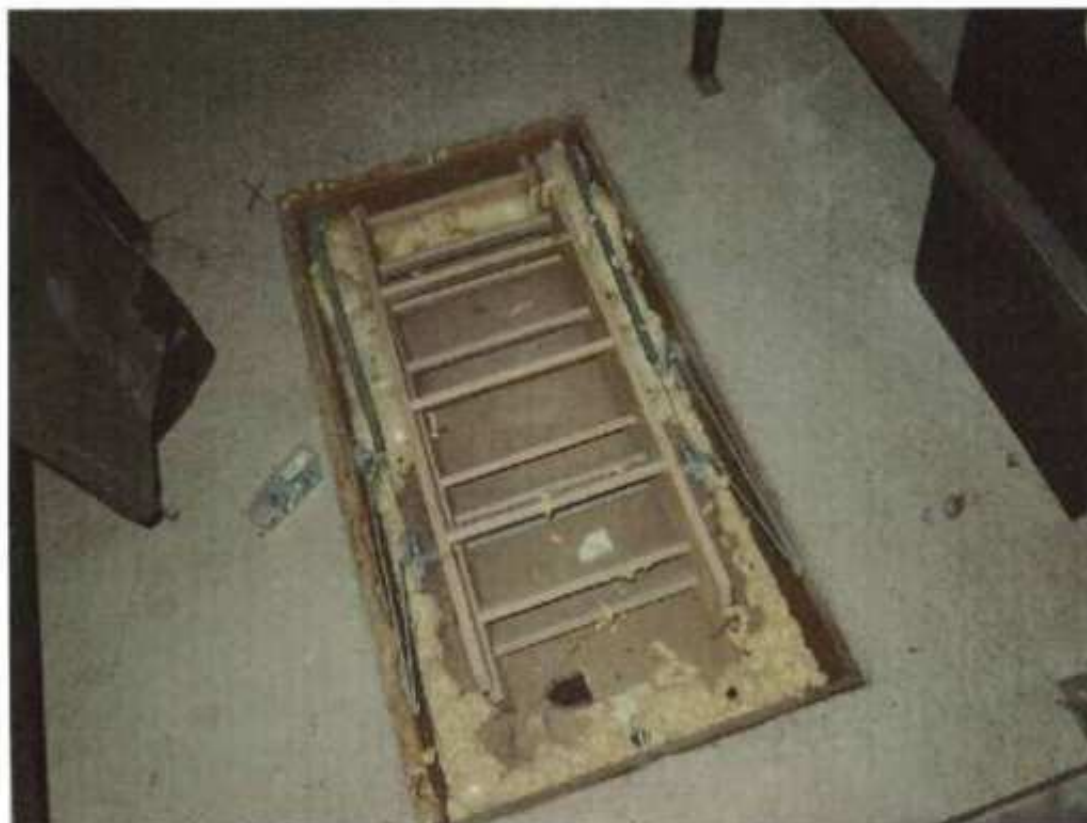
Zugang 2 zum Dach (über Wohnung 2)
