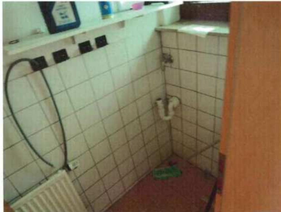
WC / Waschraum (im EG außerhalb der Wohneinheit)
