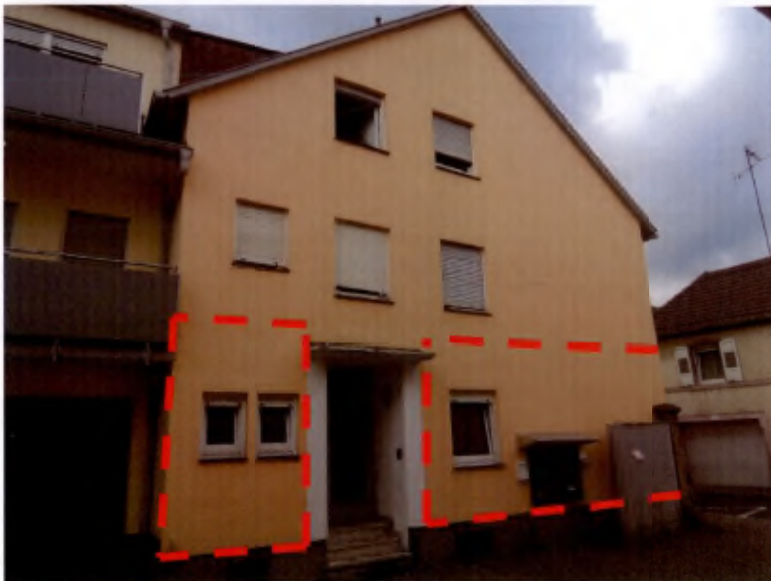
WE 1 rot markiert, Bad links vom Eingang (außerhalb der Wohnung)
