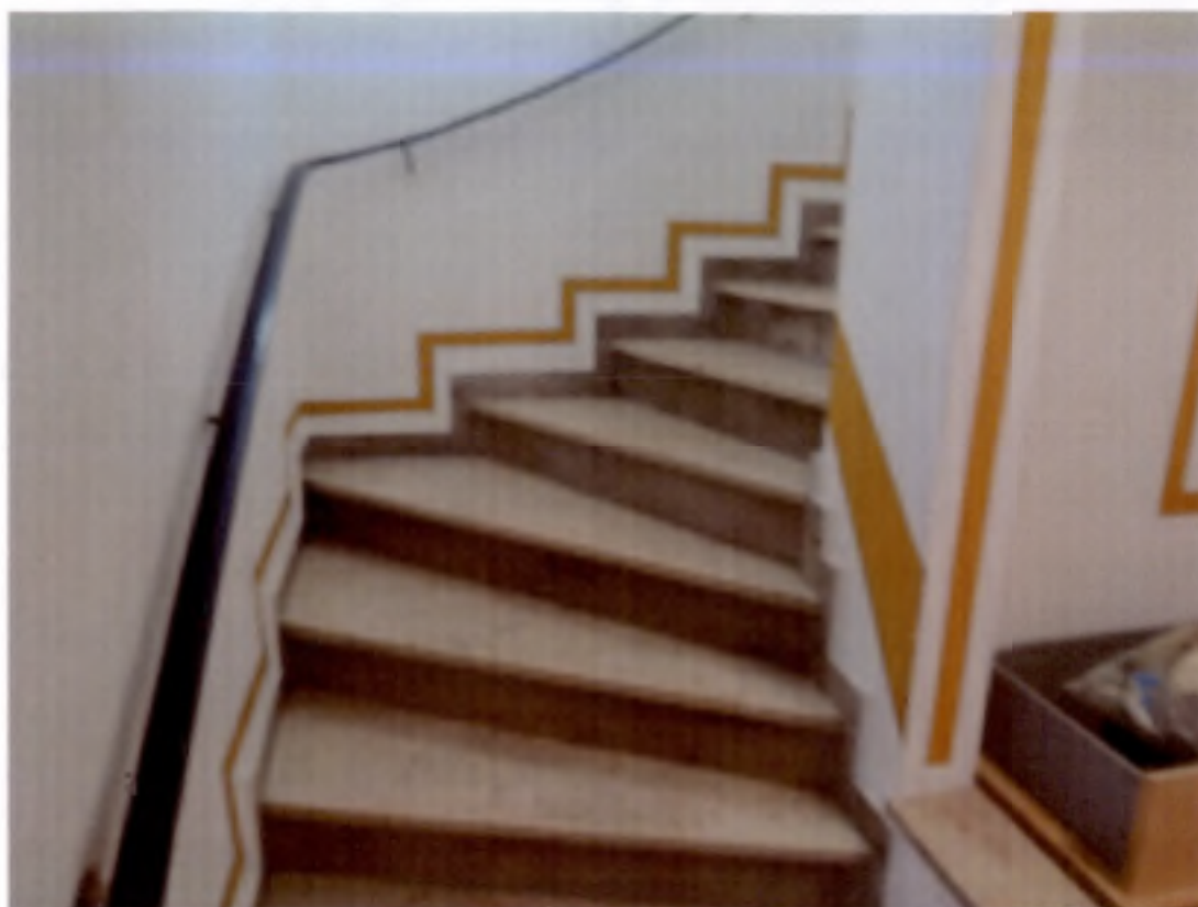
Treppenaufgang zum OG
