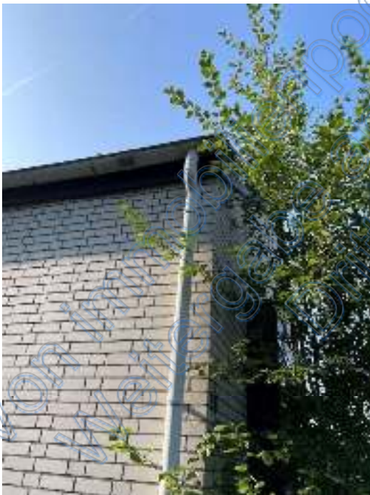
Regenfallrohr aus Kunststoff
