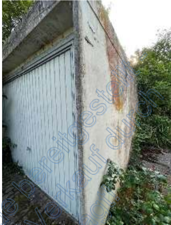
Garage, stellenweise Betonabplatzungen
