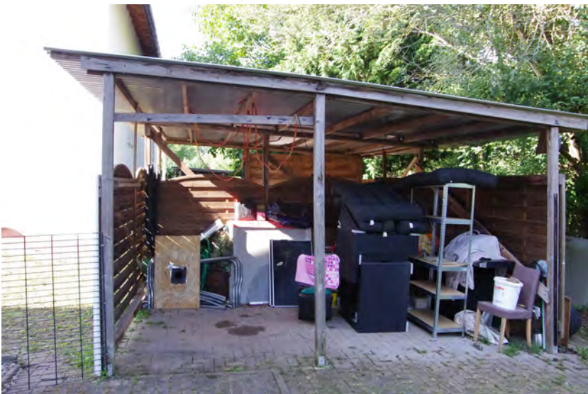
20 Carport Haus Nr. 7
