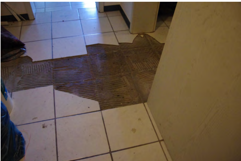
36 Beschädigte/fehlende Fliesenbeläge
