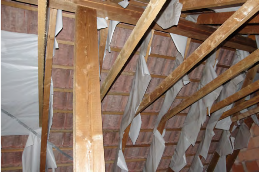
42 Beschädigte Unterspannbahn
