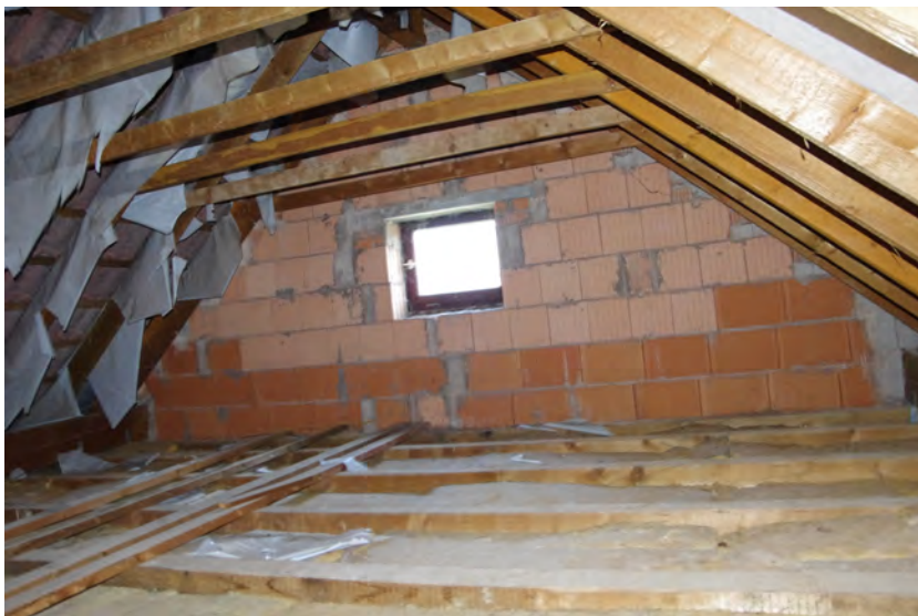
32 Blick in den Dachraum
