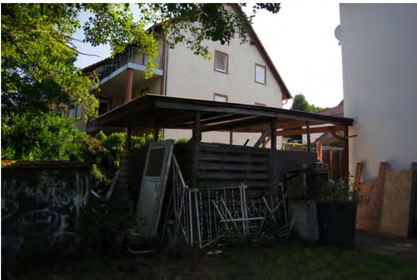
35 Carport Haus Nr. 7a
