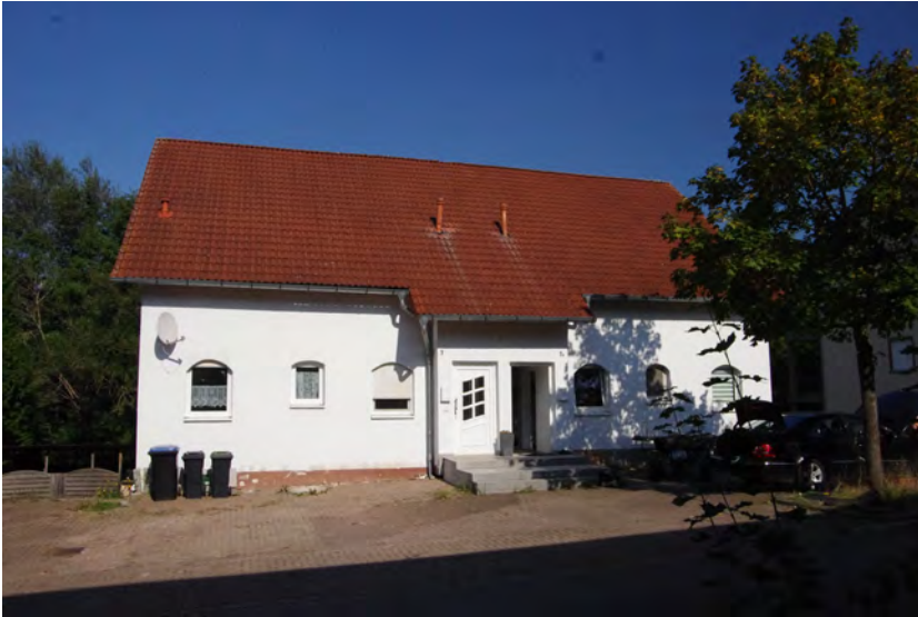
1 Straßenansicht von der Straße „In den Dörrwiesen“ (von Süden)
