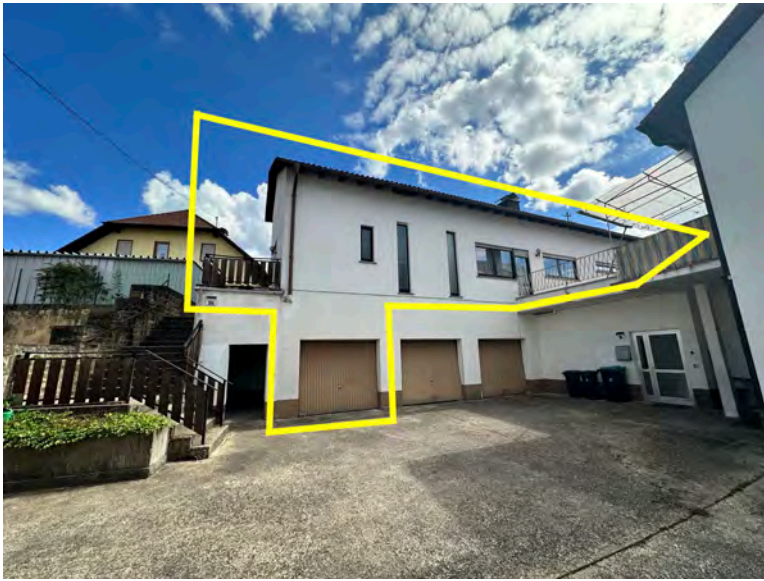
1 Straßenansicht Haus Nr. 57A (Sondereigentum Nr. 1)
