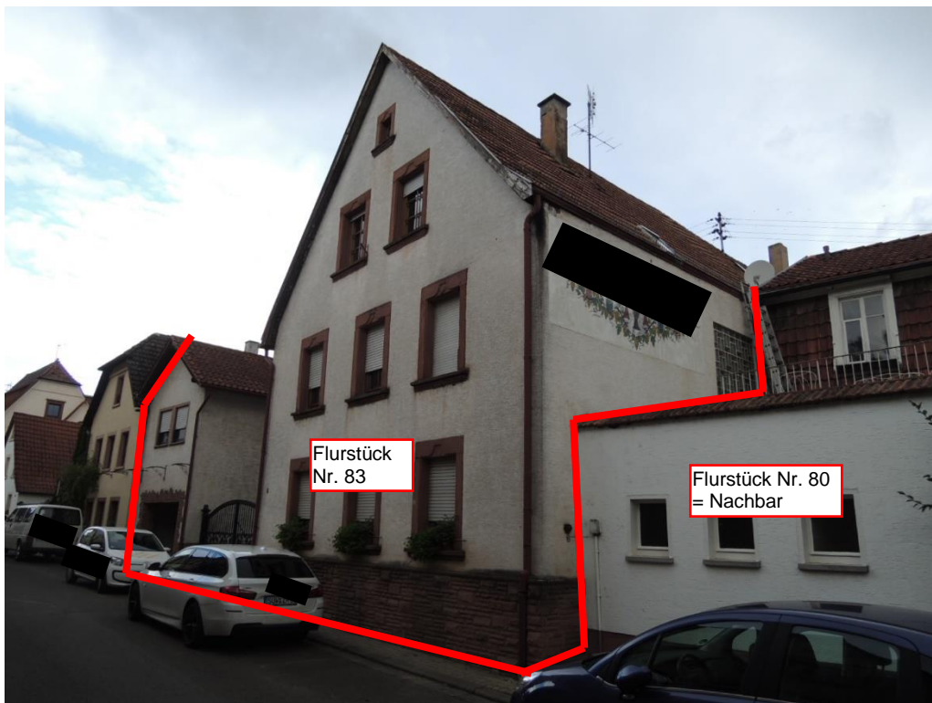
Weingut, Straßenansicht Hauptstraße 6, 76833 Walsheim
