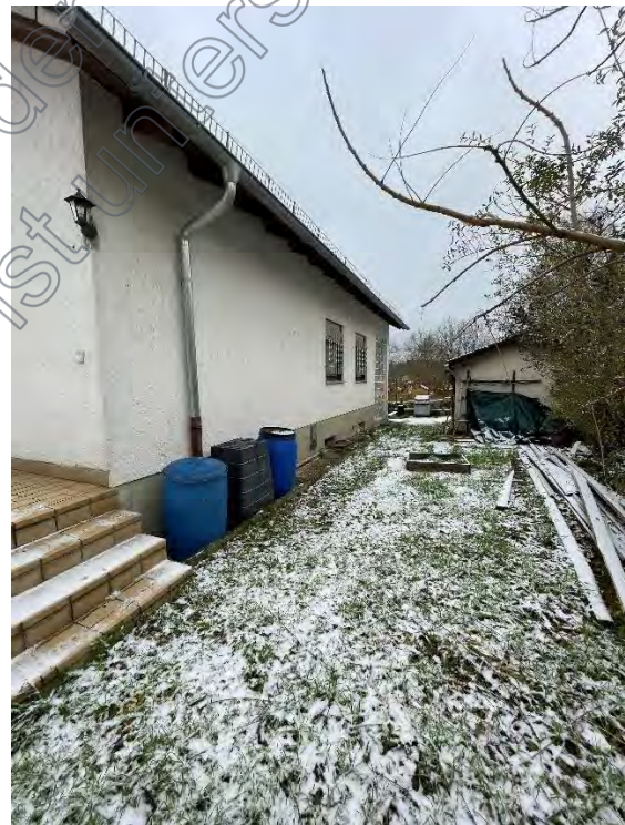
Rückansicht mit Saunagebäude
