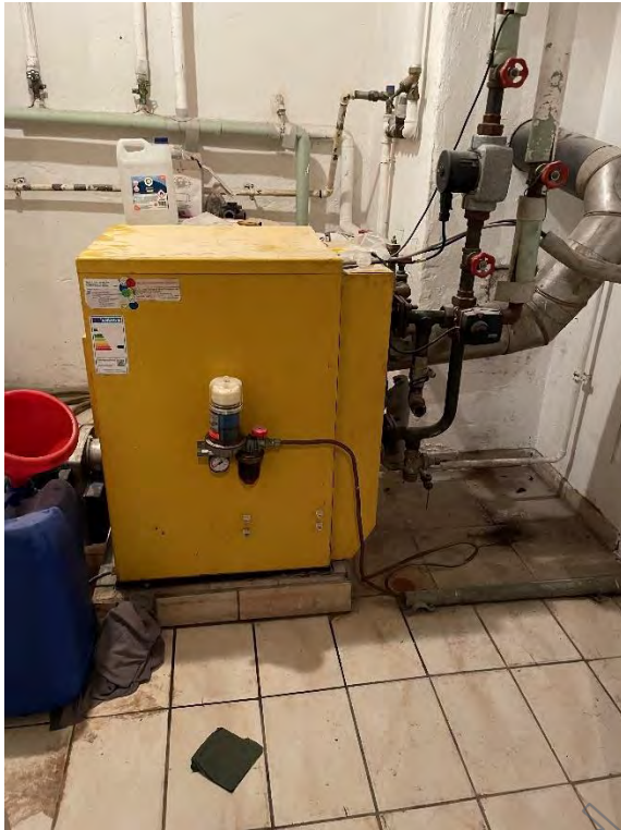
Heizungsanlage (Öl- Zentralheizung)
