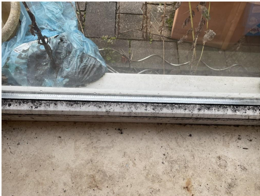
Bild 14: Großflächiger Schimmelbefall
