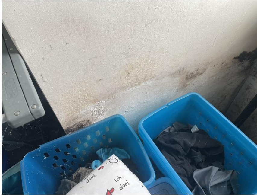
Bild 13: Beispiel für Feuchtigkeitsschaden EG
