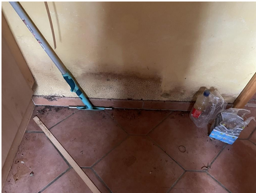
Bild 12: Beispiel für Feuchtigkeitsschaden EG
