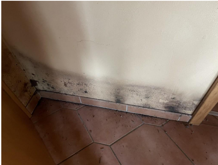
Bild 11: Beispiel für Feuchtigkeitsschaden EG
