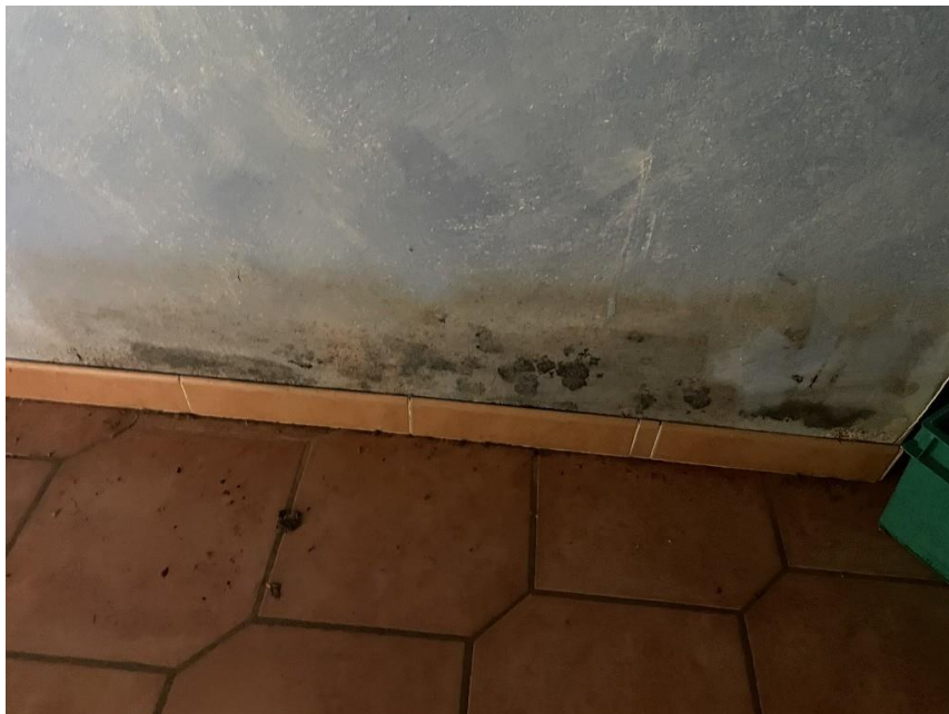
Bild 10: Beispiel für Feuchtigkeitsschaden EG
