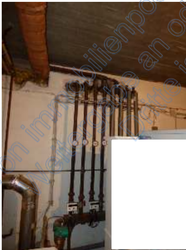
Bild 12: ungedämmte wärmeführende Leitungen
