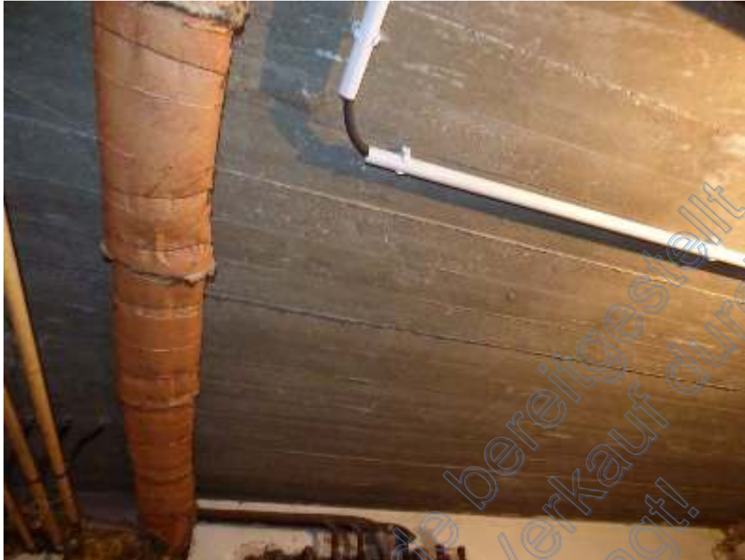
Bild 13: ungedämmte Kellerdecke
