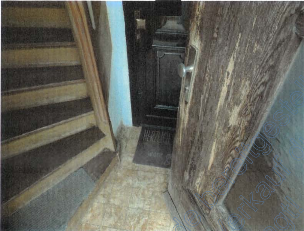
Treppenhaus und Eingangstür Wohnung im EG
