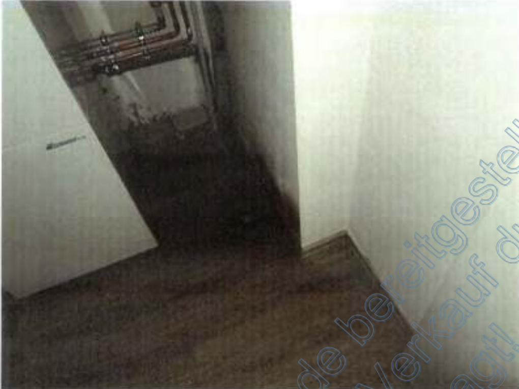
Nach Auskunft der Hausverwaltung: Fleckenbildung durch Undichtigkeit eines Entlüftungsrohres im Deckenbereich.
