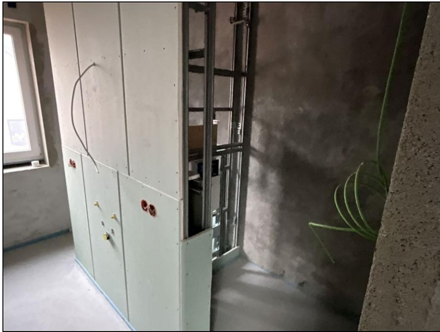
Foto Nr.: 5 Dusche im Badezimmer DG
