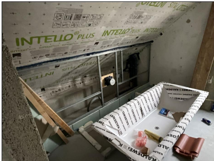
Foto Nr.: 7 Badzimmer im DG
