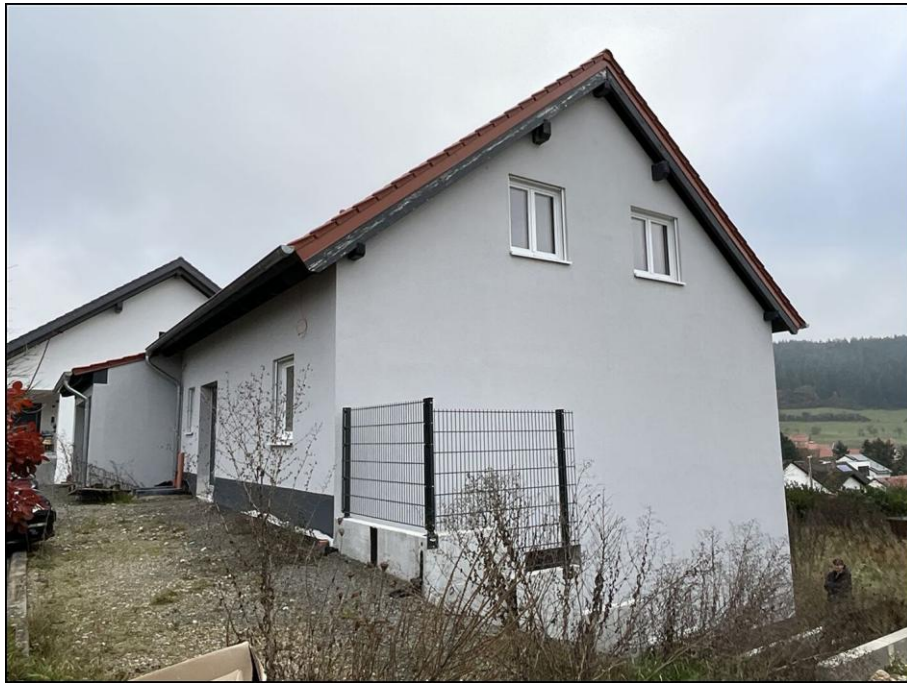
Foto Nr.: 3 Straßenansicht Blick nach Südosten
