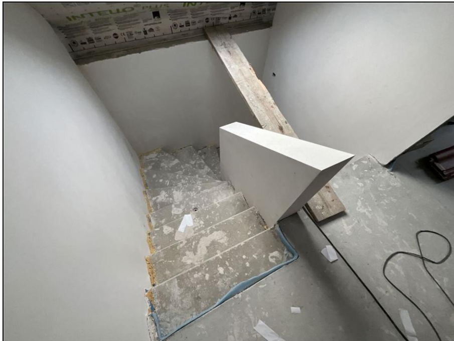
Foto Nr.: 11 Blick ins Treppenhaus
