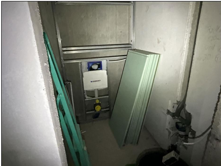
Foto Nr.: 6 WC im UG
