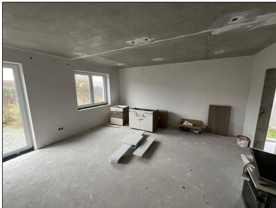
Foto Nr.: 8 Blick ins Wohnzimmer der Einliegerwohnung
