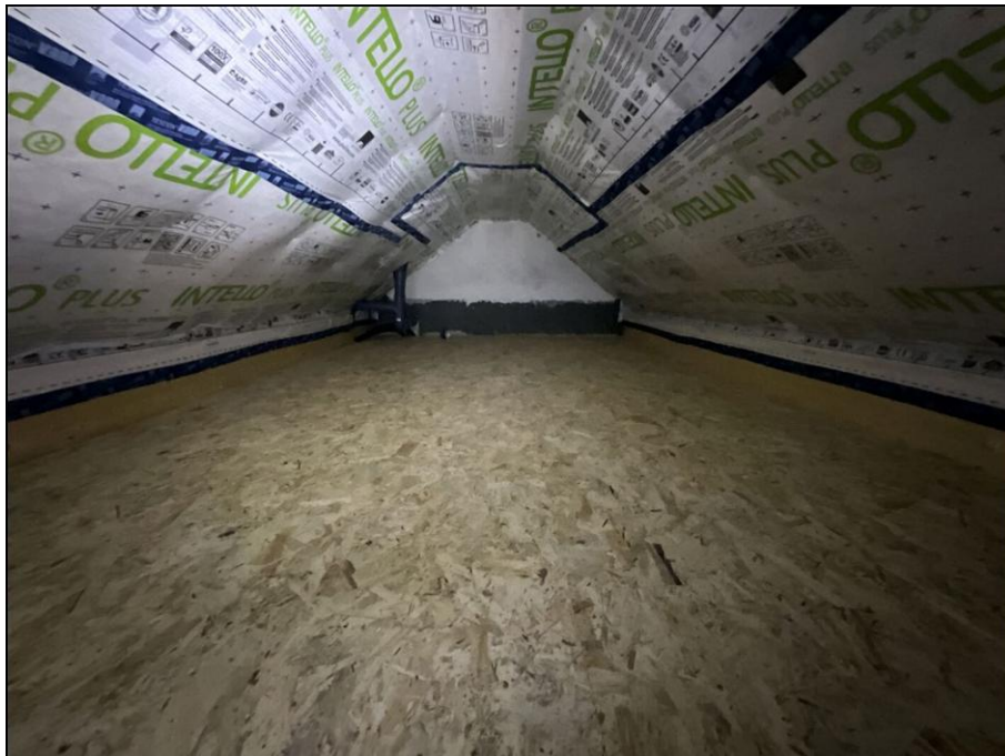
Foto Nr.: 12 Blick in den Spitzboden
