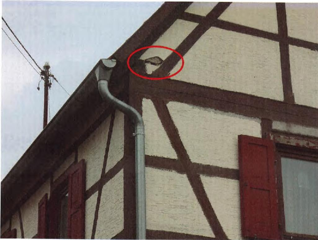
Schäden an der Fassade, Holzelemente teilweise verwittert
