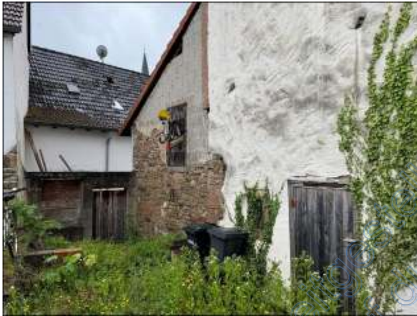
Bild-Nr. 5 erstellt am: 04.06.2025 Rechts Gebäude Enggasse 8; im Hintergrund Rückseite Am Ring 13
