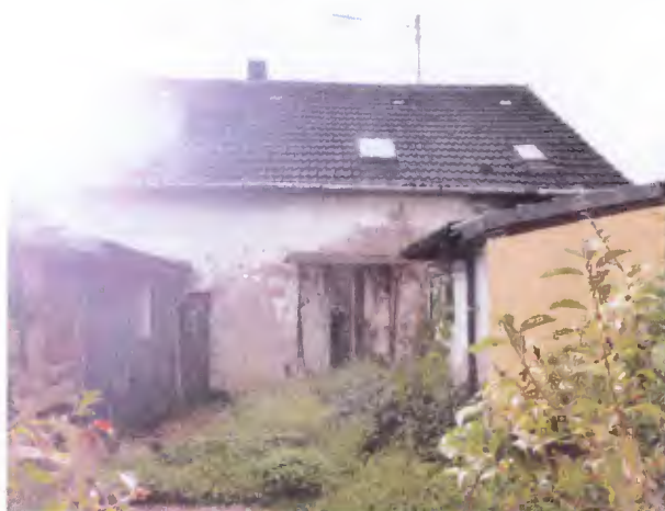
Bild 2: Wohnhaus mit Anbau: rückwärtige Ansicht
