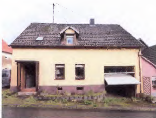
Bild 1+: Ansicht Wohnhaus mit Garage zur Straße hin
