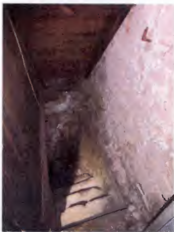
Bild 5: Wohnhaus Treppenzugang zum Keller
