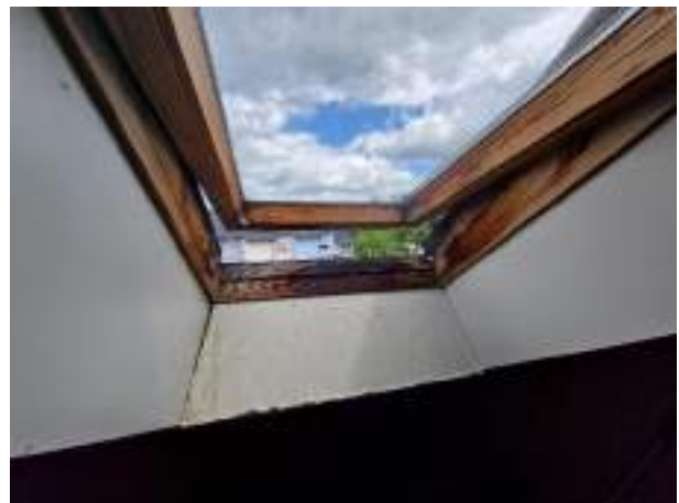
Bild 48 – Feuchteschaden (DG)
