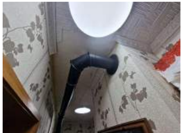
Bild 40 – Provisorische Konstruktion im Flur (EG)
