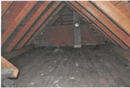
Wohngebäude / Dachboden Zubau
