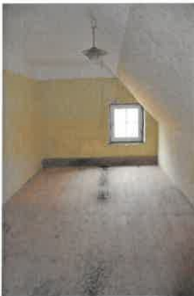
Wohngebäude 2. OG / Südost-Zimmer
