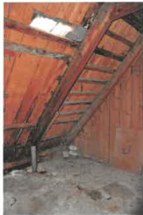
Wohngebäude 2. OG / Stiegenhaus / Flur
