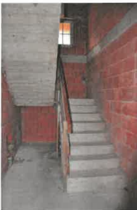
Wohngebäude / Zubau EG / Vorraum Stiegenhaus
