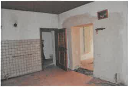
Wohngebäude EG / Küche
