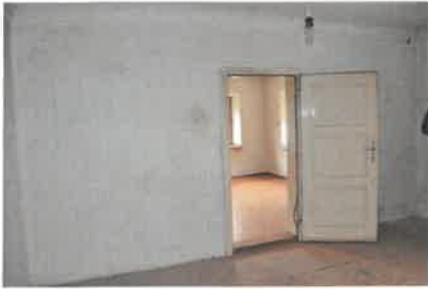
Wohngebäude 1. OG / Kabinett
