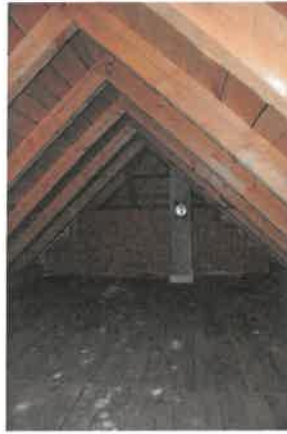
Wohngebäude / Dachboden Zubau
