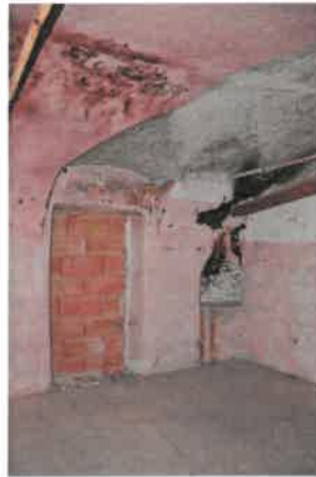
Wohngebäude 1. OG / Rauchküche
