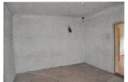
Wohngebäude 1. OG / Kabinett
