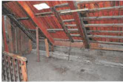
Wohngebäude 2. OG / Stiegenhaus / Flur
