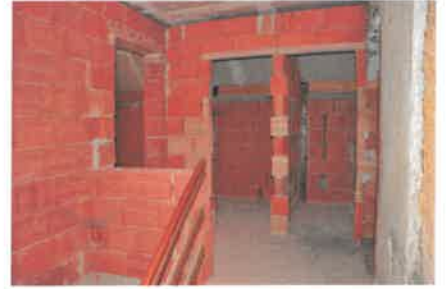
Wohngebäude / Zubau / Stiegenhaus / Aufgang OG
