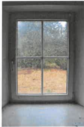
Wohngebäude EG / Blick Küchenfenster
