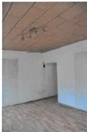
Wohngebäude EG / Schlafzimmer 2
