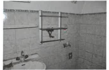
Wohngebäude EG / Badezimmer
