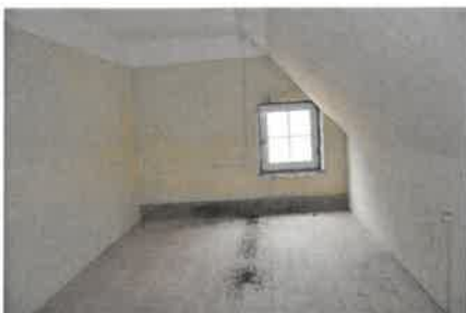
Wohngebäude 2. OG / Südost-Zimmer
