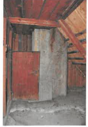
Wohngebäude 2. OG / Stiegenhaus / Flur
