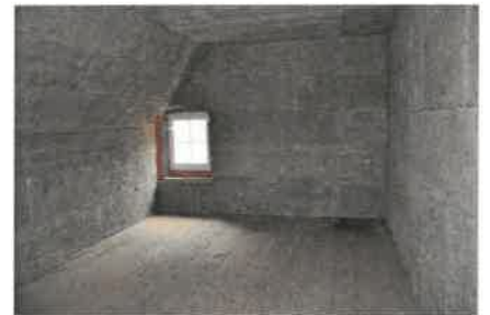
Wohngebäude 2. OG / Nordost-Zimmer
