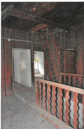
Wohngebäude 2. OG / Stiegenhaus / Flur
