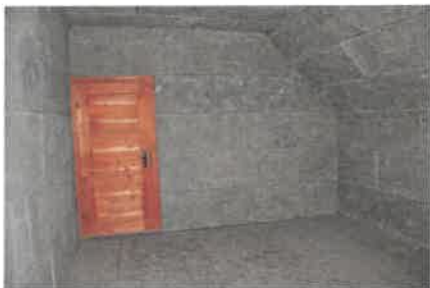
Wohngebäude 2. OG / Nordost-Zimmer
