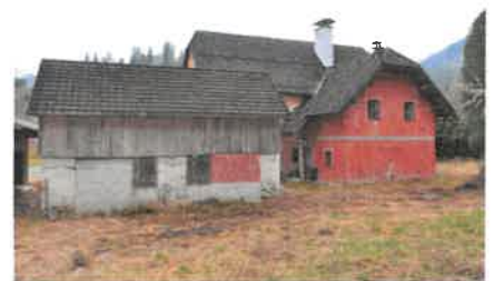
Außenanlage / Nordseite / Neben- & Wohngebäude
