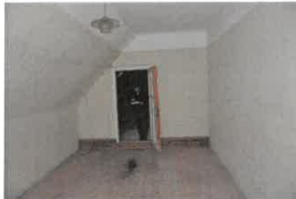
Wohngebäude 2. OG / Südost-Zimmer
