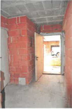
Wohngebäude / Zubau EG / Vorraum Stiegenhaus
