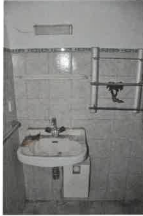
Wohngebäude EG / Badezimmer
