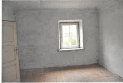
Wohngebäude 1. OG / Kabinett
