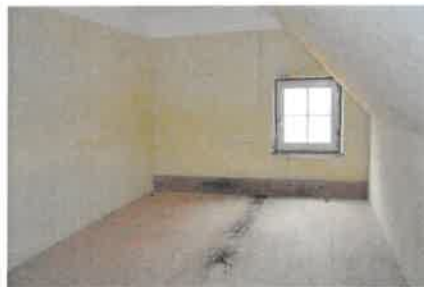
Wohngebäude 2. OG / Südost-Zimmer
