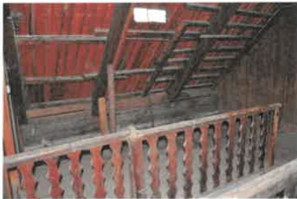
Wohngebäude 2. OG / Stiegenhaus / Flur
