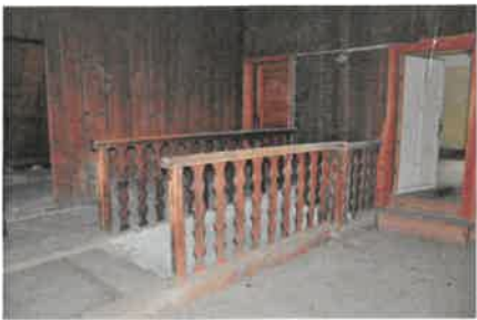
Wohngebäude 2. OG / Stiegenhaus / Flur
