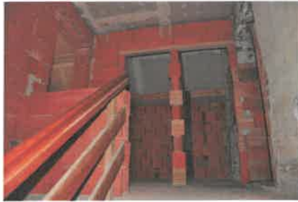
Wohngebäude / Zubau / Stiegenhaus / Aufgang OG
