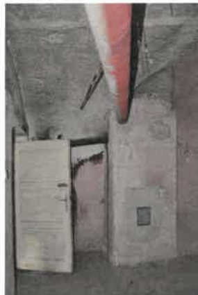
Wohngebäude 1. OG / Rauchküche
