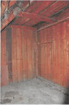
Wohngebäude 2. OG / Stiegenhaus / Flur
