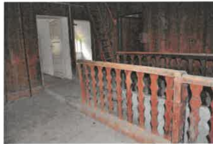
Wohngebäude 2. OG / Stiegenhaus / Flur
