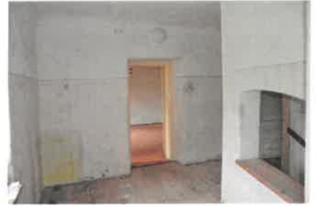
Wohngebäude 1. OG / Vorraum
