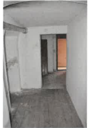
Wohngebäude EG / Flur
