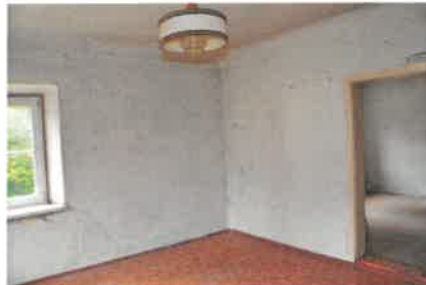
Wohngebäude 1. OG / Aufenthaltsraum
