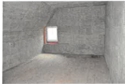
Wohngebäude 2. OG / Nordost-Zimmer
