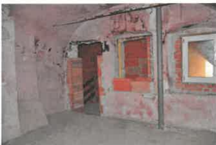
Wohngebäude 1. OG / Rauchküche
