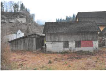
Außenanlage / Nordseite / Carport & Nebengebäude
