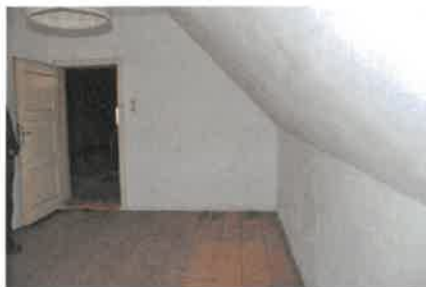
Wohngebäude 2. OG / Südwest-Zimmer
