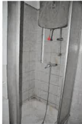
Wohngebäude EG / Badezimmer / Dusche
