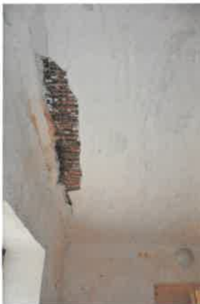
Wohngebäude 1. OG / Schilfmatten / Deckenputz
