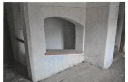
Wohngebäude 1. OG / Vorraum / Stiegenhaus
