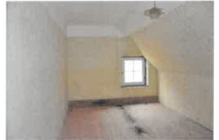
Wohngebäude 2. OG / Südost-Zimmer
