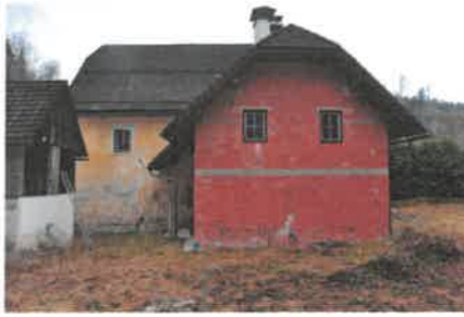
Außenanlage / Nordseite / Rohbau / Zubau
