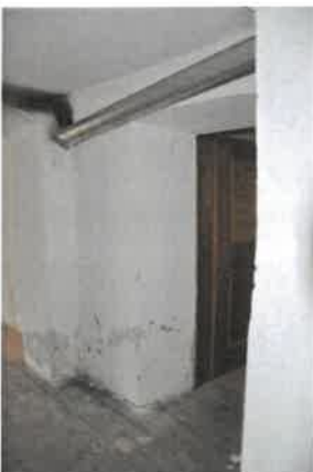
Wohngebäude EG / Flur
