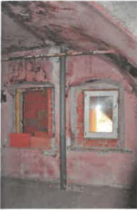
Wohngebäude 1. OG / Rauchküche
