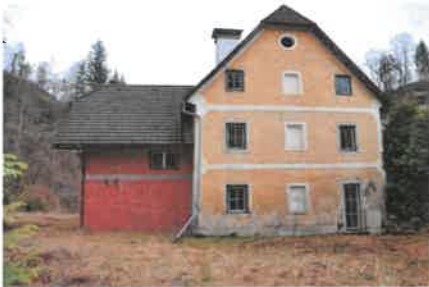
Wohngebäude / Fassade Westseite
