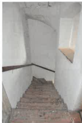
Wohngebäude 1. OG / Vorraum / Stiegenhaus
