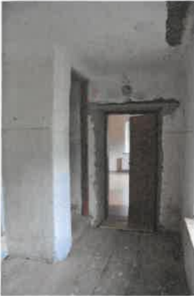
Wohngebäude 1. OG / Vorraum
