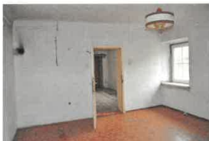
Wohngebäude 1. OG / Aufenthaltsraum
