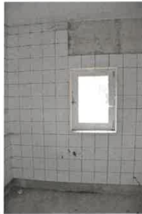
Wohngebäude / Zubau EG / Heizraum
