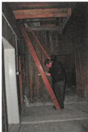
Wohngebäude 2. OG / Stiegenhaus / Flur
