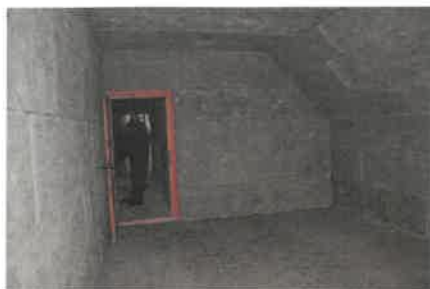
Wohngebäude 2. OG / Nordost-Zimmer
