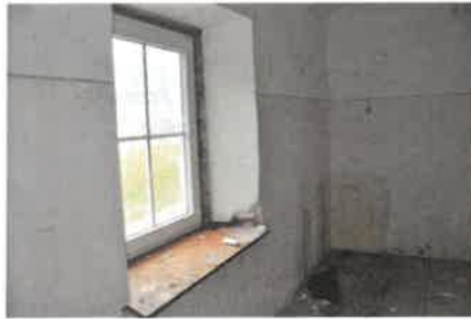
Wohngebäude 1. OG / Vorraum / Stiegenhaus
