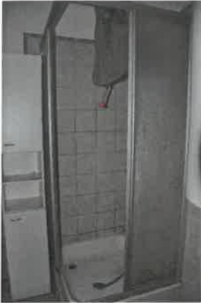
Wohngebäude EG / Badezimmer
