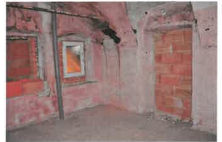
Wohngebäude 1. OG / Rauchküche
