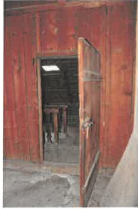
Wohngebäude 2. OG / Stiegenhaus / Flur
