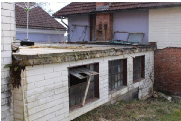
Ansicht ehem. Produktionsgebäude mit Dachterrasse
