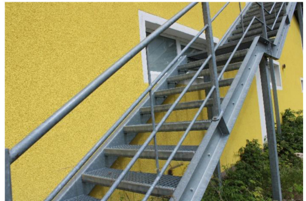
Außenstiege ins DG
