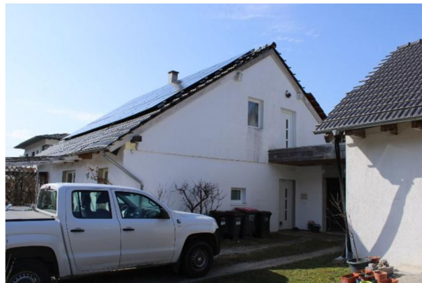
Wohnhaus Ansicht von Osten
