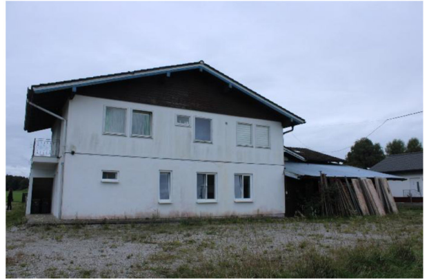
Wohnhaus Ansicht von Norden
