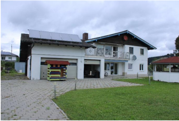
Wohnhaus mit Garagen, Ansicht von Süden
