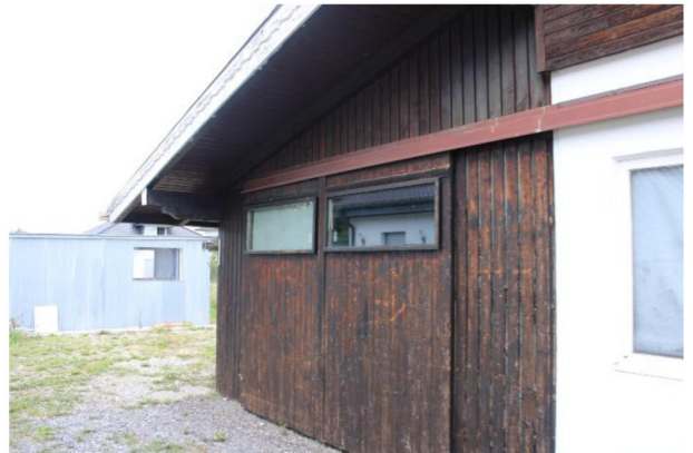
Ansicht Holzschuppen von Westen
