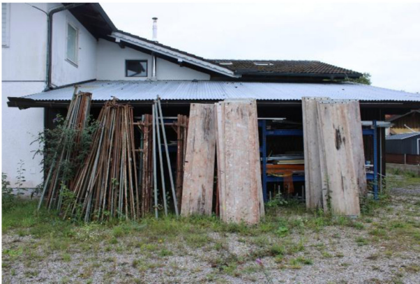
Ansicht von Holzschuppen von Norden
