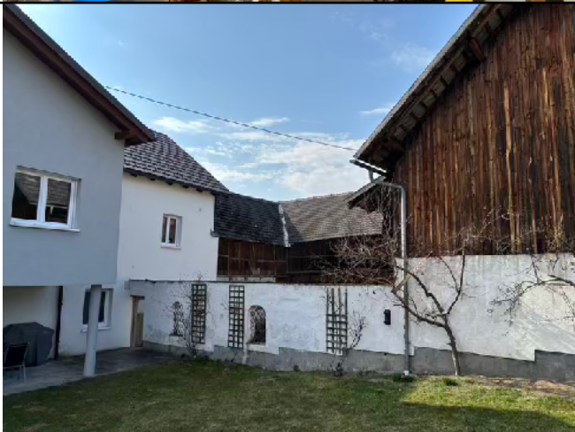
Ostansicht Wirtschaftstrakt Blickrichtung Westen
