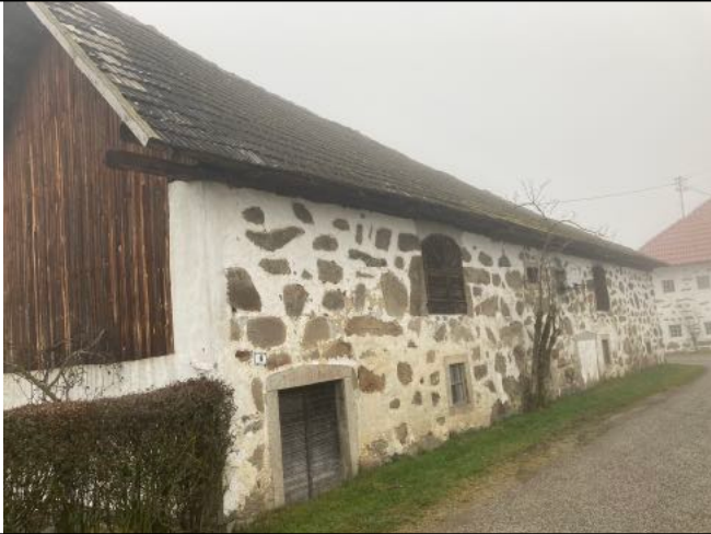
Blickrichtung Südwesten: OG aus Holzriegel
