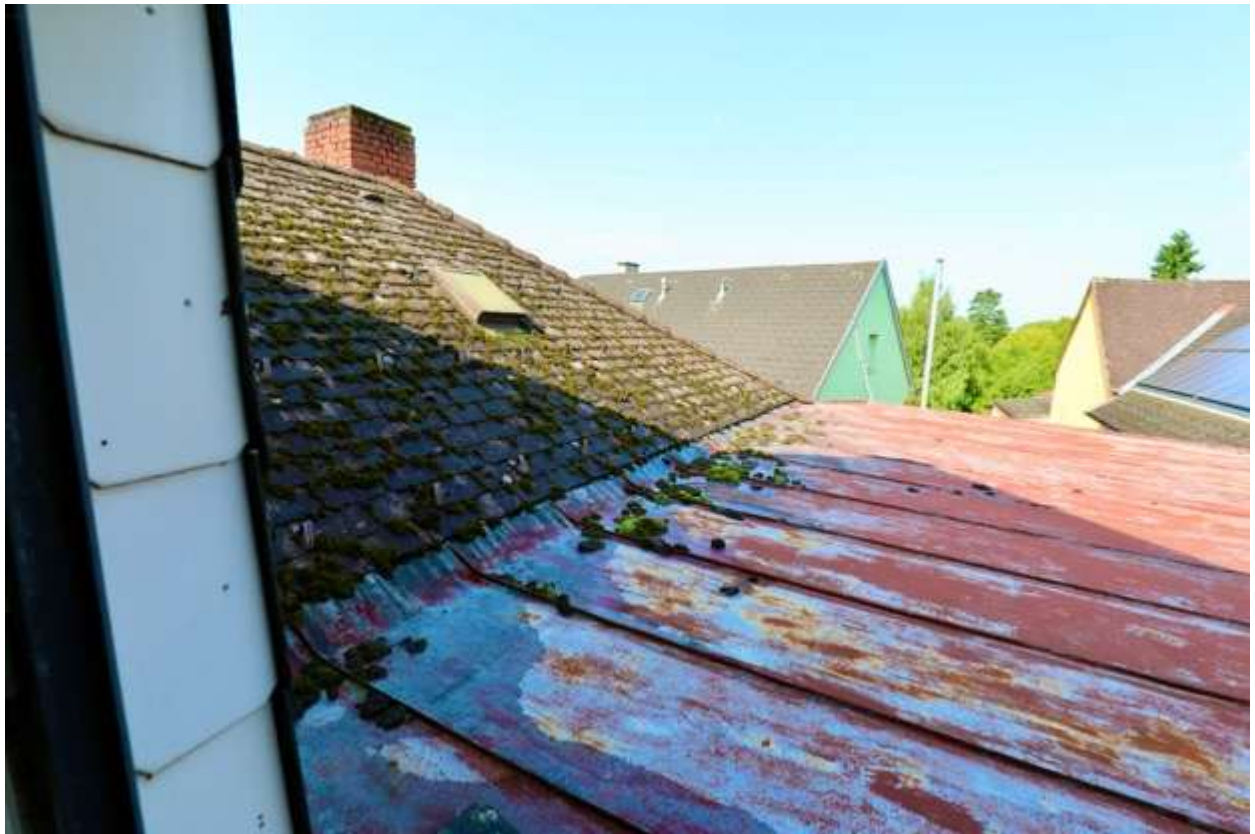
Dach ist zu sanieren; Schüttung teilweise schadhaft
