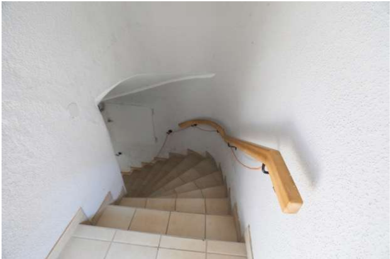
1.OG; Fertigstellungsarbeiten nach Baustopp eingestellt; 2. Handlauf fehlt
