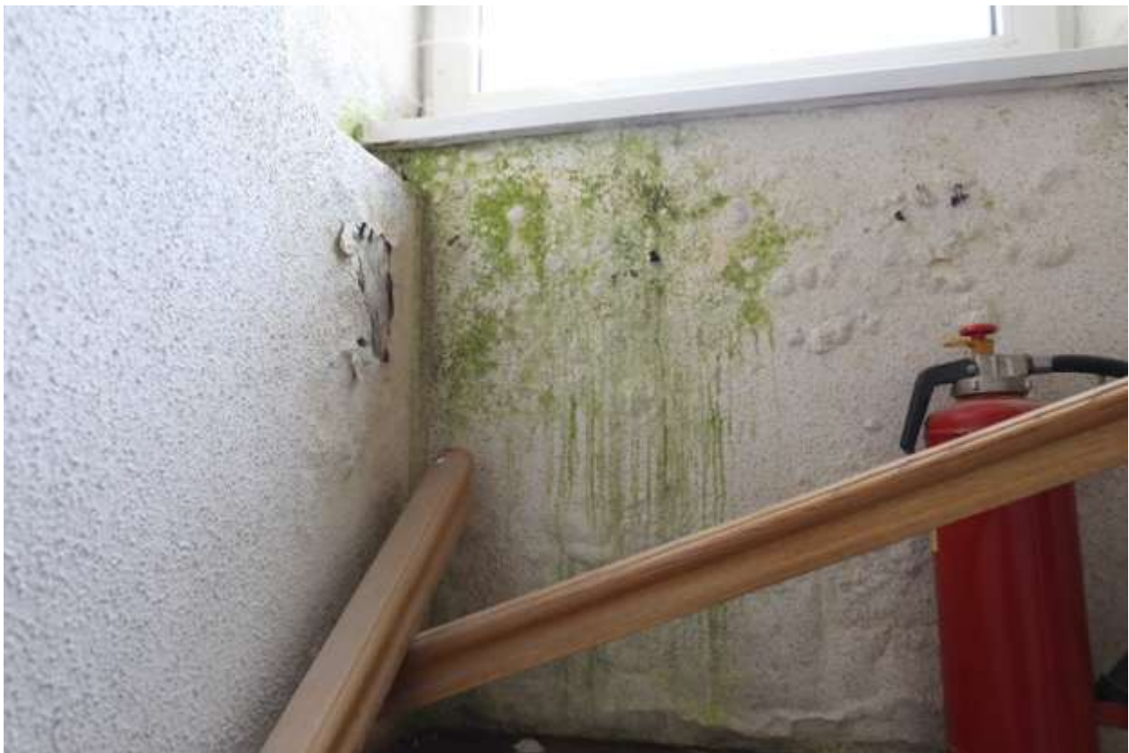
Massiver Wasserschaden im Stiegenhaus
