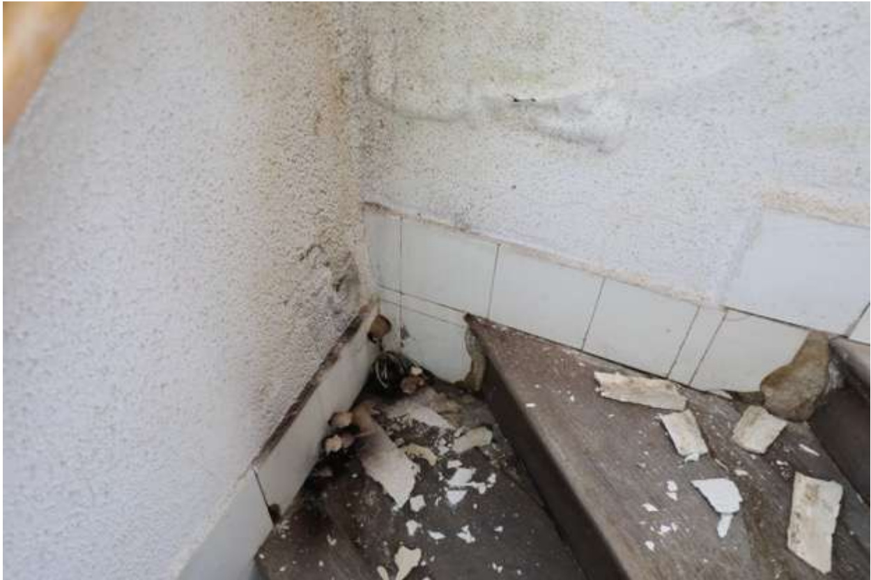
Massiver Wasserschaden im Stiegenhaus
