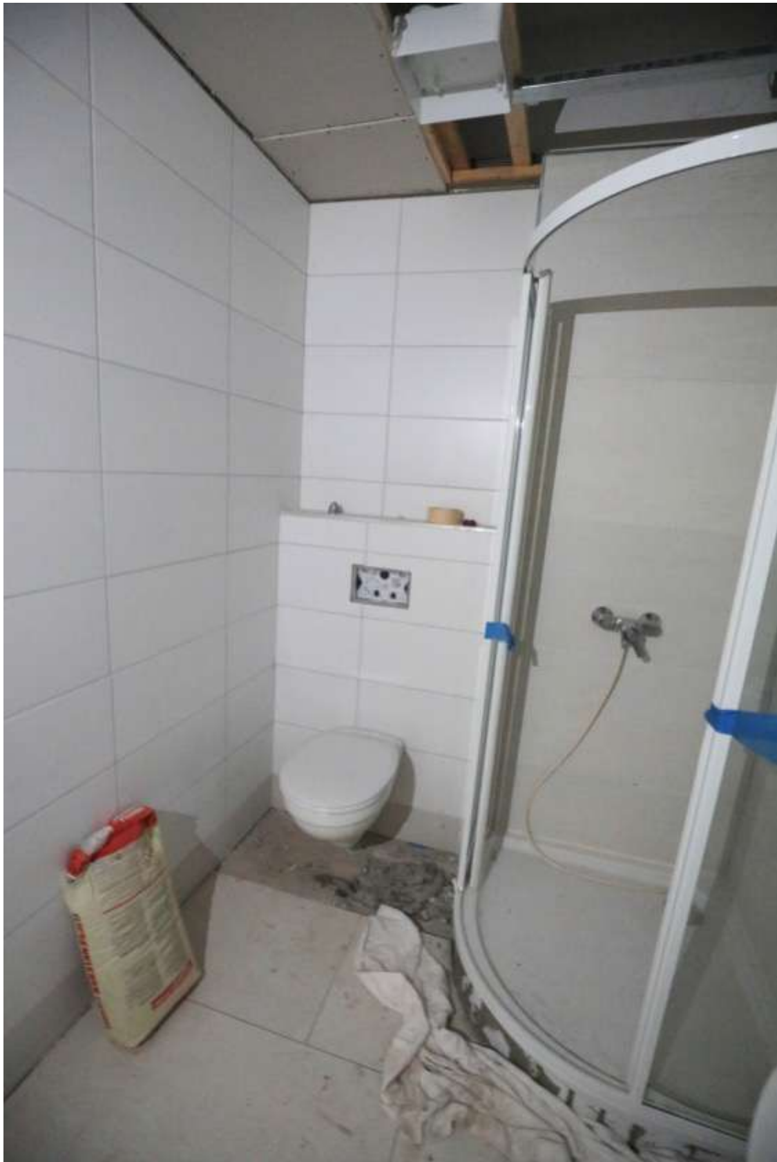
1.OG; Fertigstellungsarbeiten nach Baustopp eingestellt
