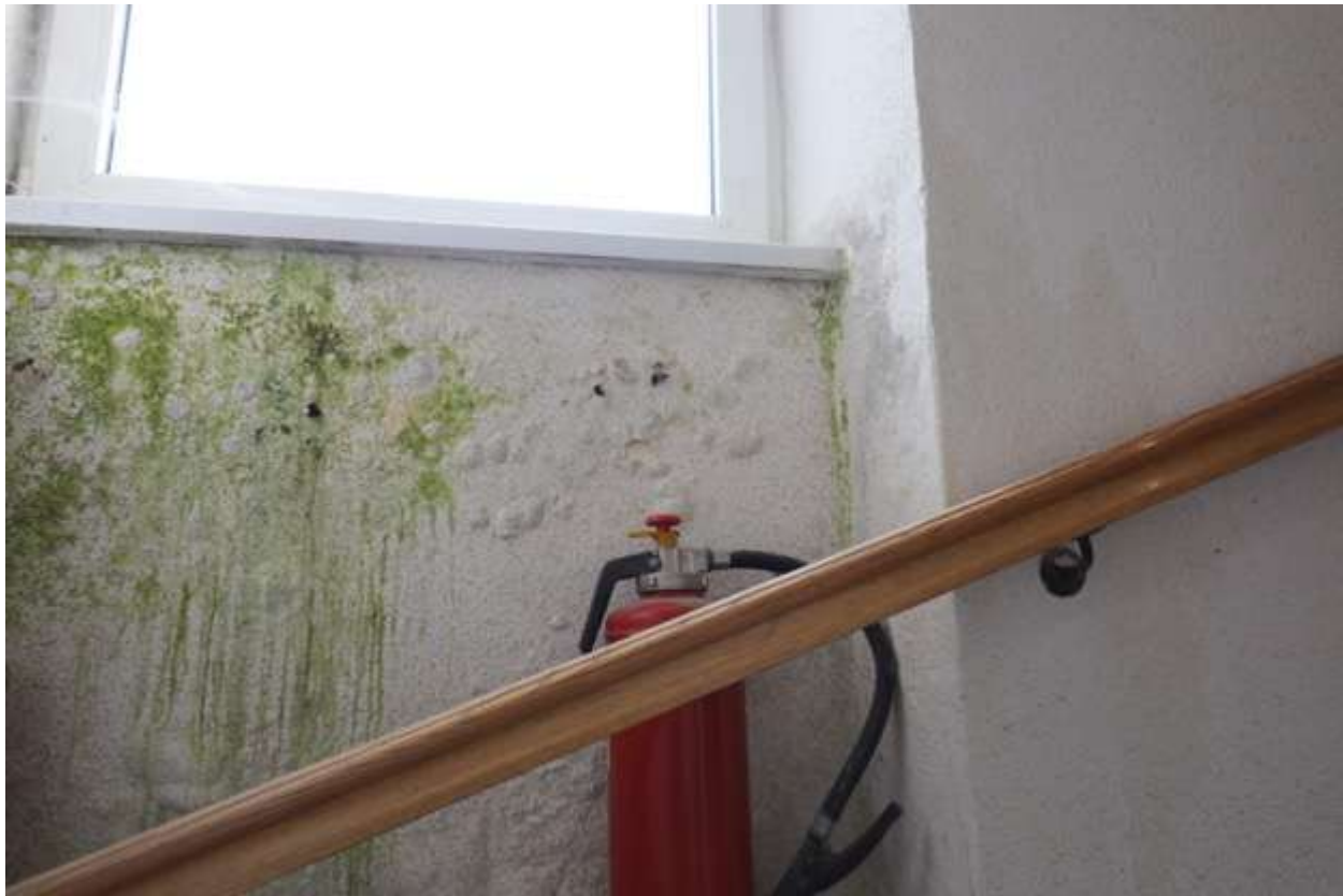
Massiver Wasserschaden im Stiegenhaus
