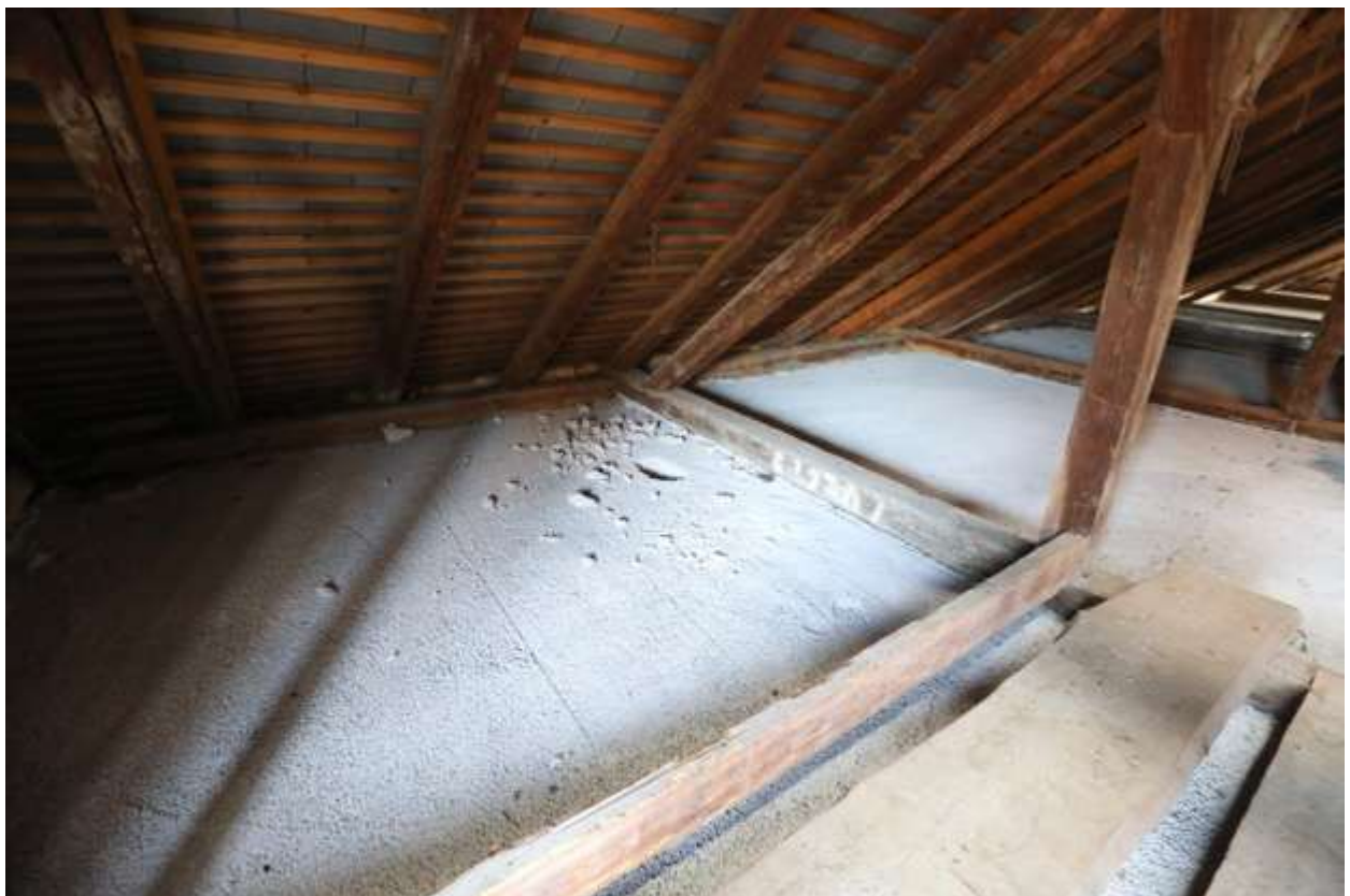
Dach ist zu sanieren; Schüttung teilweise schadhaft
