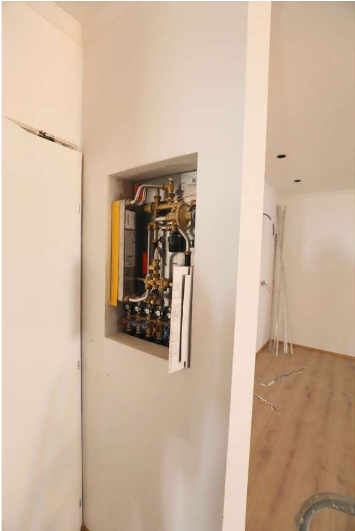
1.OG; Fertigstellungsarbeiten nach Baustopp eingestellt
