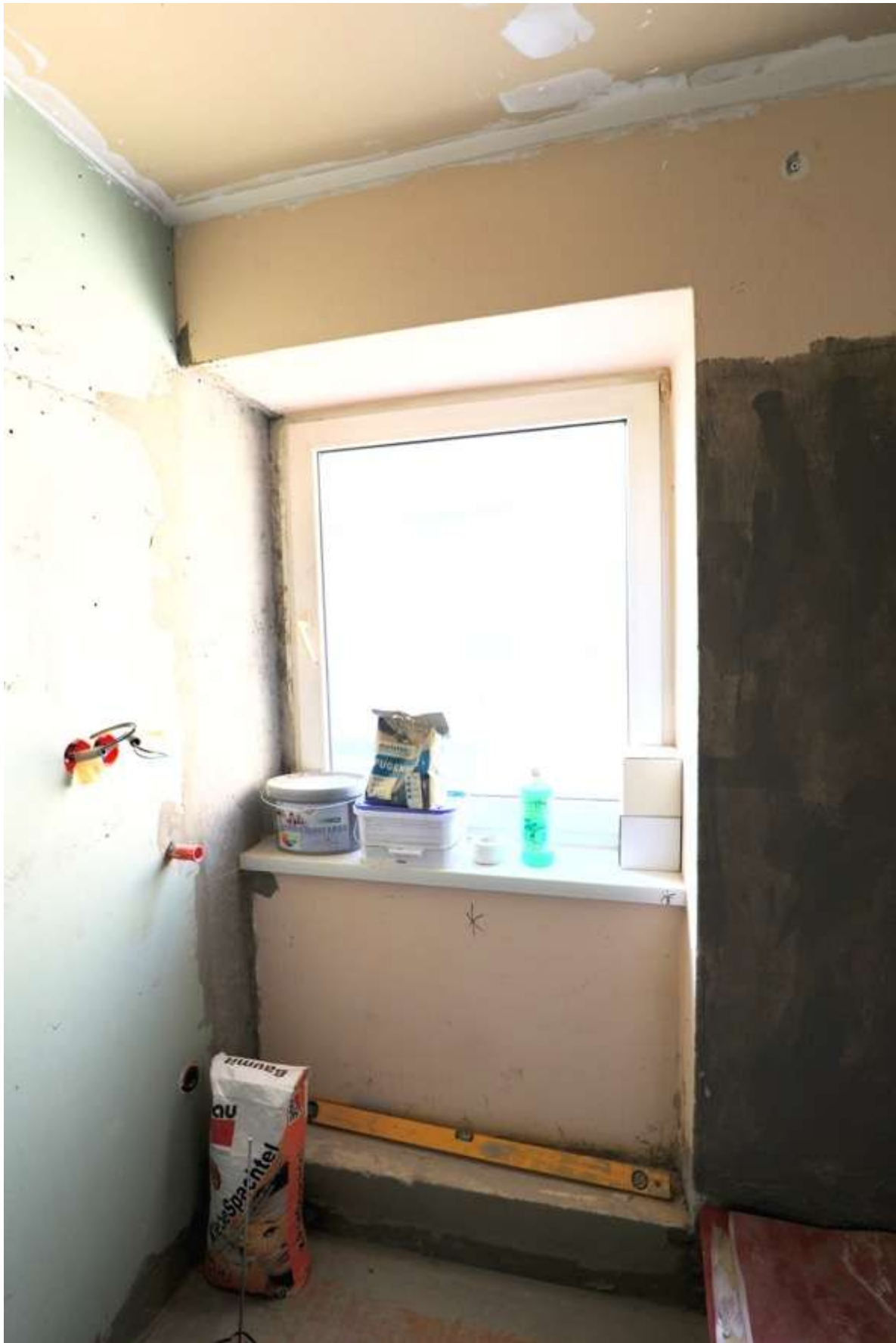
1.OG; Fertigstellungsarbeiten nach Baustopp eingestellt
