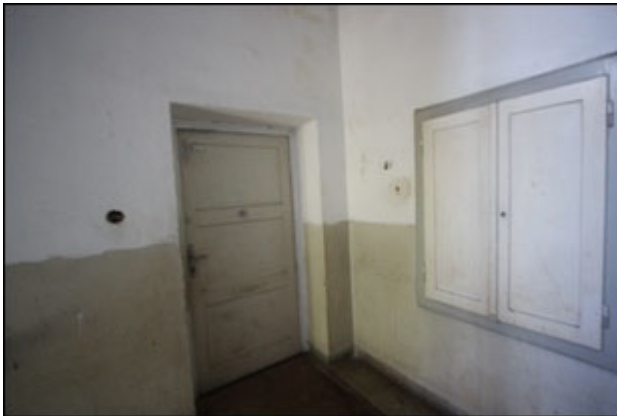
Abb.23 Ansicht Flur 1.OG, Eingang Wohnung West
