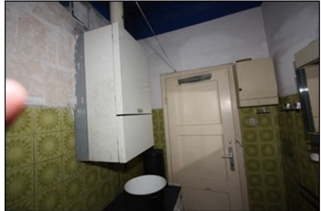
Abb.126 Ansicht Wohnung West (2.OG)
