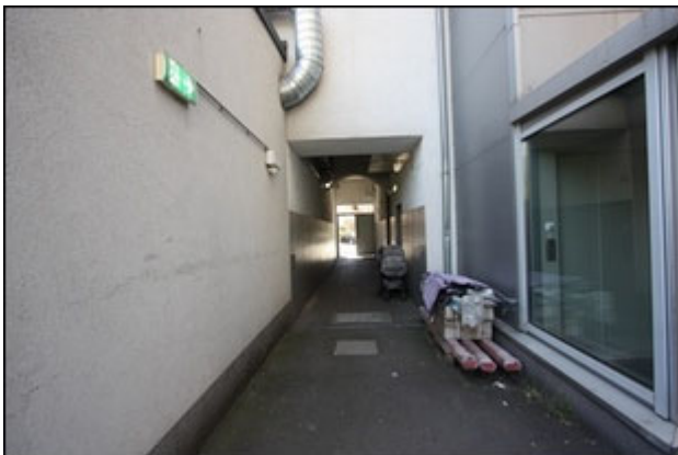
Abb.3 Ansicht Durchgang, Gebäude Wiener Str. 27 (EZ 178)
