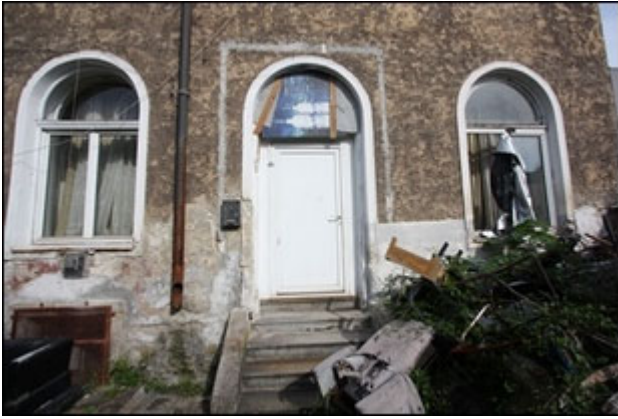
Abb.77 Ansicht Zugang Wohnung Ost (vgl. Abb.10)
