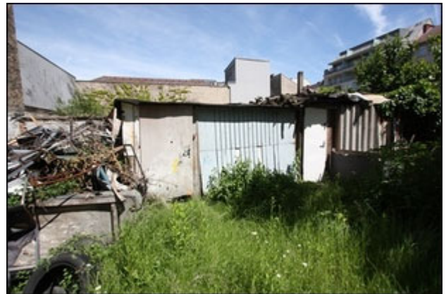
Abb.12 Ansicht Liegenschaft, Garten, primitiver Schuppen
