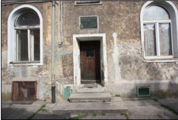
Abb.15 Ansicht Eingang Stiegenhaus (vgl. Abb.9)
