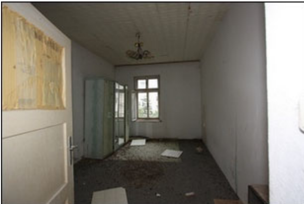
Abb.89 Ansicht Wohnung West (1.OG)
