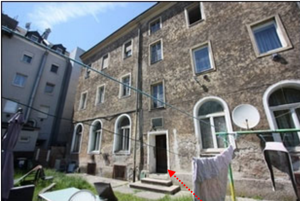
Abb.9 Ansicht Wohngebäude, Zugang Stiegenh. KG/Dachboden
