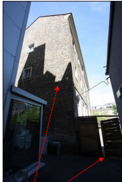
Abb.4 Ansicht Zugang Liegenschaft EZ 1157 Wohngebäude Wiener Str. 27a (Hofgebäude)
