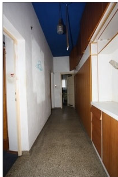
Abb.114 Ansicht Wohnung West (2.OG)
