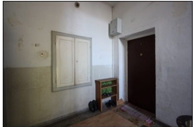
Abb.24 Ansicht Flur 1.OG, Eingang Wohnung Ost
