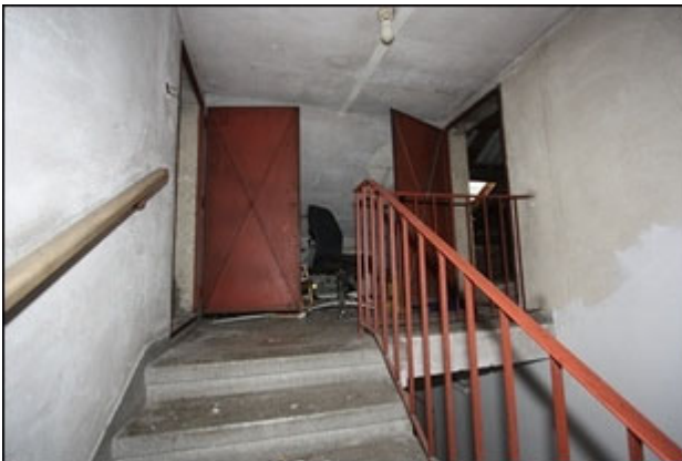
Abb.31 Ansicht Flur Dachboden, links/rechts: Zugang Dachboden
