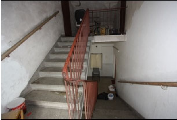
Abb.27 Ansicht Stiegenhaus 2.OG/Dachboden
