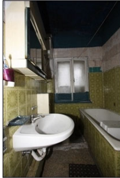
Abb.124 Ansicht Wohnung West (2.OG)
