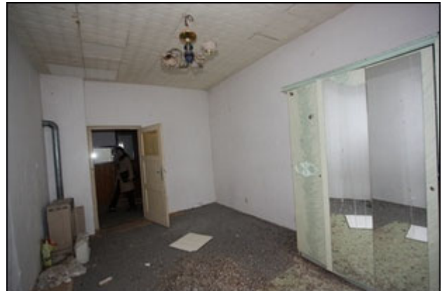
Abb.90 Ansicht Wohnung West (1.OG)
