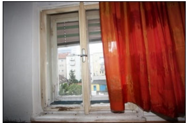
Abb.120 Ansicht Wohnung West (2.OG)
