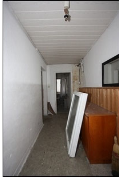
Abb.88 Ansicht Wohnung West (1.OG)
