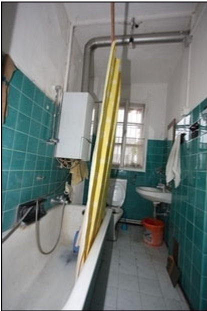
Abb.131 Ansicht Wohnung Ost (2.OG)
