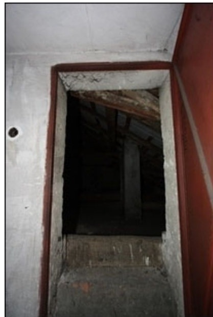
Abb.32 Ansicht Zugang (links-/= westseitiger Dachboden)
