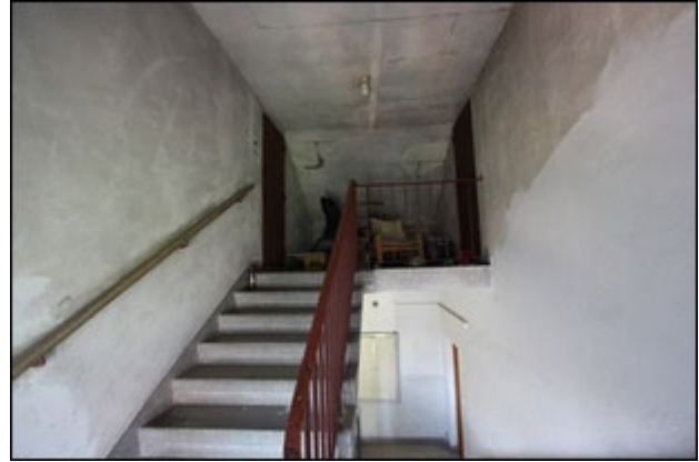
Abb.28 Ansicht Stiegenhaus 2.OG/Dachboden
