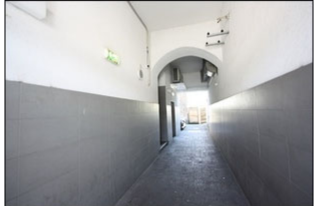
Abb.2 Ansicht Durchgang, Gebäude Wiener Str. 27 (EZ 178)
