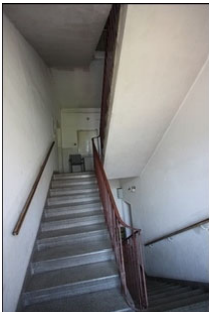
Abb.25 Ansicht Stiegenhaus 1.OG/2.OG
