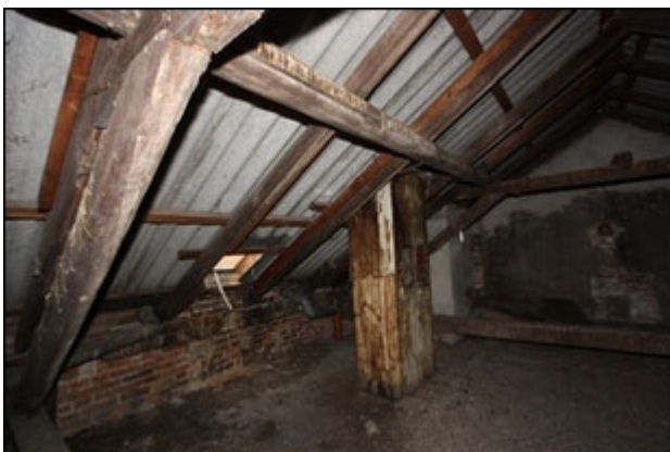
Abb.37 Ansicht Detail zu Abb.36
