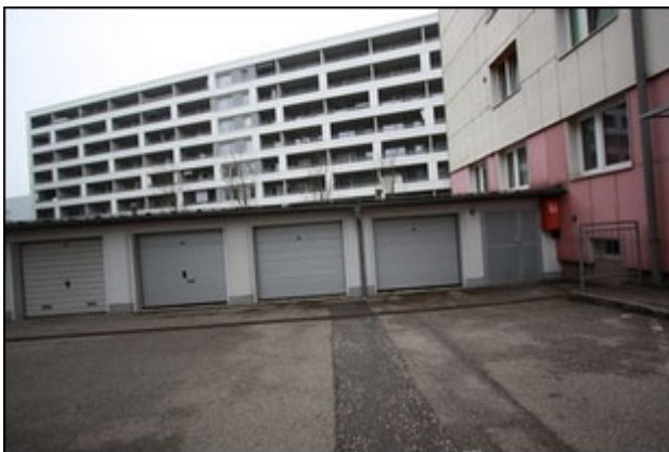
Abb.5 Ansicht Liegenschaft/Teilabschnitt Nord, 3 Garagen weitere Garage (links): Nachbarliegenschaft rechts: Wohngebäude Wiener Str. 209
