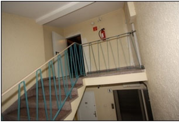
Abb.27 Ansicht Stiegenhaus 6.OG/Dachboden
