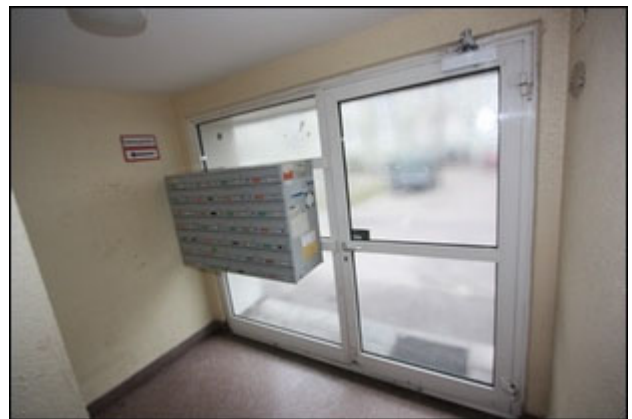
Abb.10 Ansicht Stiegenhaus, Hauseingang
