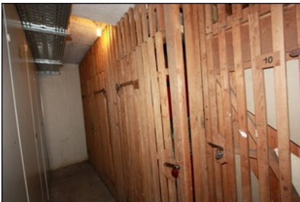
Abb.33 Ansicht KG, Teilabschnitt, Kellerabteile
