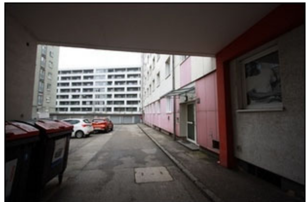
Abb.4 Ansicht Detail zu Abb.4, Zufahrt/Zugang
