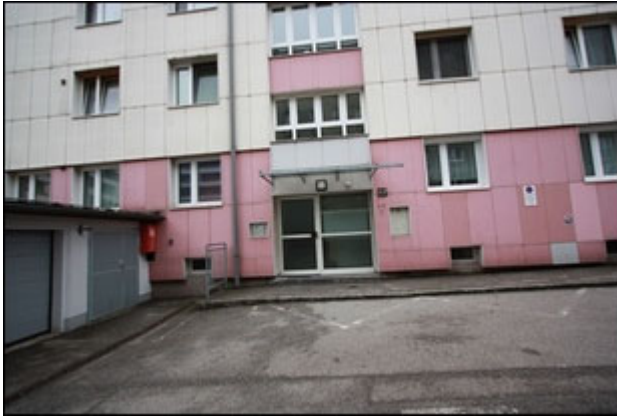
Abb.7 Ansicht Detail zu Abb.6, Hauseingang Wiener Str. 209
