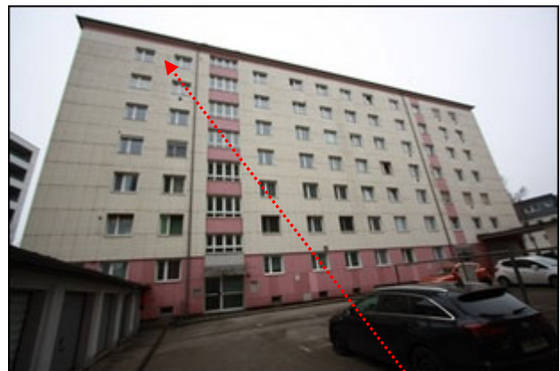
Abb.6 Ansicht Liegenschaft/Wohngebäude Wiener Str. 207/209 Hofseite, Gebäude Nordwestseite, Hauszugänge Lage Wohnung W 25, Gebäude Wiener Str. 209, 6.OG
