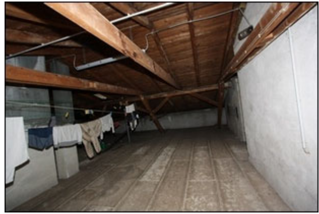
Abb.28 Ansicht Dachboden (Trockenboden)
