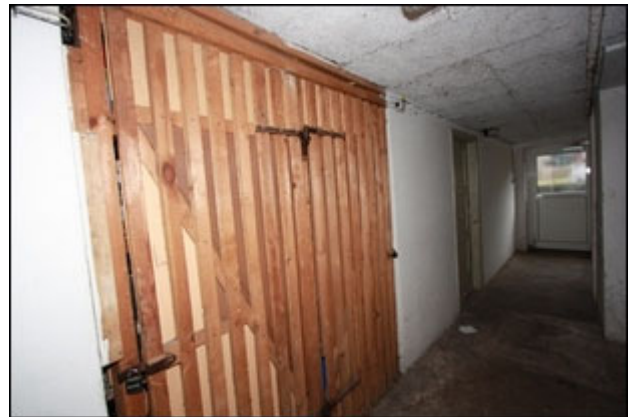
Abb.32 Ansicht KG, Teilabschnitt, Kellerabteile, Ausgang Garten
