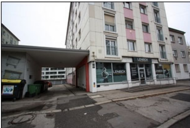
Abb.3 Ansicht Zufahrt zum Hof und Zugang zu den hofseitigen Stiegenhäusern der Wohngebäude Wiener Str. 207 und 209
