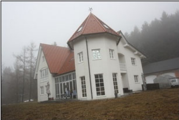
Abb.9 Ansicht Wohngebäude, Südwestseite
