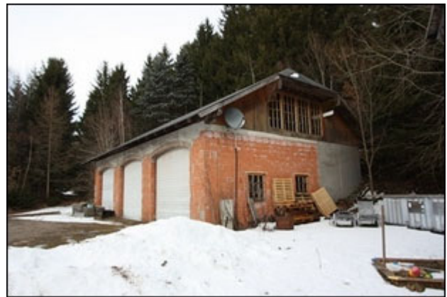
Abb.78 Ansicht Garagengebäude, Südwestseite
