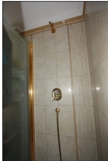
Abb.58 Ansicht Wohngebäude OG, Bad 1, Duschkabine
