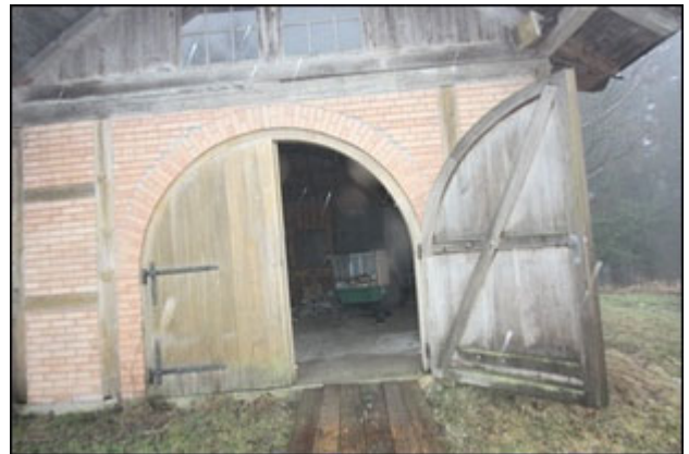
Abb.90 Ansicht Pferdestall, Detail zu Abb.87
