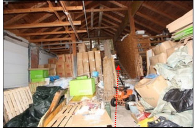
Abb.82 Ansicht Garagengebäude, Stiege auf Zwischendecke
