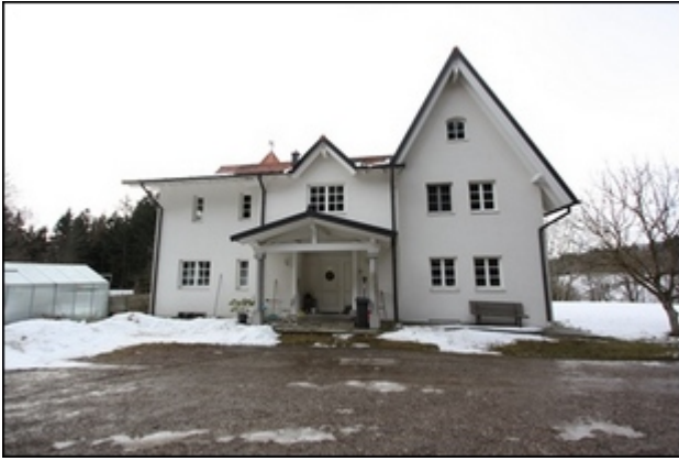
Abb.7 Ansicht Wohngebäude, Ostseite, Vorplatz (geschottert)
