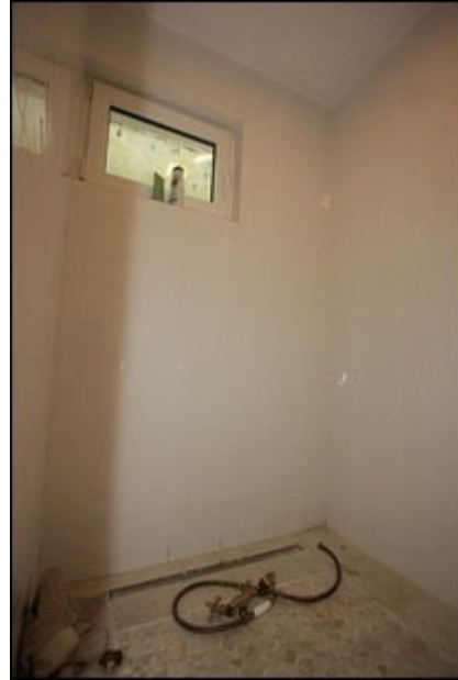
Abb.70 Ansicht Wohngebäude KG, Bad/Dusche (nicht fertig gestellt)
