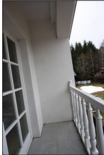
Abb.44 Ansicht Wohngebäude OG, Balkon (Raum Süd)
