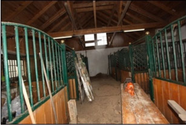
Abb.93 Ansicht Pferdestall, Innenausstattung, ehem. Pferdeboxen
