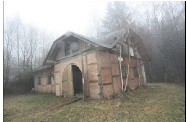
Abb.88 Ansicht Pferdestall, Nordwestseite
