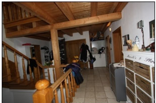
Abb.14 Ansicht Wohngebäude EG, Flur/Diele, Stiegenanlage
