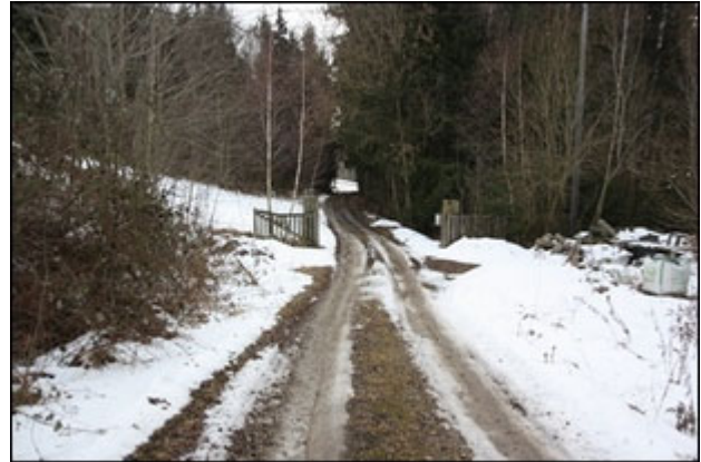
Abb.2 Ansicht Zufahrt Liegenschaft, Straße = Privatstraße (vgl. Beilage 3.2, Begrenzungstoranlage (betagt/desolat)
