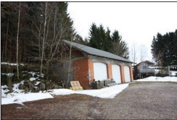
Abb.77 Ansicht Garagengebäude, Nordwestseite
