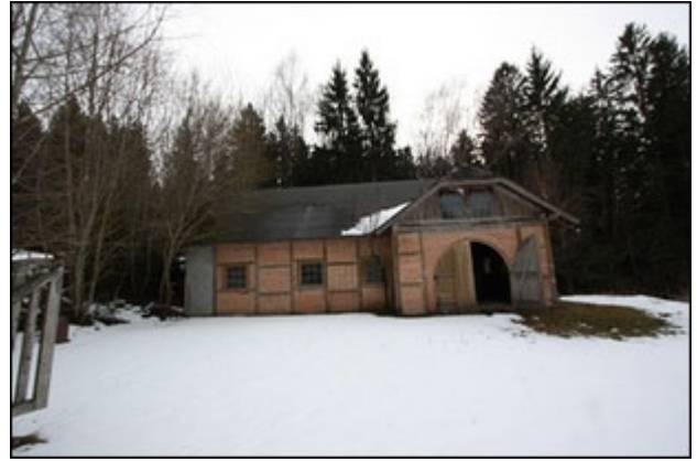
Abb.86 Ansicht Pferdestall, Nordseite, Vorplatz/Erschließung
