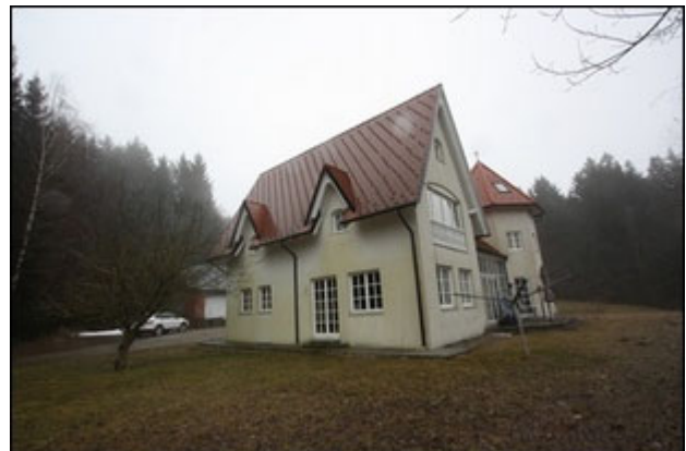
Abb.6 Ansicht Wohngebäude, Nordwestseite, Garten Nordwest
