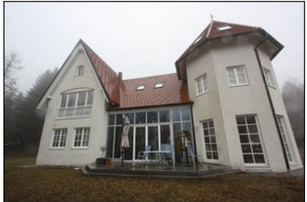
Abb.10 Ansicht Wohngebäude, Westseite, Terrasse
