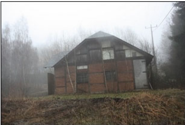
Abb.89 Ansicht Pferdestall, Westseite
