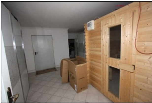
Abb.71 Ansicht Wohngebäude KG, Kellerraum (Sauna)
