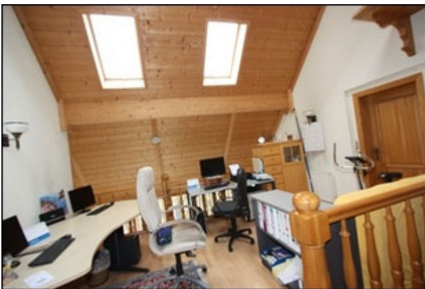
Abb.33 Ansicht Wohngebäude OG, Flur (Büro)
