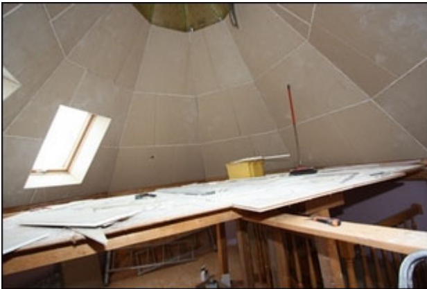
Abb.51 Ansicht Turmzimmer DG (Innenausbau in Bearbeitung)
