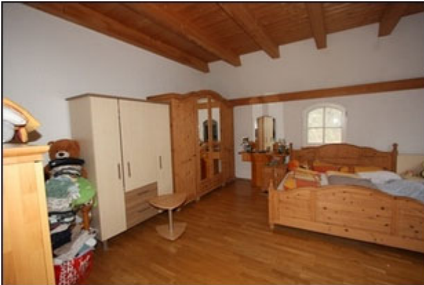
Abb.63 Ansicht Wohngebäude OG, Schlafzimmer Nordost
