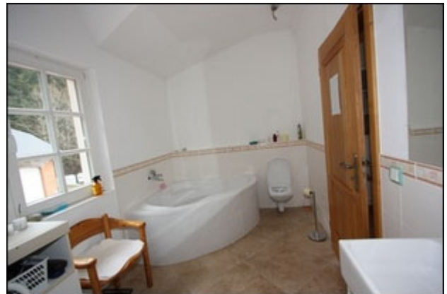
Abb.60 Ansicht Wohngebäude OG, Bad 2
