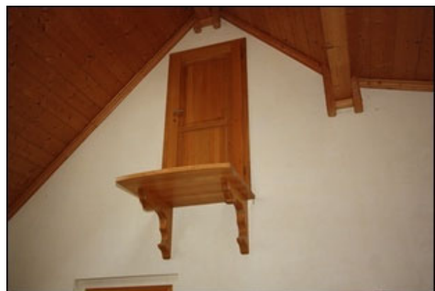
Abb.36 Ansicht Detail zu Abb.34 (Tür zum Spitzboden)
