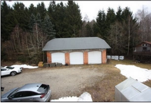
Abb.61 Ansicht Wohngebäude OG, Ausblick vom Bad 2
