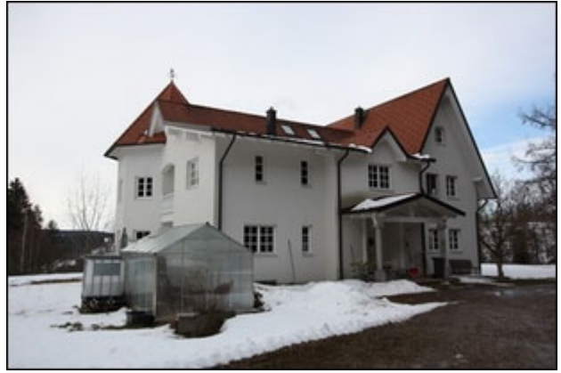
Abb.8 Ansicht Wohngebäude, Südostseite
