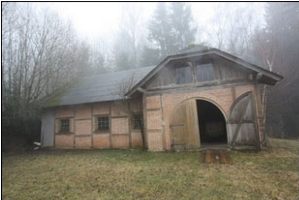
Abb.87 Ansicht Pferdestall, Nordseite
