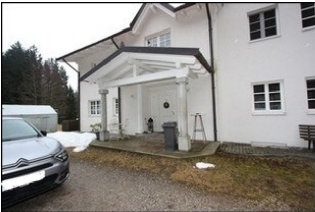
Abb.11 Ansicht Wohngebäude, Ostseite, Vorplatz, Hauszugang
