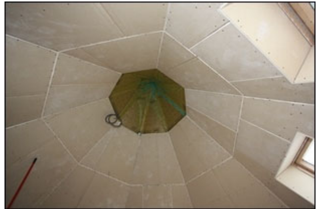
Abb.52 Ansicht Turmzimmer DG (Innenausbau in Bearbeitung)
