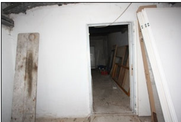
Abb.129 Ansicht Anbau Süd (UG), Teilfläche Mitte/West
