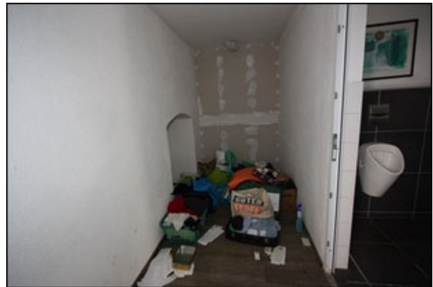
Abb.136 Ansicht Anbau Süd (UG), Wohneinheit
