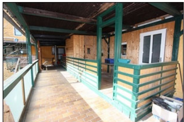
Abb.244 Ansicht Anbau Nordost (EG), Wohnung 1, Terrasse
