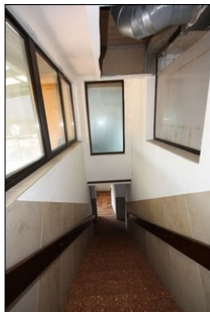
Abb.104 Ansicht Hauptgeb. KG, Abgang Keller Süd (vgl. Abb.50)
