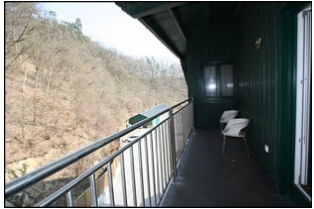
Abb.100 Ansicht Hauptgebäude DG (Appartement), Loggia Nord
