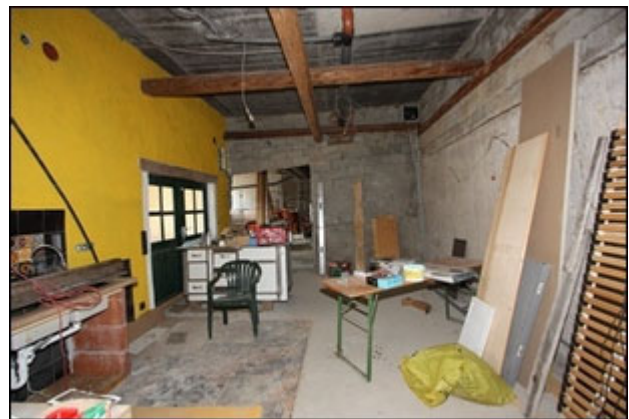
Abb.268 Ansicht Anbau Nordost (UG), Lager 2 (Werkstatt)
