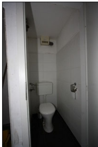
Abb.42 Ansicht Hauptgebäude EG
