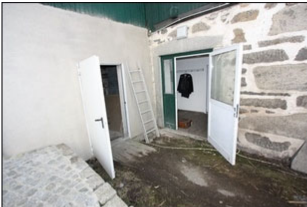
Abb.133 Ansicht Anbau Süd (UG), Teilfl. West, vgl. Abb.3, 131
