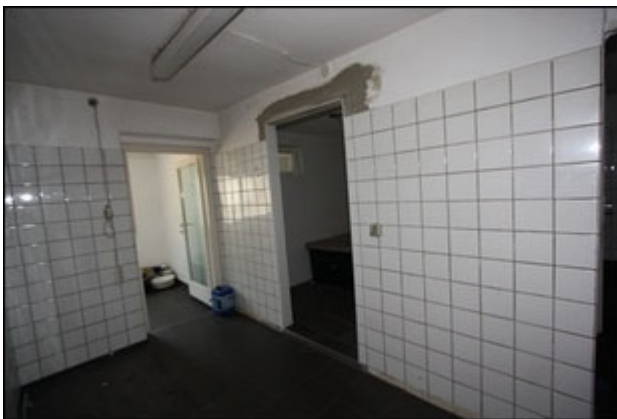
Abb.39 Ansicht Hauptgebäude EG
