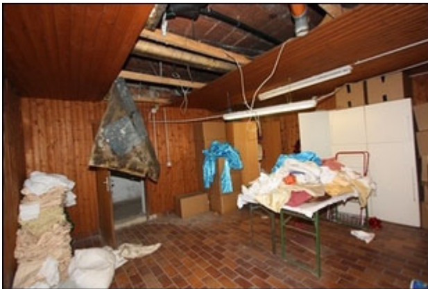
Abb.115 Ansicht Hauptgebäude KG, Wasch-/Duschraum
