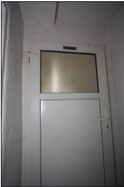
Abb.163 Ansicht Anbau Süd (UG), Teilfläche Mitte, Zimmertrakt
