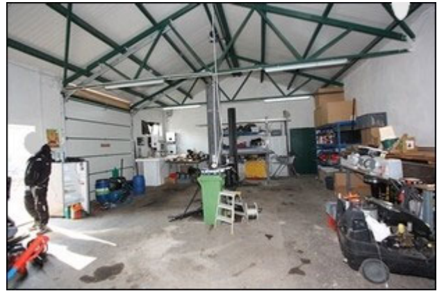
Abb.286 Ansicht Nebengebäude, Lageraum 2 (Werkstatt)
