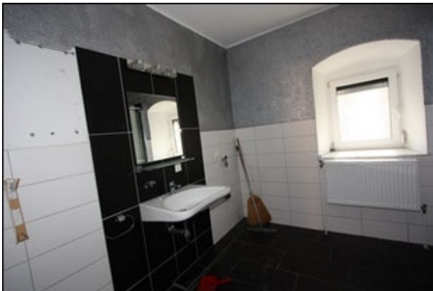
Abb.171 Ansicht Anbau Süd (UG), Teilfläche Ost, Wohnung
