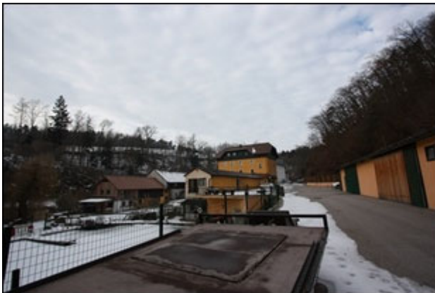
Abb.13 Ansicht Liegenschaft, Teilabschnitt Ost, Richtung Hauptgebäude, Anbauten Süd, Ost und Nebengebäude
