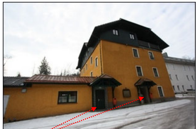
Abb.6 Ansicht Hauptgebäude Nordseite, Anbau Ost Eingänge Nord
