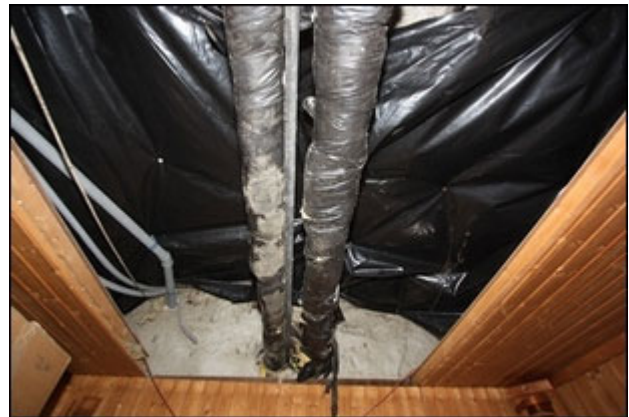
Abb.116 Ansicht Hauptgebäude KG, Detail
