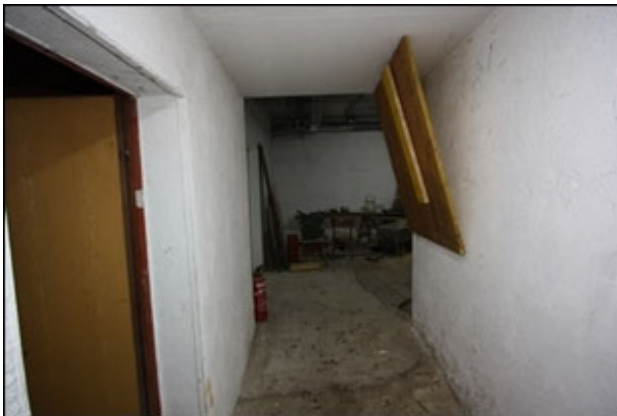
Abb.127 Ansicht Verbindung Hauptgebäude/Anbau Süd (UG)
