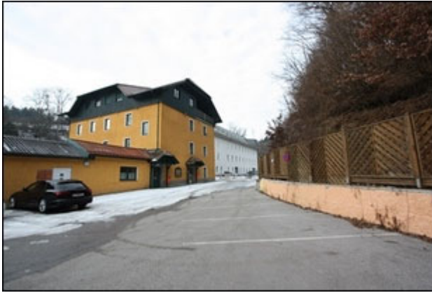
Abb.7 Ansicht Liegenschaft, Hauptgebäude, Anbau Ost Vorplatz (Abstellplätze)
