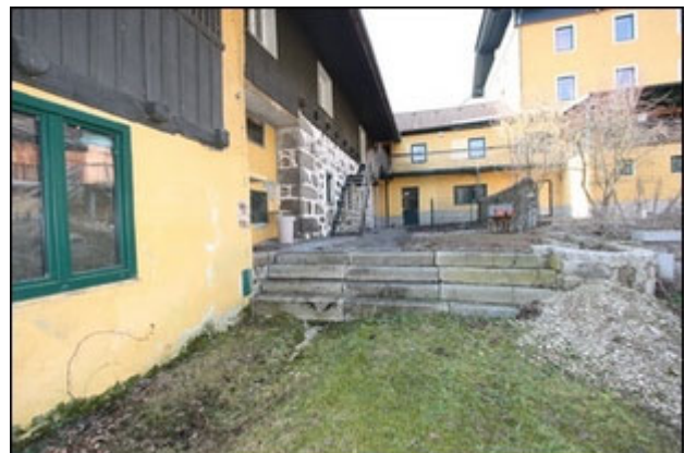
Abb.176 Ansicht Anbau Süd (UG), Teilfläche Ost, Hof
