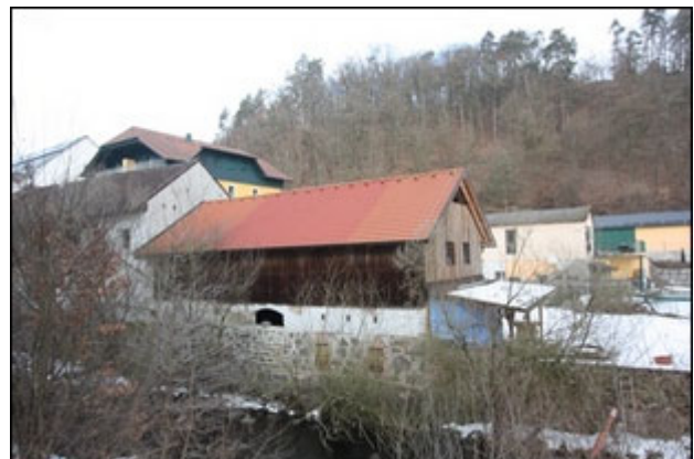
Abb.30 Ansicht Anbau Süd, Teilabschnitt Ost
