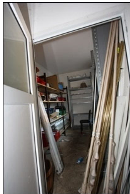
Abb.150 Ansicht Anbau Süd (UG), Teilfläche Mitte
