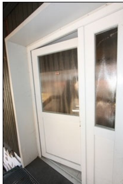
Abb.192 Ansicht Anbau Süd, Teilfl. Ost (EG), Betriebswohnung
