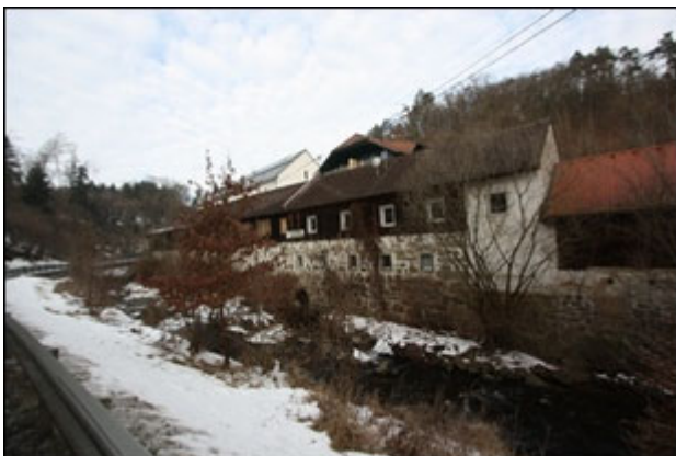
Abb.29 Ansicht Anbau Süd, straßen-/flusseitig (Große Gusen)
