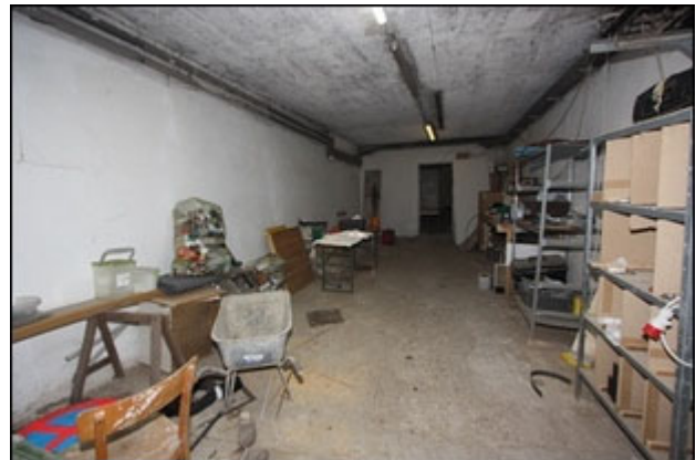
Abb.128 Ansicht Anbau Süd (UG), Teilfläche Mitte/West
