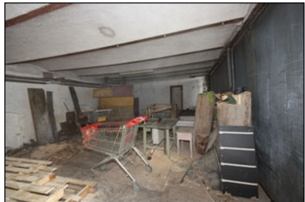
Abb.142 Ansicht Anbau Süd (UG), Teilfläche West, Garage
