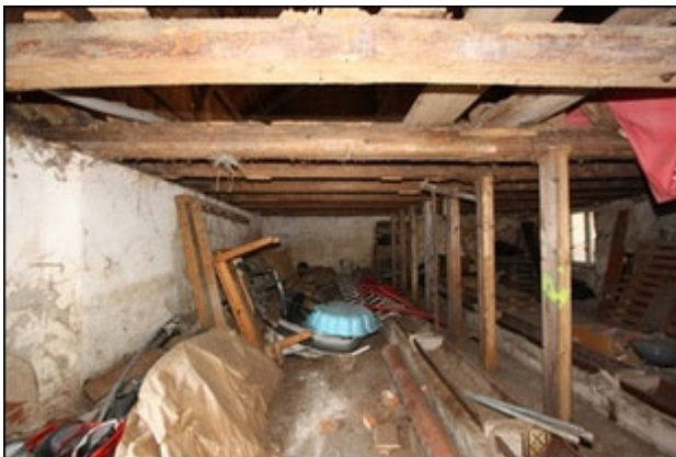
Abb.179 Ansicht Anbau Süd (UG), Teilfläche Ost (Raum desolat)
