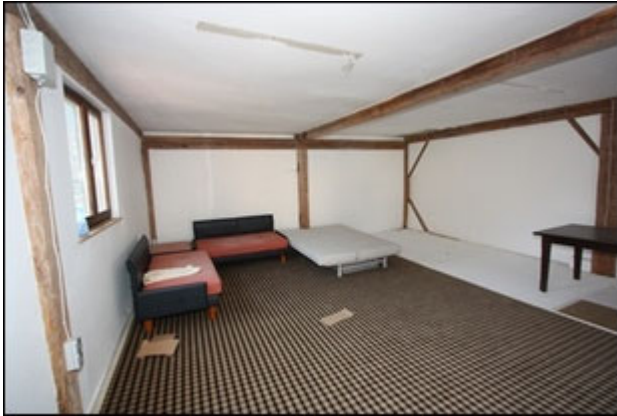
Abb.189 Ansicht Anbau Süd, Teilfläche Ost (EG), Raum Ost
