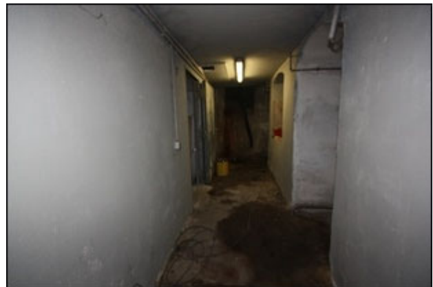
Abb.122 Ansicht Hauptgebäude KG
