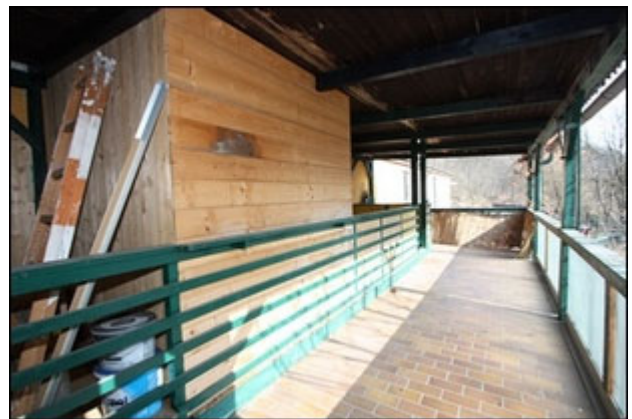
Abb.248 Ansicht Anbau Nordost (EG), Wohnung 1, Terrasse
