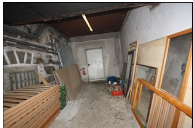
Abb.130 Ansicht Anbau Süd (UG), Teilfläche Mitte/West
