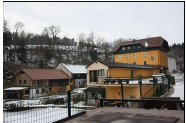
Abb.14 Ansicht Detail Abb.13, Hauptgebäude, Anbauten)
