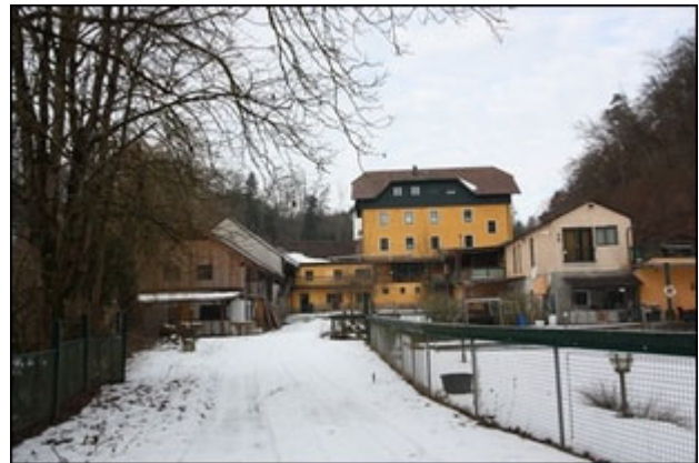
Abb.20 Ansicht Detail Abb.19 (Hauptgebäude, Anbauten)
