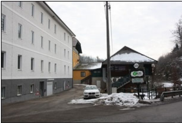
Abb.1 Ansicht Zufahrt Liegenschaft (EZ 30) von der Landesstraße, links: Nachbargebäude (fremd), Erschließung = Privatstraße: gemeinsames Geh-/Fahrtrecht mit Nachbarliegenschaft
