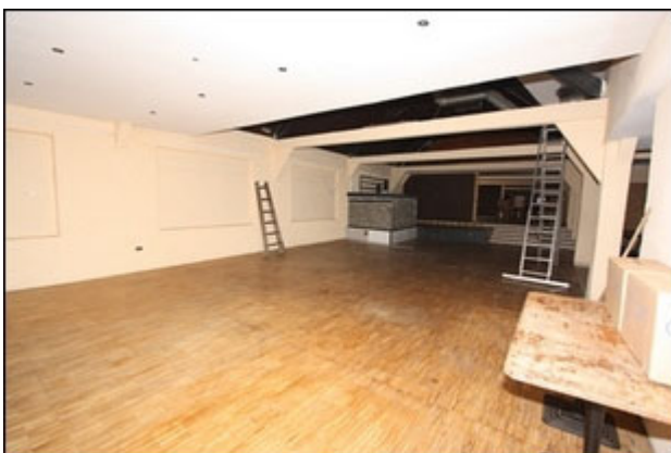
Abb.211 Ansicht Anbau Süd (EG), Teilfläche Mitte, Saal
