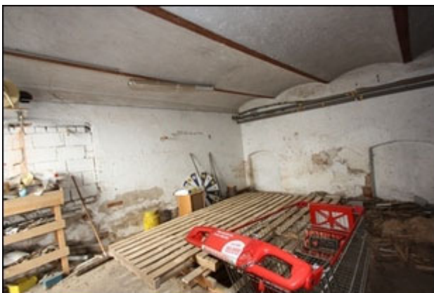
Abb.143 Ansicht Anbau Süd (UG), Teilfläche West, Garage
