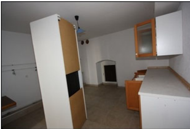
Abb.135 Ansicht Anbau Süd (UG), Wohneinheit
