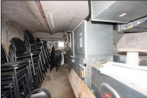
Abb.145 Ansicht Anbau Süd (UG), Teilfl. West (Lüftungszentrale)
