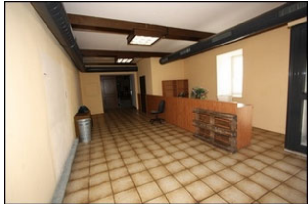
Abb.34 Ansicht Hauptgebäude EG, Erschließung Saal
