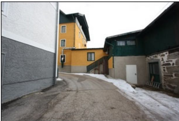
Abb.3 Ansicht Detail zu Abb.1/2, Zufahrt, Kurve 90°, gelbes Gebäude: Hauptgebäude, rechts: Anbau Süd
