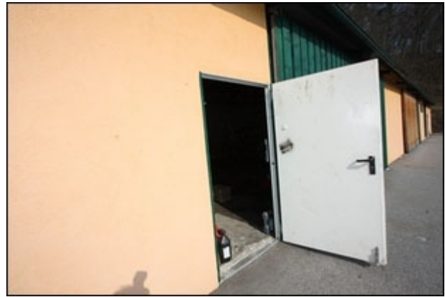
Abb.278 Ansicht Nebengebäude, Lagererraum 1 (Werkstatt)
