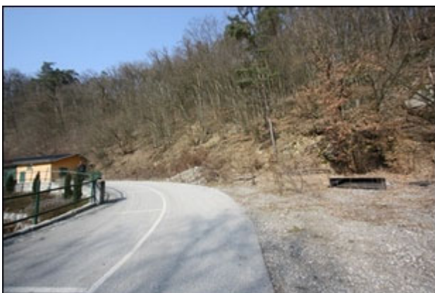
Abb.295 Ansicht Teilabschnitt Ost, innere Erschließung (vgl. Abb.15)
