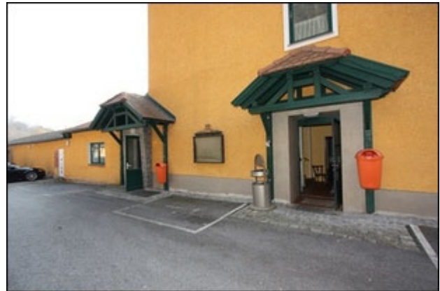
Abb.32 Ansicht Hauptgebäude, Eingänge Nord (EG), vgl. Abb.6
