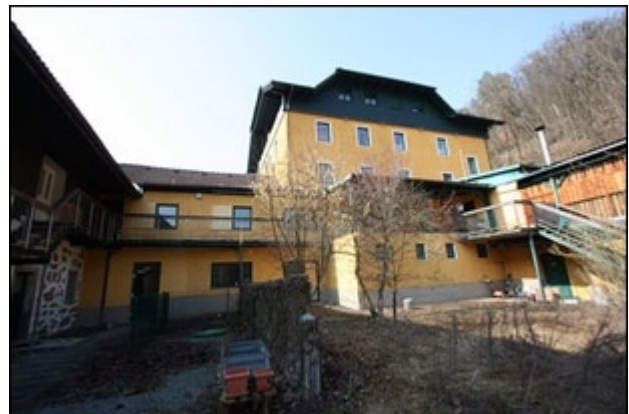
Abb.230 Ansicht Hauptgebäude samt Anbauten, Hof
