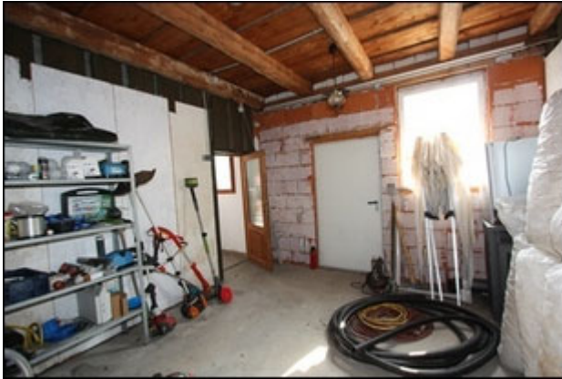
Abb.265 Ansicht Anbau Nordost (UG), Lager 1
