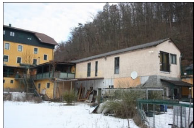
Abb.22 Ansicht Anbau Nordost
