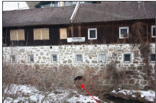
Abb.28 Ansicht Detail zu Abb.27, Turbinenkanal (Ableitung in die Große Gusen)
