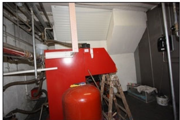
Abb.274 Ansicht Anbau Nordost (UG), Heizraum
