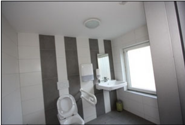
Abb.207 Ansicht Anbau Süd (EG), Teilfläche Mitte, WC-Anlagen
