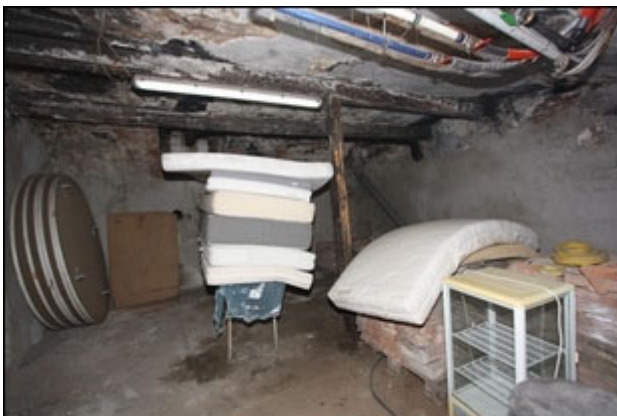
Abb.117 Ansicht Hauptgebäude KG
