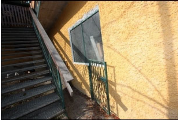
Abb.271 Ansicht Anbau Nordost (UG), Zugang Terrasse im EG (vgl. Abb.245) und Heizraum
