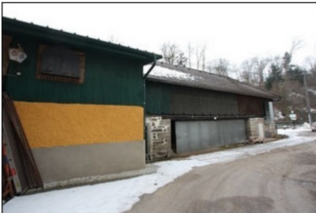
Abb.25 Ansicht Anbau Süd, Teilabschnitt West, vgl. Abb.1-3
