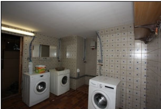
Abb.113 Ansicht Hauptgebäude KG, Wasch-/Duschraum
