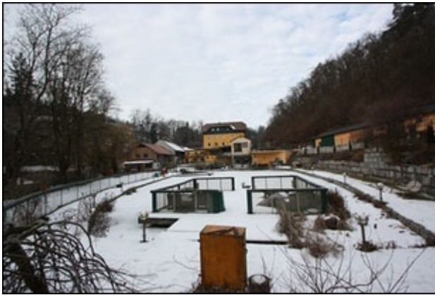
Abb.23 Ansicht Fischteich, Hauptgebäude, Anbauten
