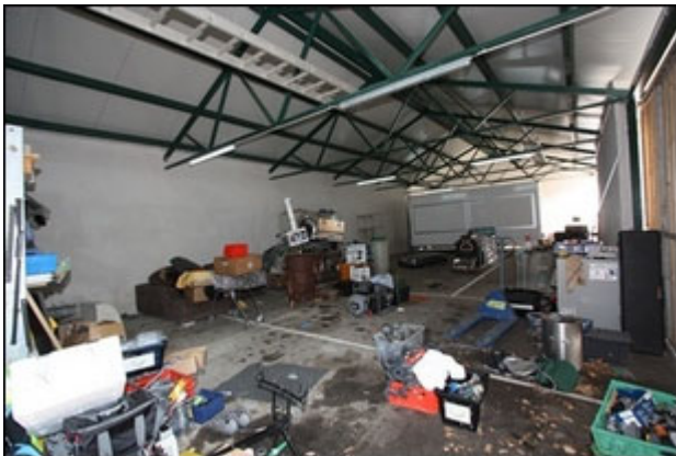
Abb.279 Ansicht Nebengebäude, Lagererraum 1 (Werkstatt)
