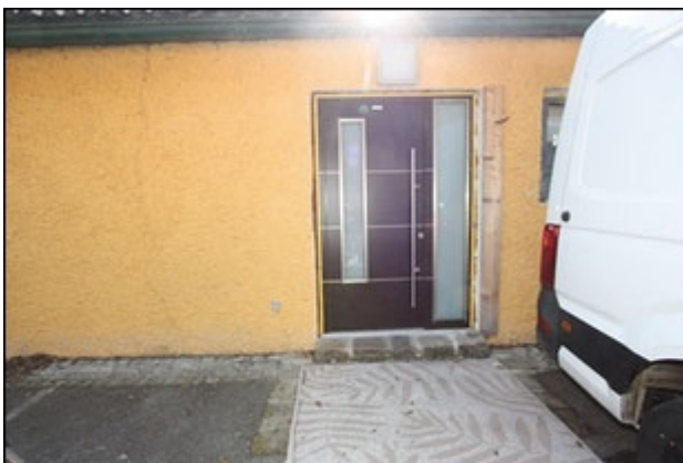
Abb.249 Ansicht Anbau Nordost (EG), Eingang Wohnung 2
