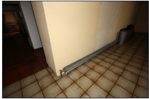
Abb.44 Ansicht Hauptgebäude EG, Detail
