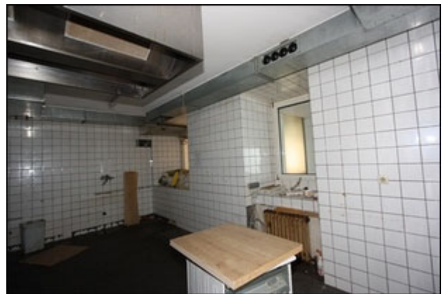
Abb.40 Ansicht Hauptgebäude EG
