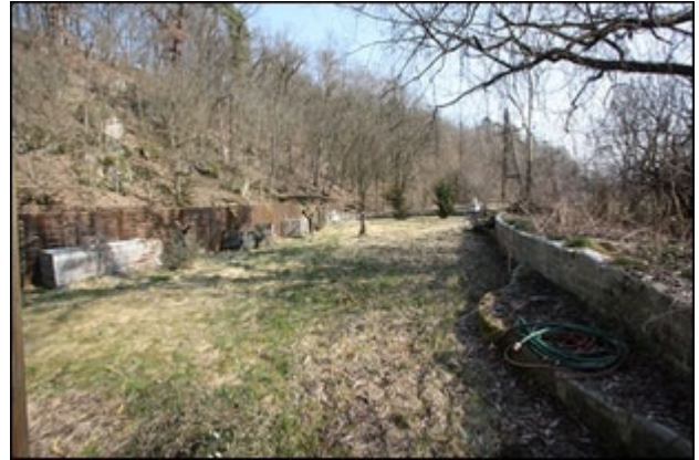
Abb.298 Ansicht Teilabschnitt Ost (vgl. Abb.18)
