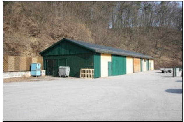
Abb.10 Ansicht Nebengebäude Südwestseite, Lagerhalle/Werkstatt (4.3.2026)
