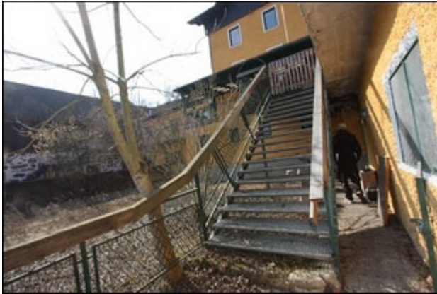
Abb.245 Ansicht hofseitiger Zugang zur Terrasse
