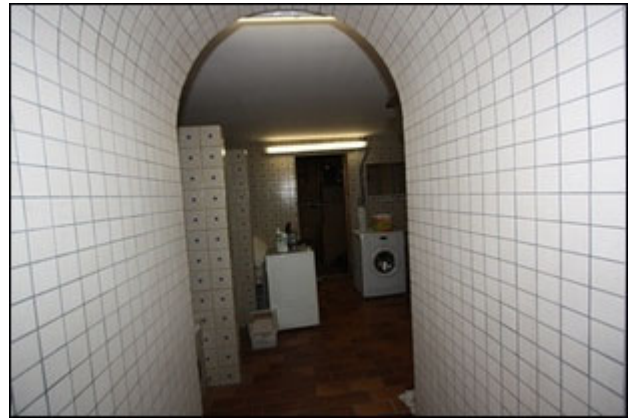
Abb.112 Ansicht Hauptgebäude KG, Wasch-/Duschraum
