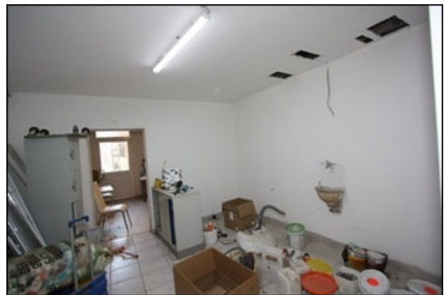
Abb.148 Ansicht Anbau Süd (UG), Teilfläche Mitte
