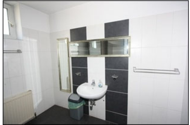
Abb.106 Ansicht Hauptgebäude KG, WC-Anlagen (Gastronomie)
