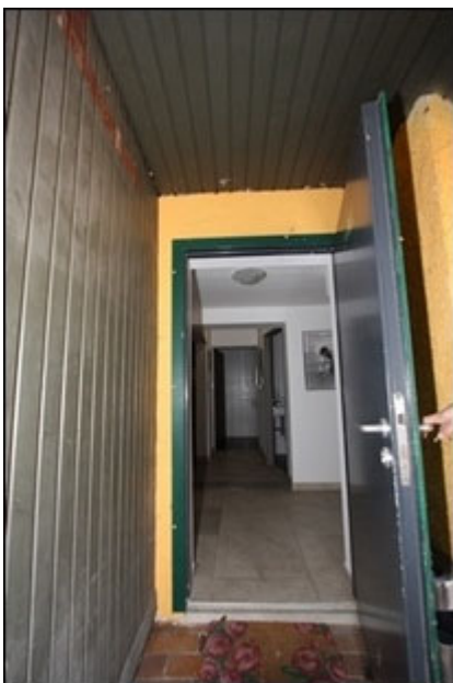
Abb.205 Ansicht Anbau Süd (EG), Übergang Teilfläche Mitte
