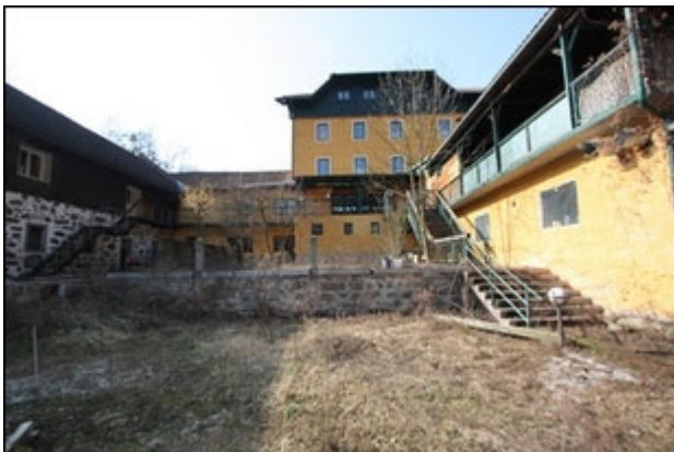
Abb.229 Ansicht Hauptgebäude samt Anbauten, Hof
