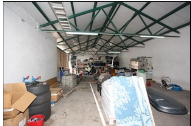
Abb.280 Ansicht Nebengebäude, Lagererraum 1 (Werkstatt)
