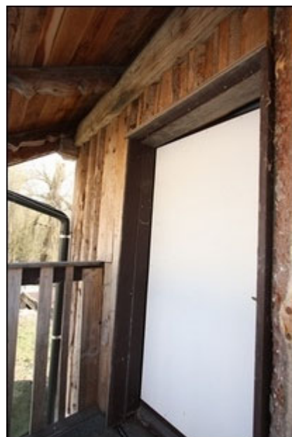
Abb.188 Ansicht Anbau Süd, Teilfl. Ost (EG), Eingang Raum Ost
