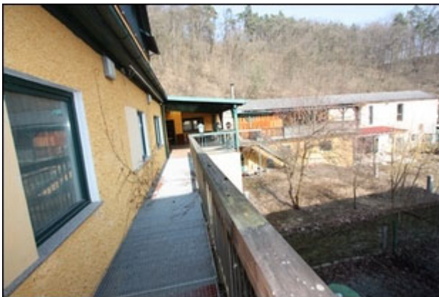
Abb.53 Ansicht Hauptgebäude EG
