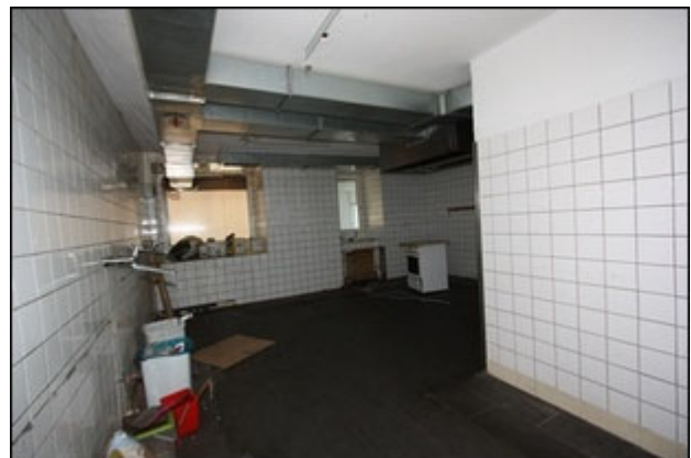
Abb.36 Ansicht Hauptgebäude EG
