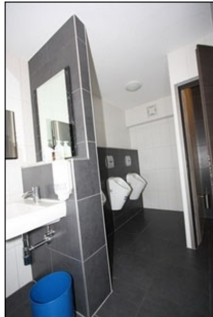
Abb.210 Ansicht Anbau Süd (EG), Teilfläche Mitte, WC-Anlagen
