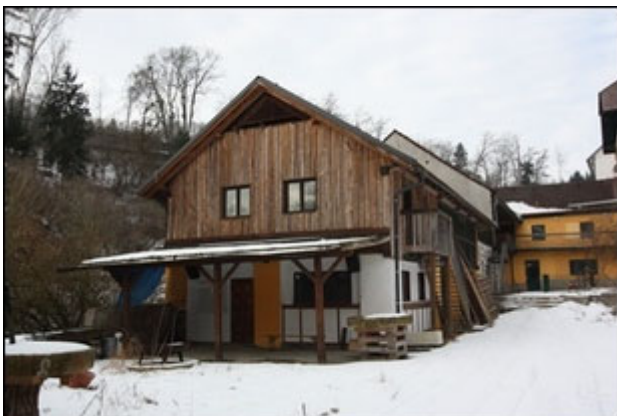
Abb.21 Ansicht Anbau Süd, Teilfläche Ost
