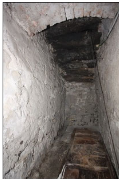
Abb.124 Ansicht Hauptgebäude KG
