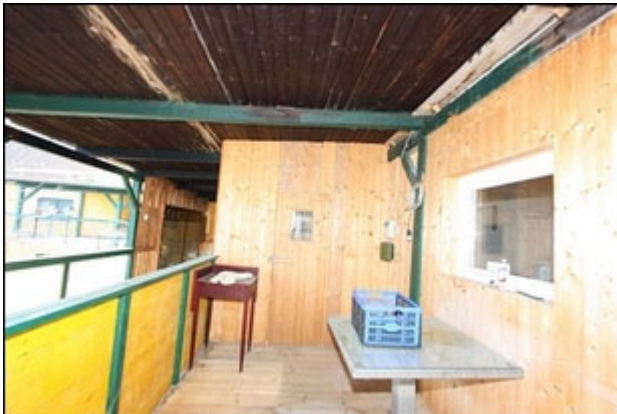
Abb.241 Ansicht Anbau Nordost (EG), Wohnung 1, Terrasse
