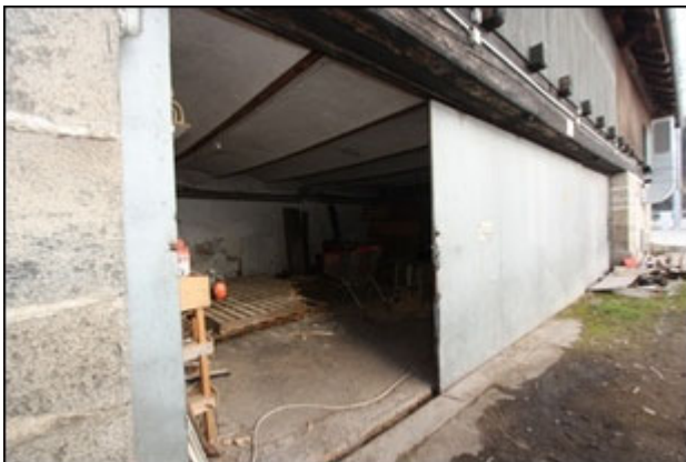
Abb.141 Ansicht Anbau Süd (UG), Teilfläche West, Garage
