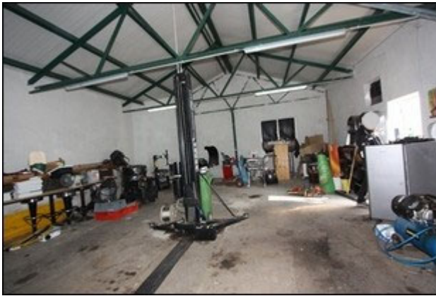
Abb.285 Ansicht Nebengebäude, Lageraum 2 (Werkstatt)
