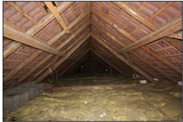
Abb.70 Ansicht Dachboden Anbau Süd, Teilabschnitt (via Raum Abb.69)
