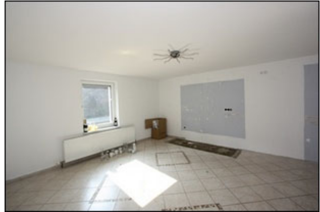
Abb.202 Ansicht Anbau Süd, Teilfl. Ost (EG), Betriebswohnung
