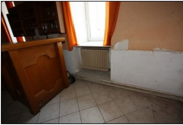
Abb.43 Ansicht Hauptgebäude EG, Detail
