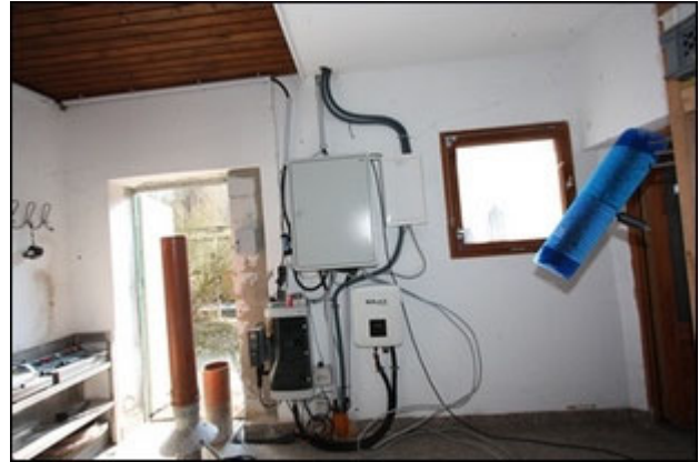
Abb.266 Ansicht Anbau Nordost (UG), Lager 1
