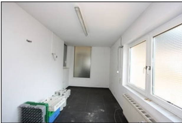
Abb.45 Ansicht Hauptgebäude EG
