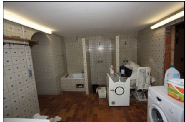
Abb.114 Ansicht Hauptgebäude KG, Wasch-/Duschraum
