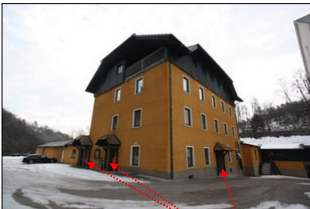
Abb.5 Ansicht Erschließung Liegenschaft, Vorplatz, Hauptgebäude Nordwestseite, Eingänge Nord, West
