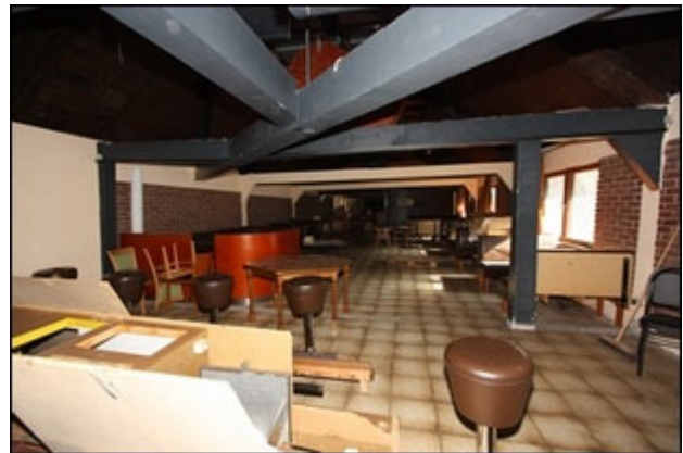
Abb.218 Ansicht Anbau Süd (EG), Teilfläche West, Saal
