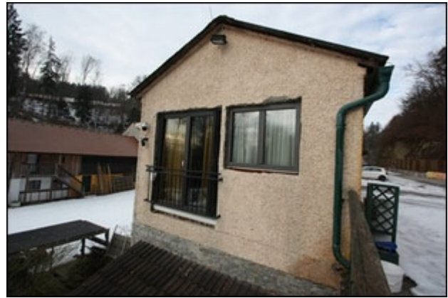
Abb.24 Ansicht Anbau Nordost, Ostseite (vgl. Abb.20/22)
