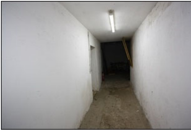
Abb.111 Ansicht Hauptgebäude KG
