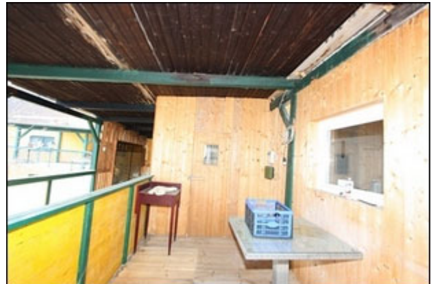
Abb.242 Ansicht Anbau Nordost (EG), Wohnung 1, Terrasse
