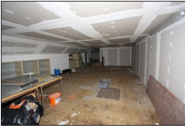
Abb.69 Ansicht Hauptgebäude 1.OG, Übergang Anbau Süd
