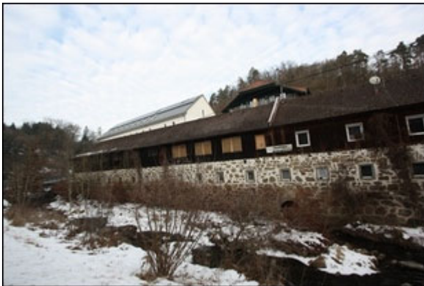
Abb.27 Ansicht Anbau Süd, straßen-/flusseitig (Große Gusen)
