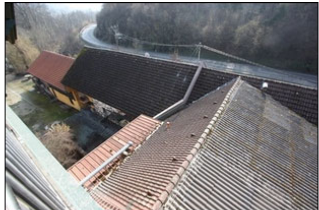
Abb.94 Ansicht Ausblick von der Loggia, Richtung Südosten
