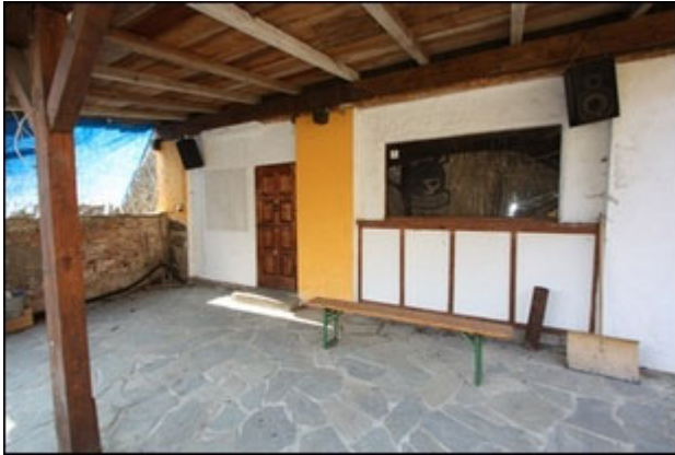
Abb.183 Ansicht Anbau Süd (UG), Teilfläche Ost, Flugdach, Zugang Bar
