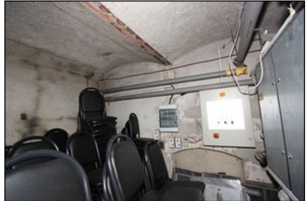
Abb.146 Ansicht Anbau Süd (UG), Teilfl. West (Lüftungszentrale)
