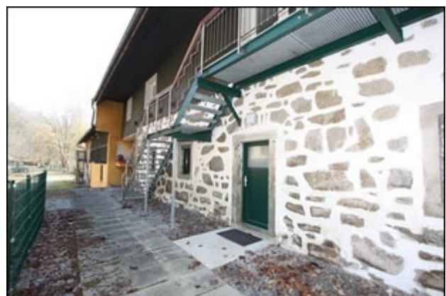
Abb.168 Ansicht Anbau Süd (UG), Teilfläche Ost, Hof
