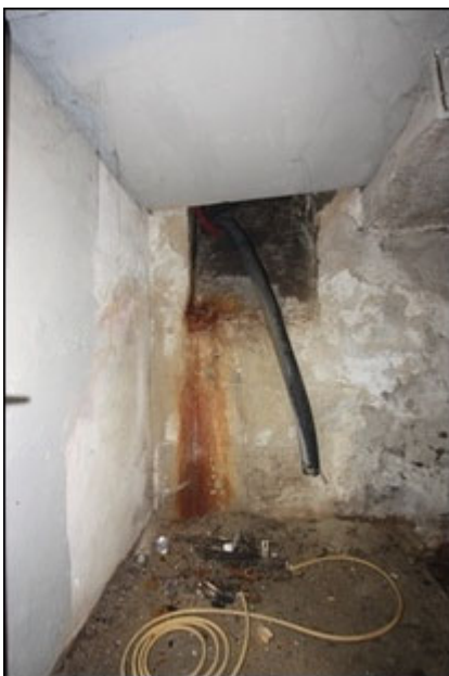
Abb.123 Ansicht Hauptgebäude KG
