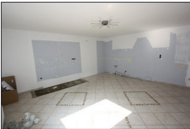
Abb.203 Ansicht Anbau Süd, Teilfl. Ost (EG), Betriebswohnung
