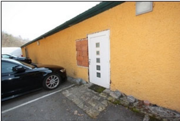
Abb.233 Ansicht Anbau Nordost (EG), Eingang Wohnung 1
