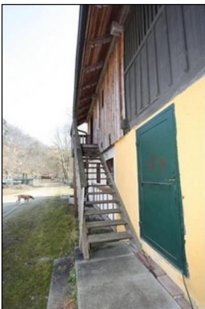
Abb.187 Ansicht Anbau Süd, Teilfläche Ost, Aufgang EG Ost
