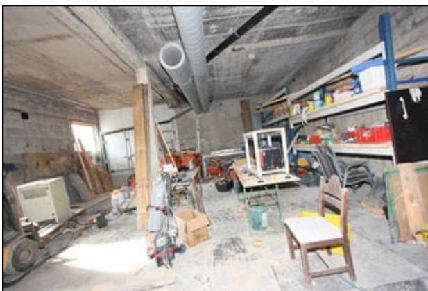
Abb.269 Ansicht Anbau Nordost (UG), Lager 2 (Werkstatt)
