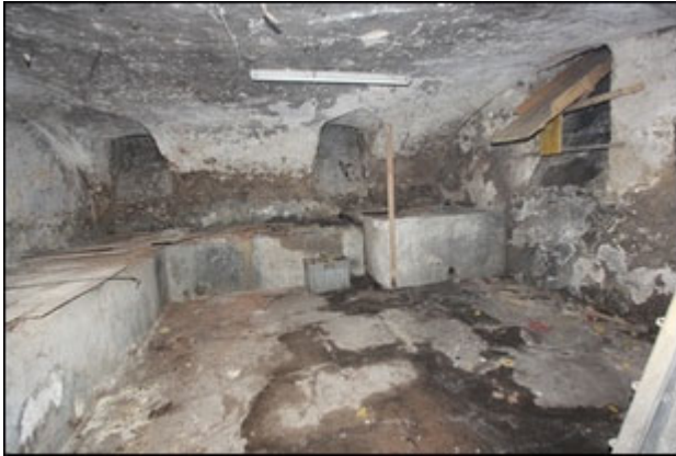
Abb.125 Ansicht Hauptgebäude KG, Raum Nordwest
