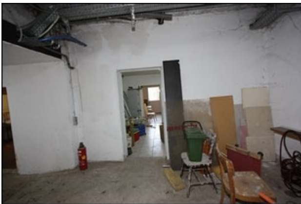
Abb.147 Ansicht Anbau Süd (UG), Teilfläche Mitte
