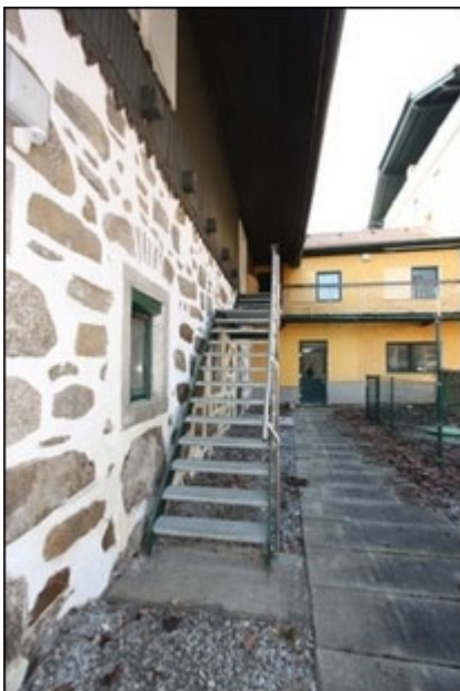
Abb.191 Ansicht Anbau Süd, Teilfl. Ost, Ausgang EG (Wohnung)
