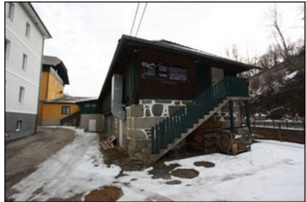
Abb.2 Ansicht Detail zu Abb.1, Anbau Süd, Teilabschnitt West im EG (hier OG): Saal (ehem. Saal mit Tanzfläche)
