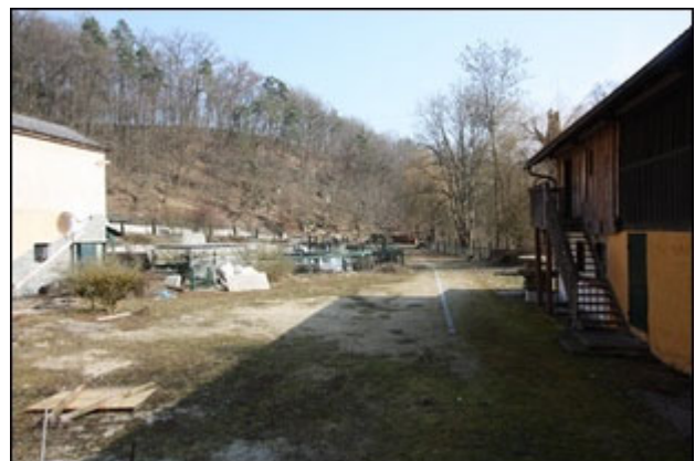
Abb.232 Ansicht Hof (Richtung Fischteich), Anbauten Nordost und Süd
