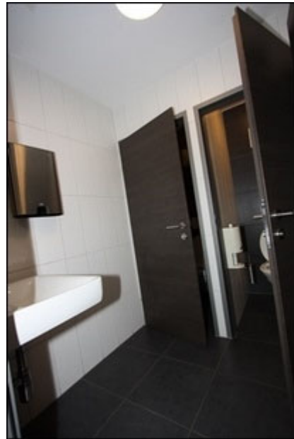
Abb.208 Ansicht Anbau Süd (EG), Teilfläche Mitte, WC-Anlagen
