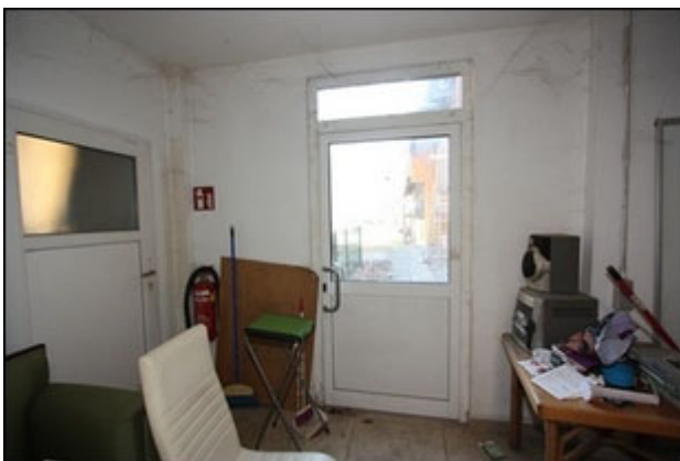
Abb.149 Ansicht Anbau Süd (UG), Teilfläche Mitte, Zugang Hof
