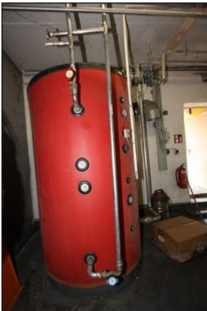
Abb.273 Ansicht Anbau Nordost (UG), Heizraum
