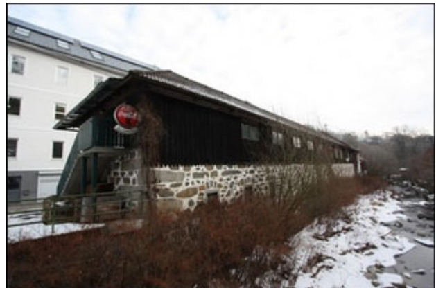
Abb.26 Ansicht Anbau Süd, straßen-/flusseitig (Große Gusen), Teilabschnitt West
