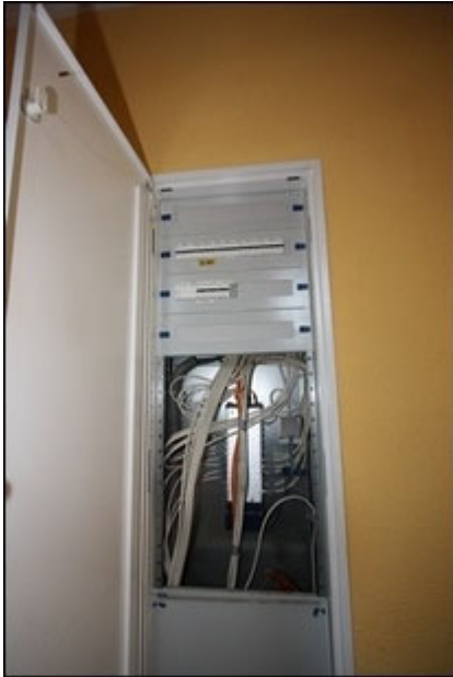
Abb.57 Ansicht Hauptgebäude 1.OG
