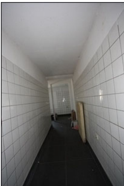
Abb.41 Ansicht Hauptgebäude EG
