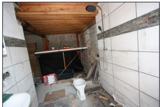
Abb.270 Ansicht Anbau Nordost (UG), Lager 2 (Werkstatt)
