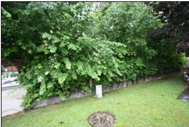
Abb.9 Ansicht nordostseitige Grundstücksgrenze/Einfriedung (vom nördlichen Nachbargrundstück ostseitig aus)
