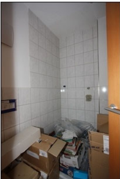
Abb.25 Ansicht Wohngebäude (UG), Bad/WC (nicht ausgebaut)
