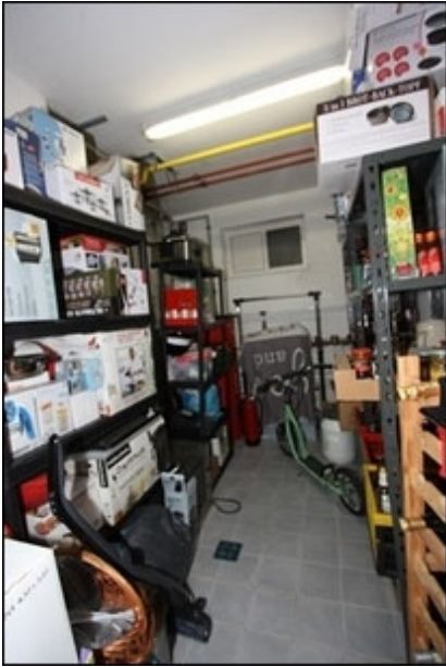
Abb.27 Ansicht Wohngebäude (UG), Technikraum
