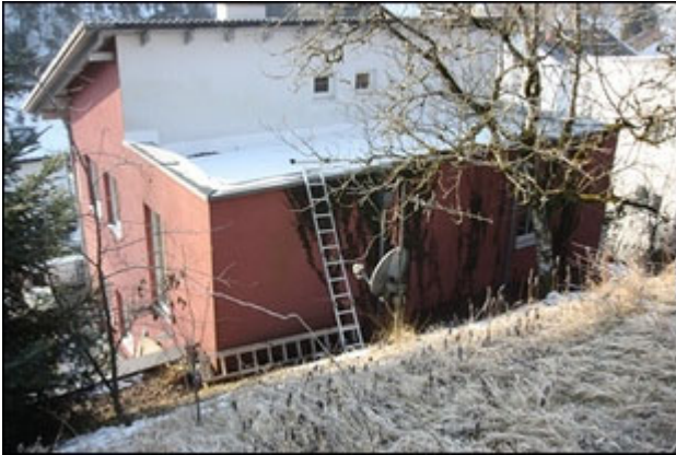
Abb.15 Ansicht Wohngebäude Nordseite Grundstücksteil Nord (Steilhang)
