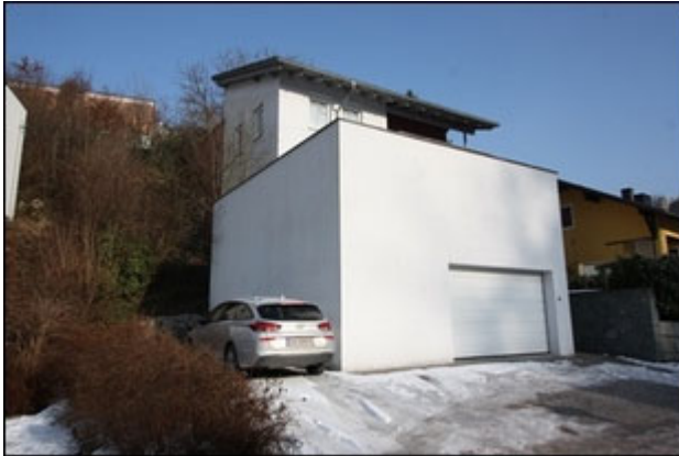
Abb.1 Ansicht Liegenschaft/Wohngebäude, Doppelgarage, Südwest- und Straßenseite, Zufahrt/Zugang (Doppelgarage mit Aufmauerung/Brüstungsmauer für Pool oder ggf. Terrasse)
