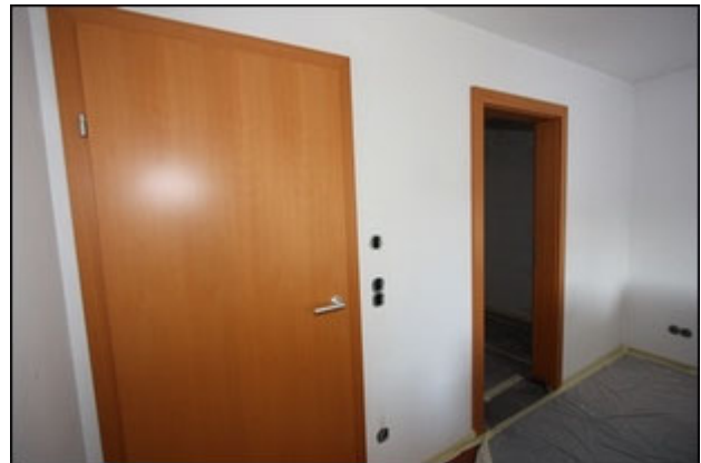
Abb.56 Ansicht Wohngebäude (DG), Zimmer 4 (Richtung Flur/Diele und Schrankraum)
