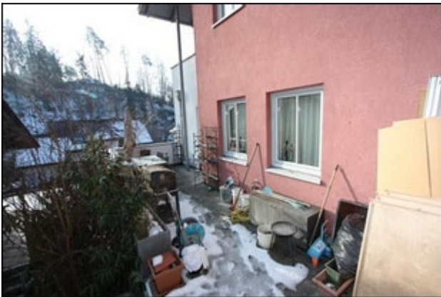
Abb.11 Ansicht Detail zu Abb.10, Terrasse Ost (EG)
