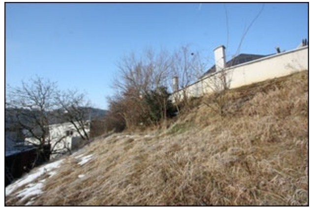
Abb.18 Ansicht Grundstücksteil Nord (Steilhang), westliche Teilfl. Grundgrenze Nord; östliche Teilfläche: Nachbargrundstück 1590/1 (Begrenzungsmauer am nördlichen Nachbargrundstück liegend)
