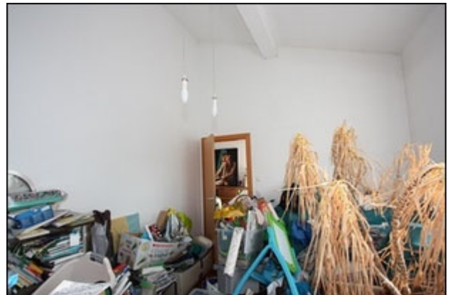
Abb.64 Ansicht Wohngebäude (DG), Zimmer 2
