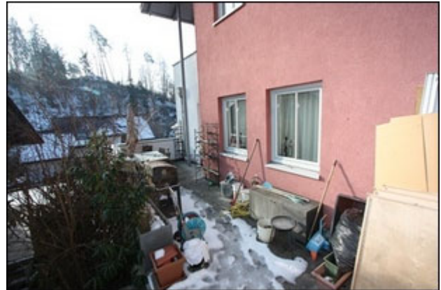
Abb.38 Ansicht Wohngebäude (EG), Terrasse Ost
