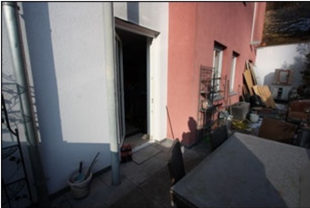
Abb.37 Ansicht Wohngebäude (EG), Terrasse Ost
