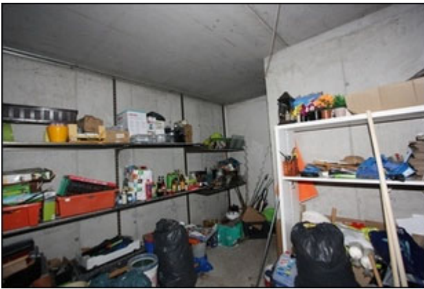
Abb.69 Ansicht Doppelgarage (Richtung Stiege)
