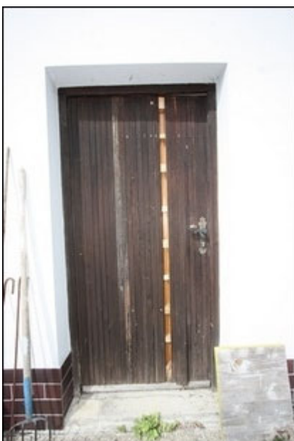
Abb.37 Ansicht Detail zu Abb.31, Kellertür
