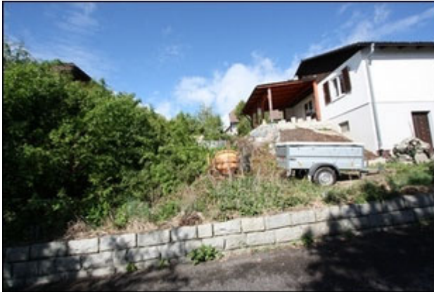
Abb.1 Ansicht Liegenschaft/Wohngebäude, Südostseite (Geländeaufschüttung im Bereich Garten/Terrasse)
