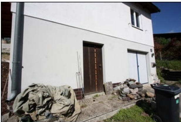
Abb.31 Ansicht Vorplatz, Wohngebäude KG
