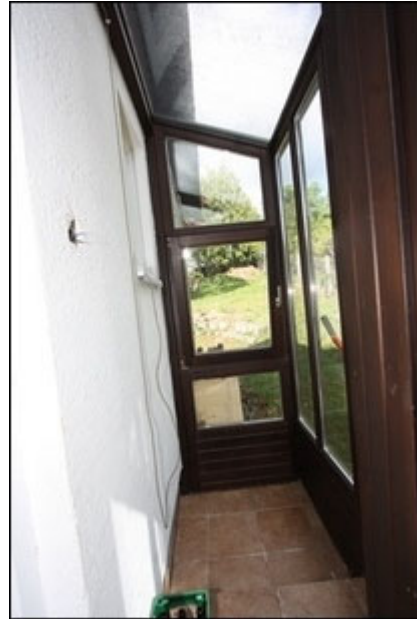
Abb.16 Ansicht Teilbereich Windfang (Anbau)
