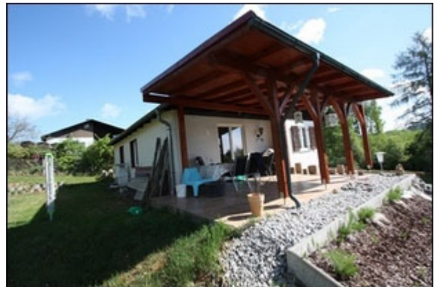
Abb.10 Ansicht Wohngebäude Südwestseite, Terrasse (Geländeaufschüttung)
