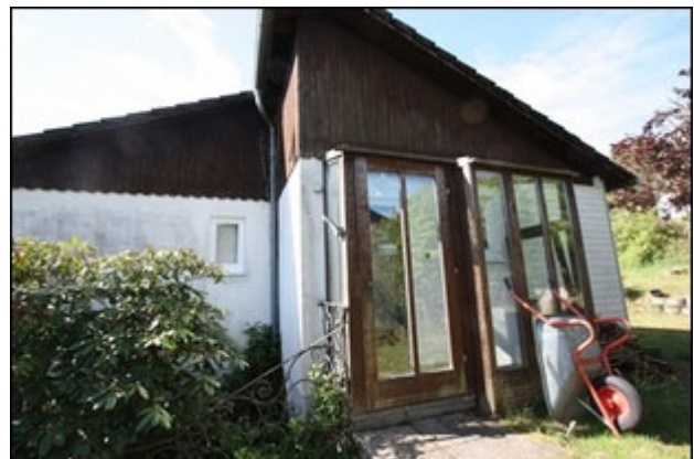
Abb.14 Ansicht Hauseingang/Anbau Windfang, vgl. Abb.6
