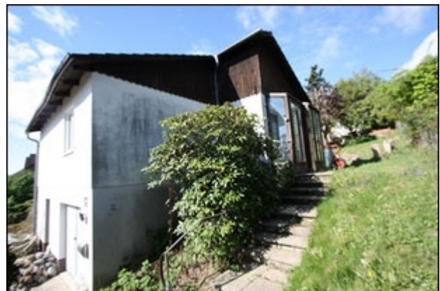
Abb.6 Ansicht Wohngebäude, Nordostseite, Aufgang zum Hauseingang
