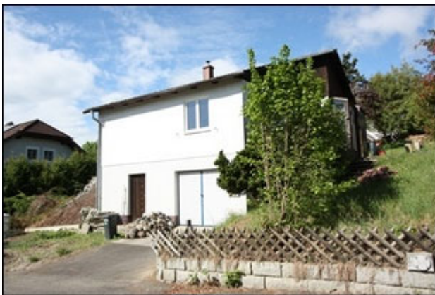
Abb.3 Ansicht Liegenschaft/Wohngebäude, Nordostseite (Geländeaufschüttung im Bereich Garten/Terrasse)
