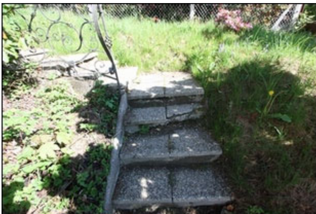
Abb.5 Ansicht Detail zu Abb.4, Zustand Außenstiege
