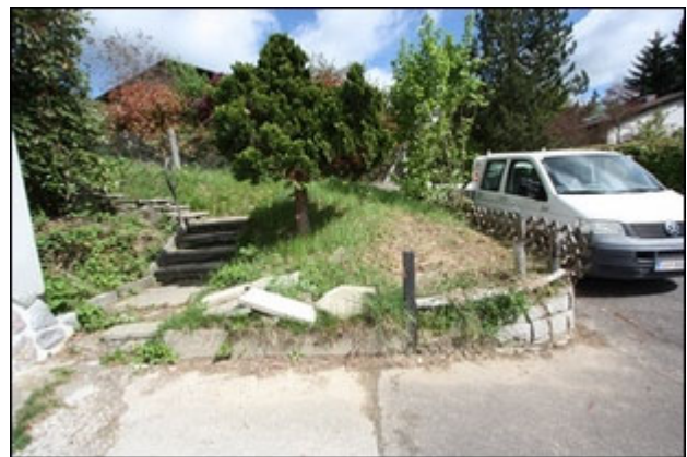
Abb.4 Ansicht Vorplatz, Hauszugang/Stiegenaufgang
