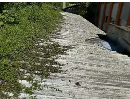
nördlicher Dachbereich von W24, Blechdach+Bituminöse Abdichtung
