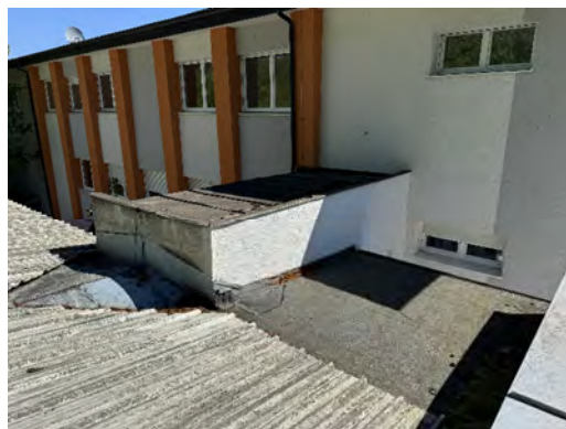
nördlicher Dachbereich von W24, Blechdach+Bituminöse Abdichtung
