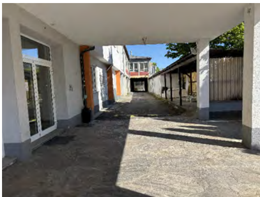
Gebäude östlich von W24
