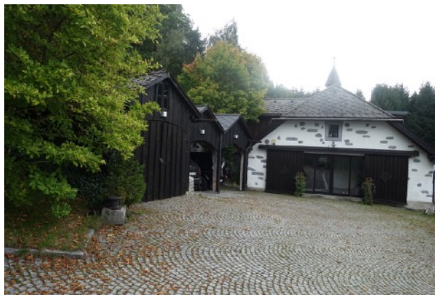
Schwimmbadgebäude mit Garage und Carports
