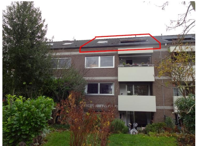
Gartenseitige Ansicht ( mit Markierung der Wohnung )
