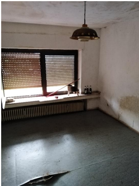
Lfd. Nr. 1 Dreifamilienhaus Wohnung EG rechts Raum
