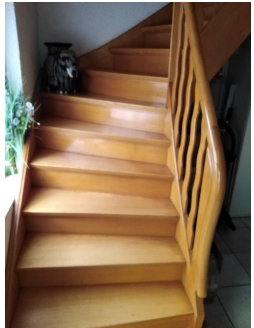
Lfd. Nr. 1 Dreifamilienhaus Treppe zum OG
