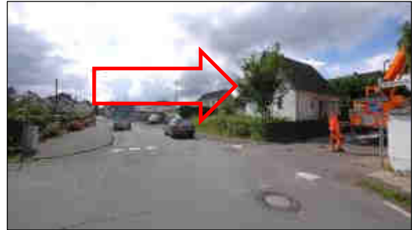
Bild 2: Blick in die Kirchheimer Straße mit Bewertungsgrundstücken
