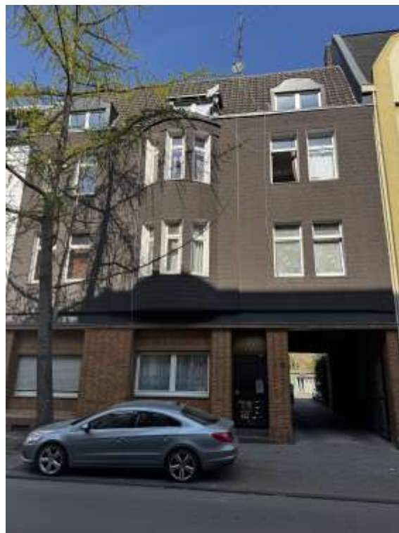
Bild 2: Zufahrtsbereich über die Wörthstr. 40
