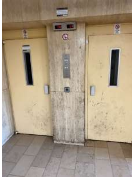
Bild 3: Eingangsbereich mit Fahrstühlen
