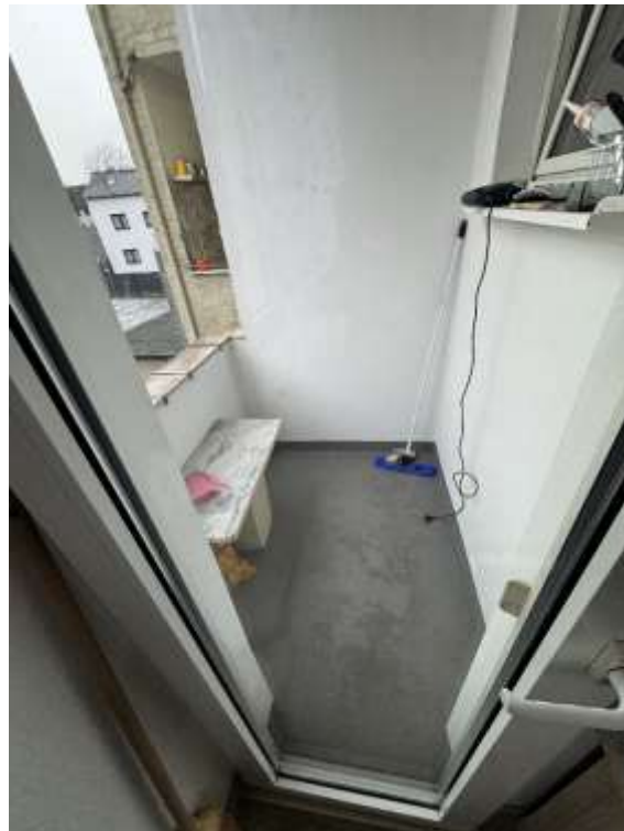
Bild 26: Innenansicht 1. OG links
