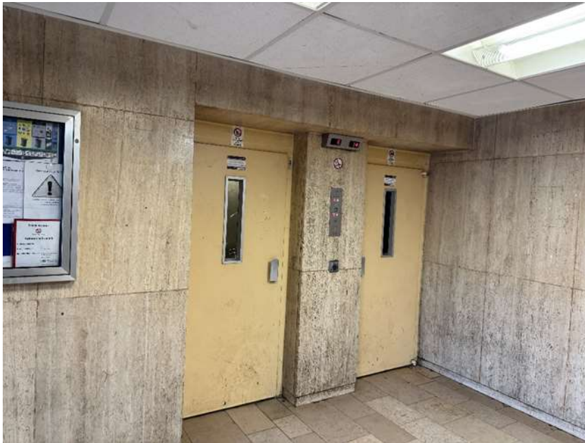
Bild 3: Eingangsbereich mit Fahrstühlen
