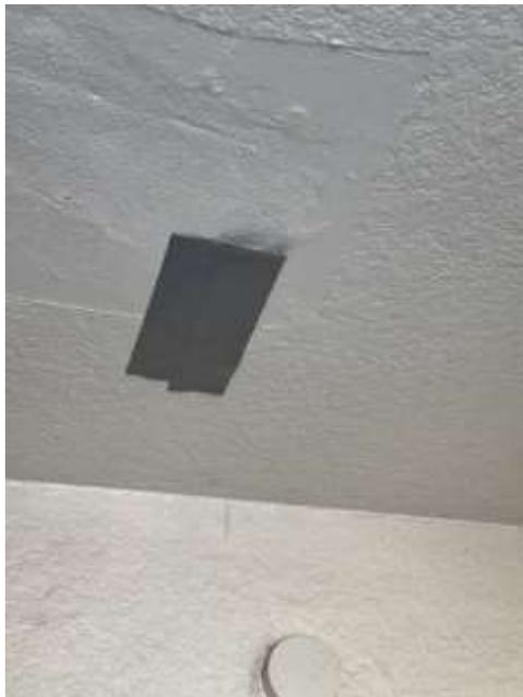
Bild 44: Schadensbild Badezimmer (zugeklebte Öffnung im Deckenbereich)
