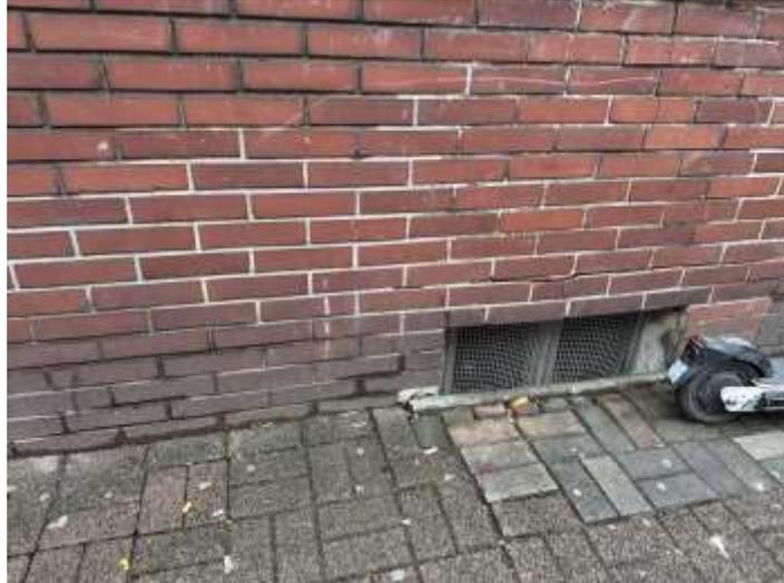
Bild 23: Schadenbild: Feuchtigkeitsschäden an der straßenseitigen Fassade
