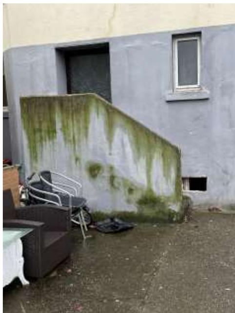
Bild 20: Schadenbild: Feuchtigkeitsmerkmale an der Außentreppe im Hof
