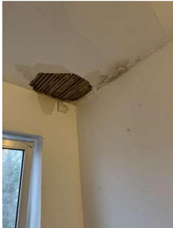
Bild 24: Schadenbild: Putz- und Anstrichschäden mit Feuchtigkeitsschäden im Treppenhaus
