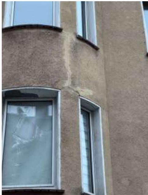
Bild 22: Schadenbild: Rissbildungen an der Fassade
