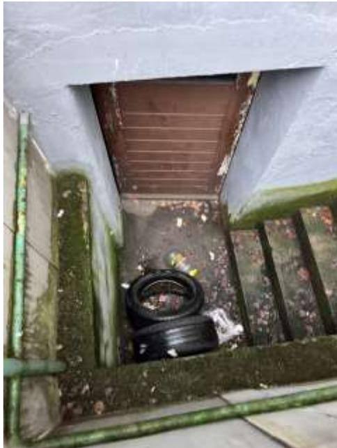
Bild 21: Unrat am Treppenausgang der Kelleraußentreppe, sowie Feuchtigkeitsmerkmale an Kelleraußenwand
