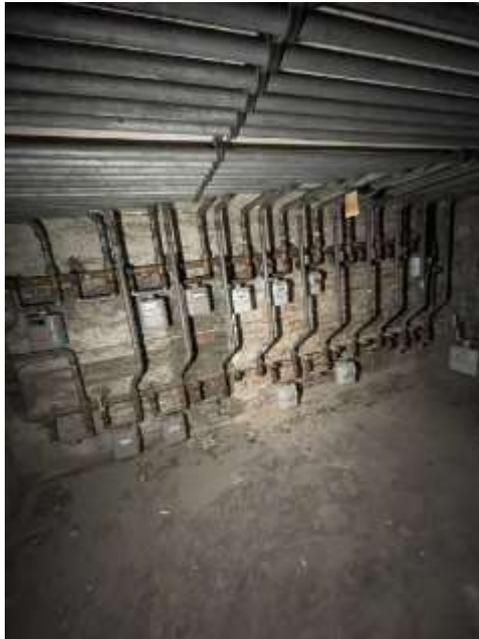
Bild 13: Innenansicht Keller Gasanschlüsse
