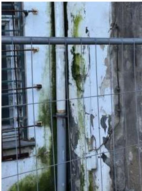
Bild 60: Schadenbild mit Feuchtigkeitsmerkmalen an der rückseitigen Fassade
