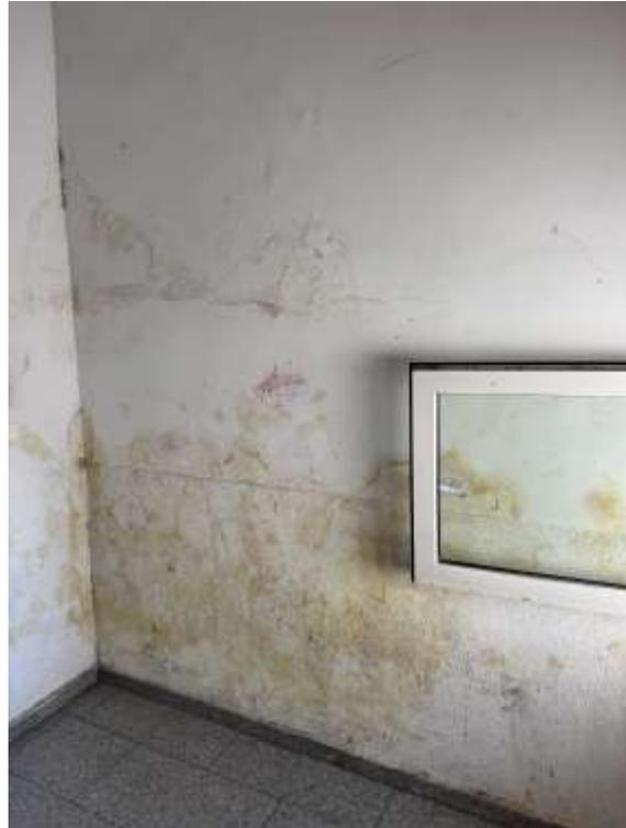
Bild 63: Schadenbild mit Feuchtigkeitsmerkmalen im Treppenhaus
