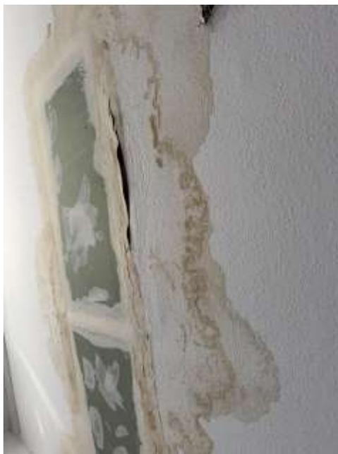
Bild 58: Schadenbild mit Feuchtigkeitsmerkmalen im Treppenhaus
