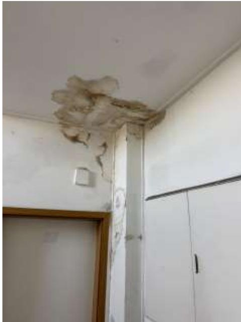
Bild 43: Innenansicht Treppenhaus mit Feuchtigkeitsmerkmalen im Deckenbereich
