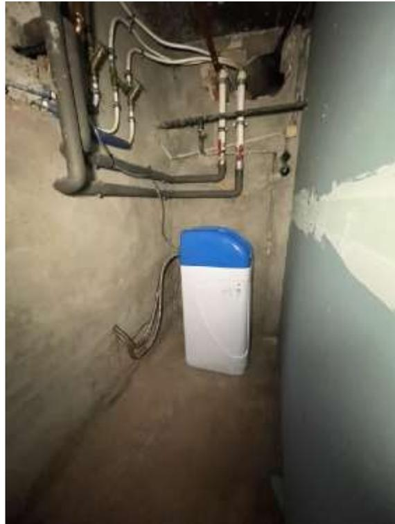
Bild 17: Innenansicht Keller mit Entkalkungsanlage des Restaurants
