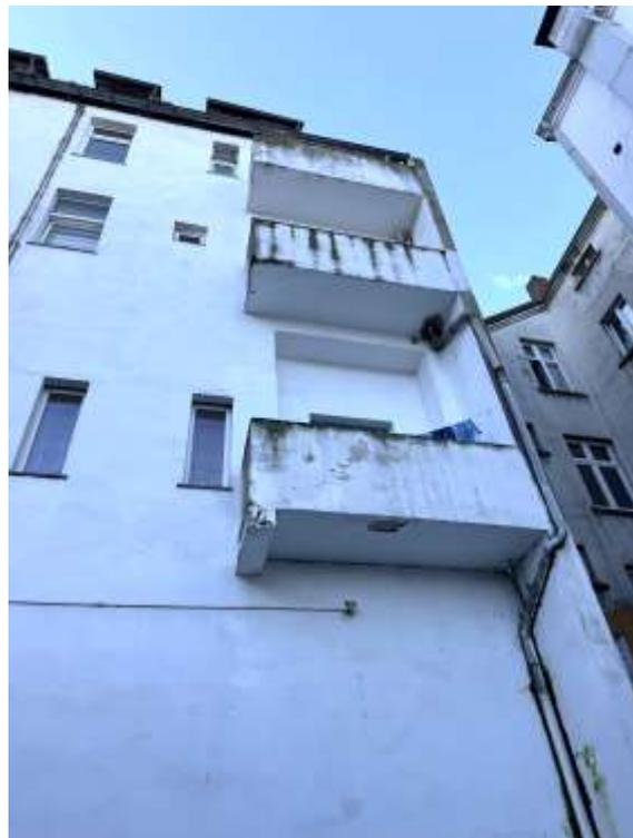
Bild 4: Rückansicht mit Putz- und Anstrichschäden
