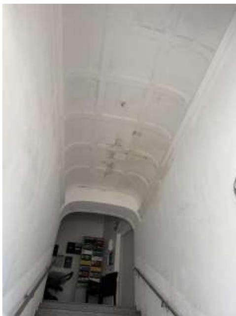
Bild 62: Schadenbild mit Feuchtigkeitsmerkmalen im Treppenhaus Eingang Weseler Str. 6
