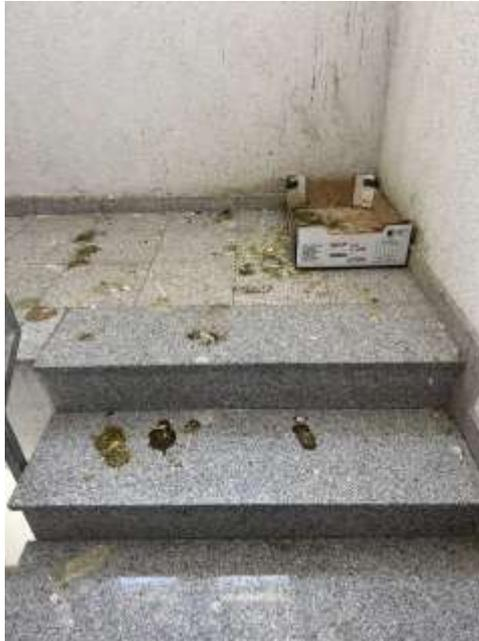
Bild 57: Schadenbild mit Taubenbefall des Treppenhauses
